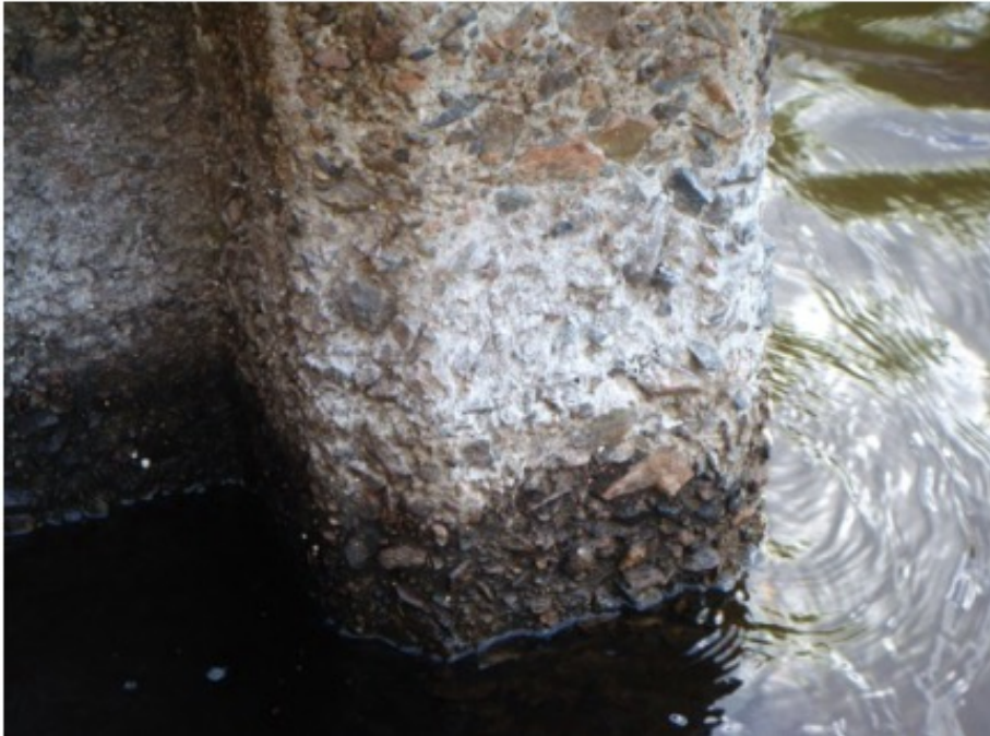
Jämn urlakning i kombination med frostangrepp vid vattenlinjen
