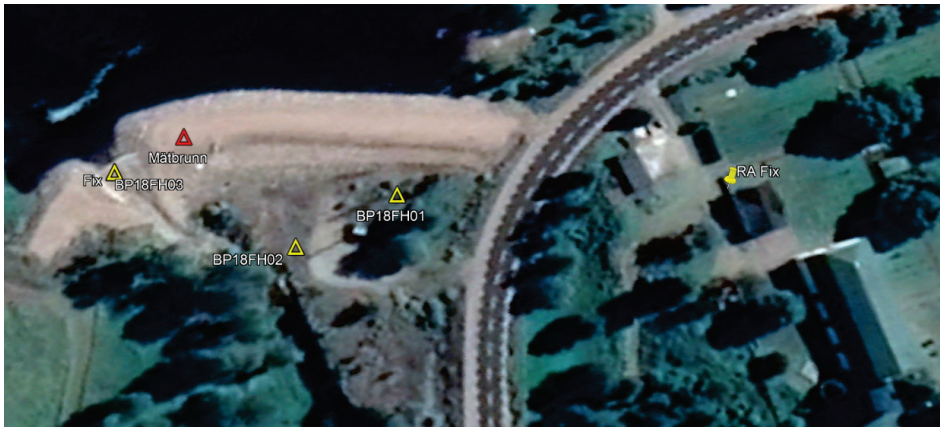
Figur 6-1. Ett stomnät vid en liten damm.
