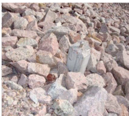
Figur 3- 2 Exempel på dubbar som används inom rörelseövervakning av fyllningsdammar.
