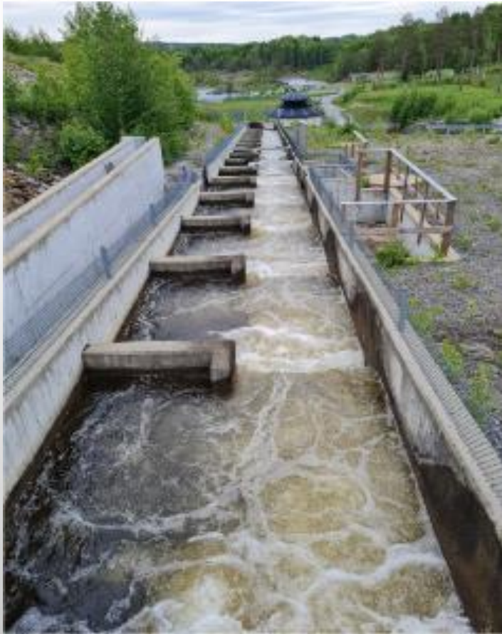
Umeälven – Stornorrfors Bassängtrappa – 275 m, 77 bassänger Fallhöjd ca 22 m
