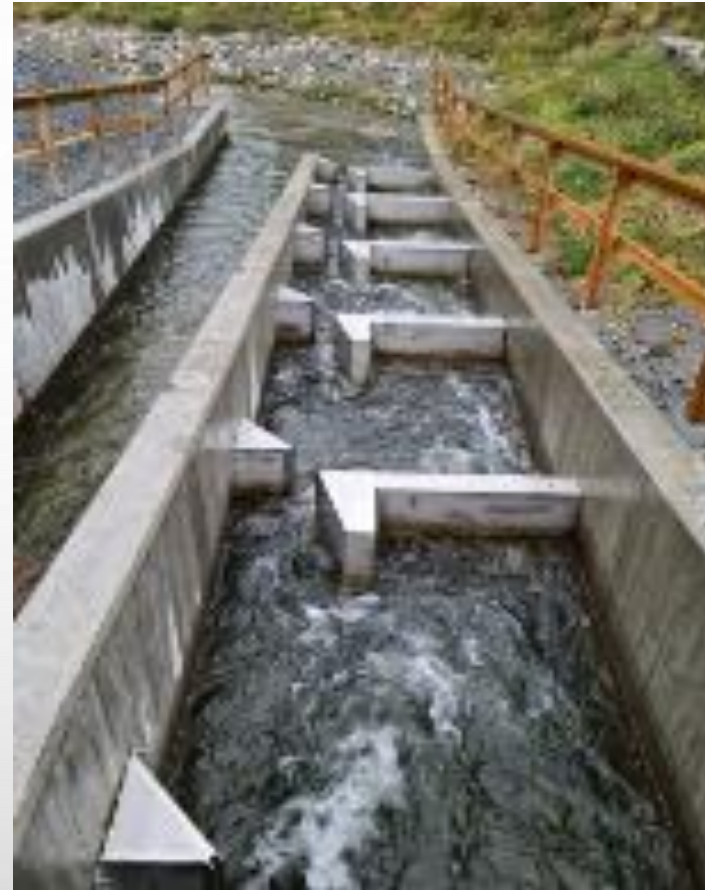
Billstaån – Näkten Slitsränna – ca 10m, 6 bassänger Fallhöjd ca 1,2 m
