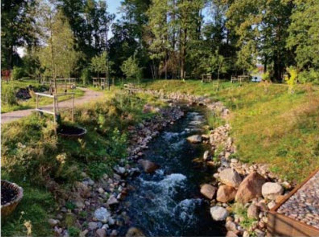
Stångån – Nykvarn Omlöp – 200 m i parkmiljö Fallhöjd – ca 2,8 m
