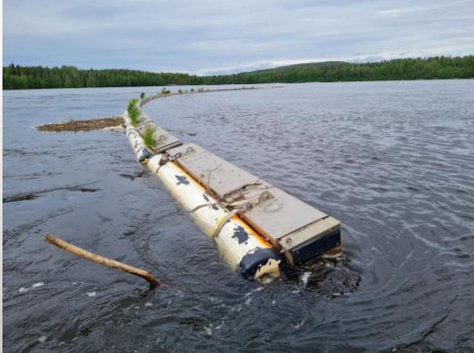
Umeåälven – Stornorrfor Ledarm – 110m och 1,8 m djup 22 sammankopplade flytelement
