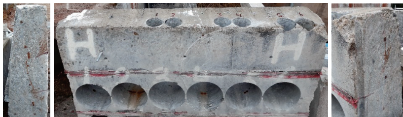
Figur 2.6. Utrivet betongblock där borkärnor uttagits för fogbandsstudie.
