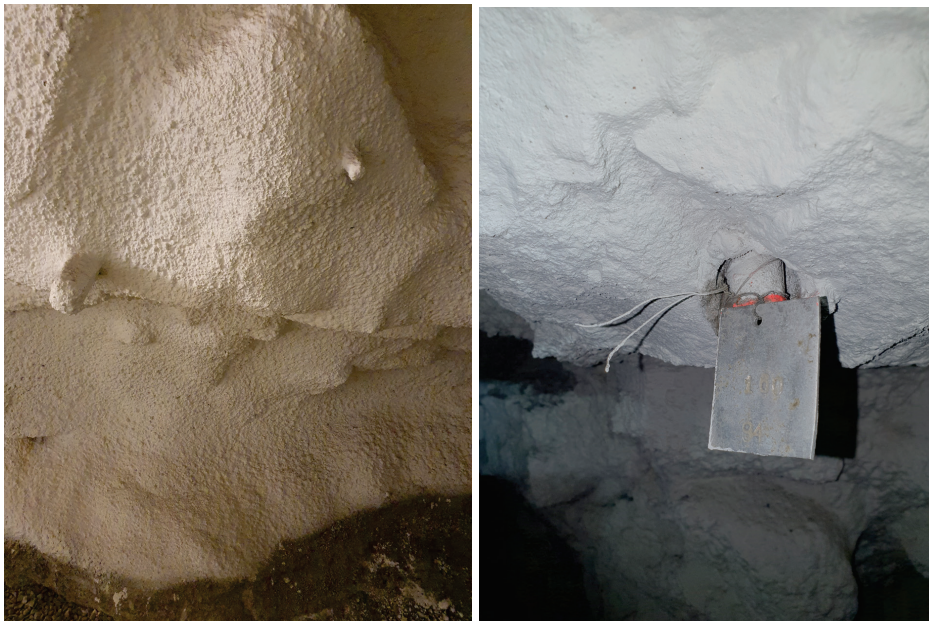
Figur A-10. Exempel bergkvalitet samt bergförstärkning i mindre utrymme i anslutning till maskinsal. Bergyta insprutade med målad sprutbetong. Ingjuten bult med årtal 94.
