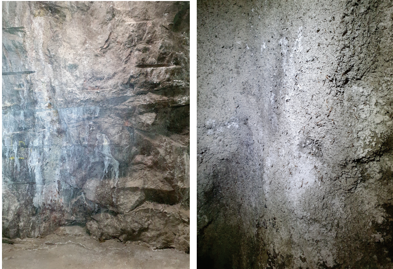
Figur A-7. T.v. Exempel på oförstärkt yta sugrörsgång. T.h. Exempel på yta förstärkt med fiberarmerad sprutbetong sugrörsgång.
