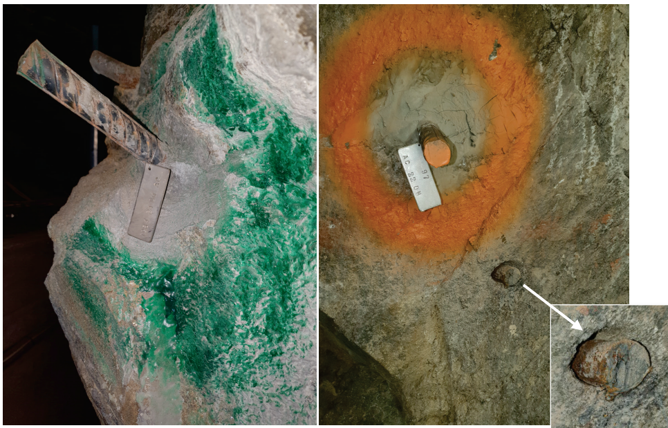
Figur A-14. Exempel på kompletterande bult i utrymme i anslutning till maskinsal. Ingjutet kamjärn, tag märkt med årtal 1984 respektive 97.
