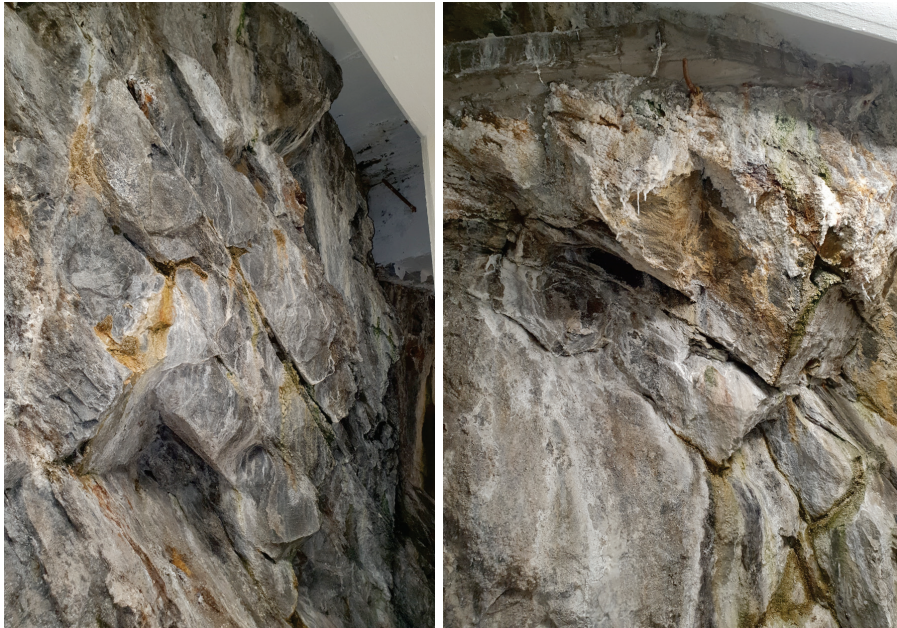
Figur A-15. T.v. Exempel på områden med relativt få bergbult till trots de ogynnsamma strukturerna som stupar in mot bergrummet. Maskinsal, turbinplan.
