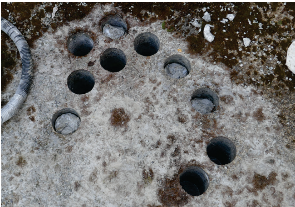
Figur 6. Hissmofors. Avslutat borrhingsarbete för uttag av betongkärnor från skibordet i utskov 1. Notera att alla kärnor inte borrades till fullt djup eftersom arbetet avbröts om armeringsjärn påträffades.
