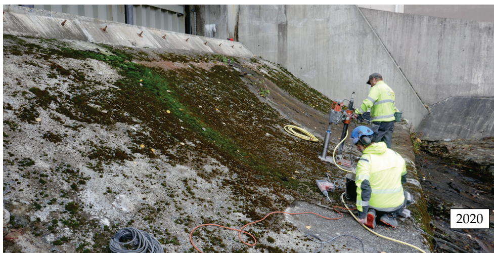
Figur 5. Hissmofors. Pågående utborrning av tio betongkärnor från den nedre delen av skibordet i utskov 1.
