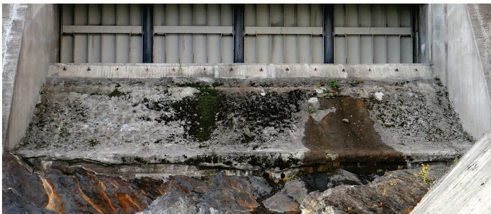
Figur 14. Hissmofors. Utskov 1. Utseendet hos skibordet i samband med utbörning av betongkärnorna.
