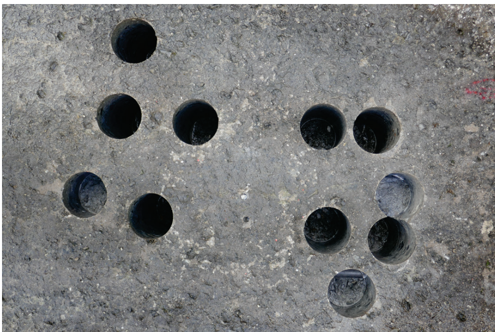
Figur 13. Kattstrudeforsen. Skibordet i utskov 2 efter avslutat borrarbete för uttag av betongkärnor. Notera att alla kärnor inte borrades till fullt djup eftersom arbetet avbröts om armeringsjärn påträffades.
