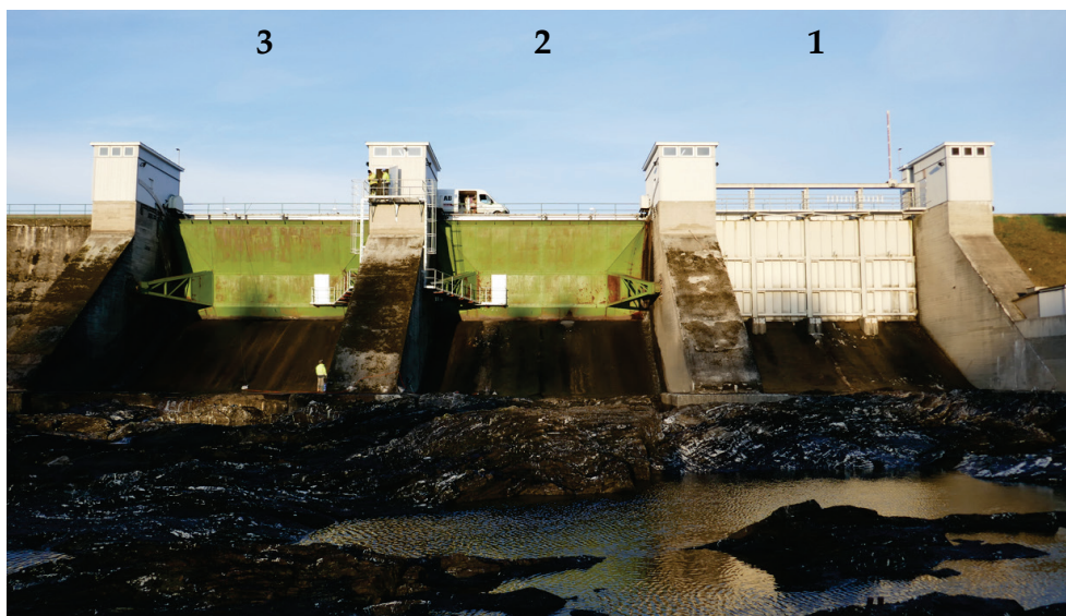
Figur 3. Kattstrupeforsens kraftverk. Vy över utskovsdammens nedströmssida. De tre utskoven numreras 1 till och med 3. Till höger i bild ansluter utskovsdammen mot en jorddamm och till vänster mot en betongdamm.
