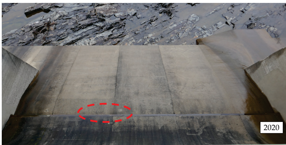
Figur 10. Kraftverk 2. Inringat område strax ovanför kantskoningen markerar platsen för 1996 års uppföljning och för de tio betongkärnorna som borrades ut från skibordet i utskov C i 2020 års uppföljning.
