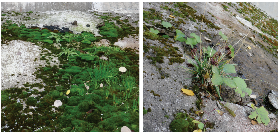
Figur 15. Hissmofors. Utskov 1. Mossa och andra sorters växtlighet förekommer på stora delar av skibordet.
