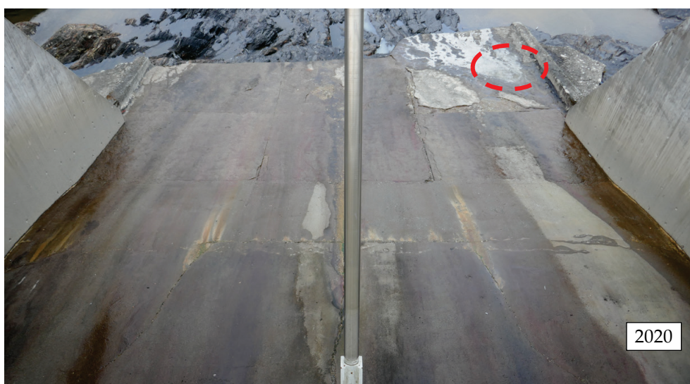
Figur 7. Hissmofors. Inringat område markerar platsen för de tio betongkärnorna som borrades ut från den nedre delen av den sprutbetongbelagda skibordsförlängningen i utskov 5 år 2020.
