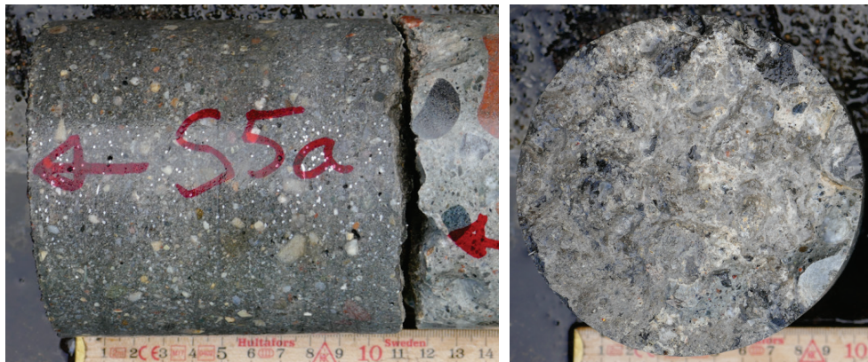
Figur 35. Kraftverk 2. Utskov C. Knäckning av betongkärnan skedde i den övre millimetern av konstruktionsbetongen (t.v.). Ljusbruna partier indikerar att betongen har försvagats av genomsippande vatten (t.h.).
