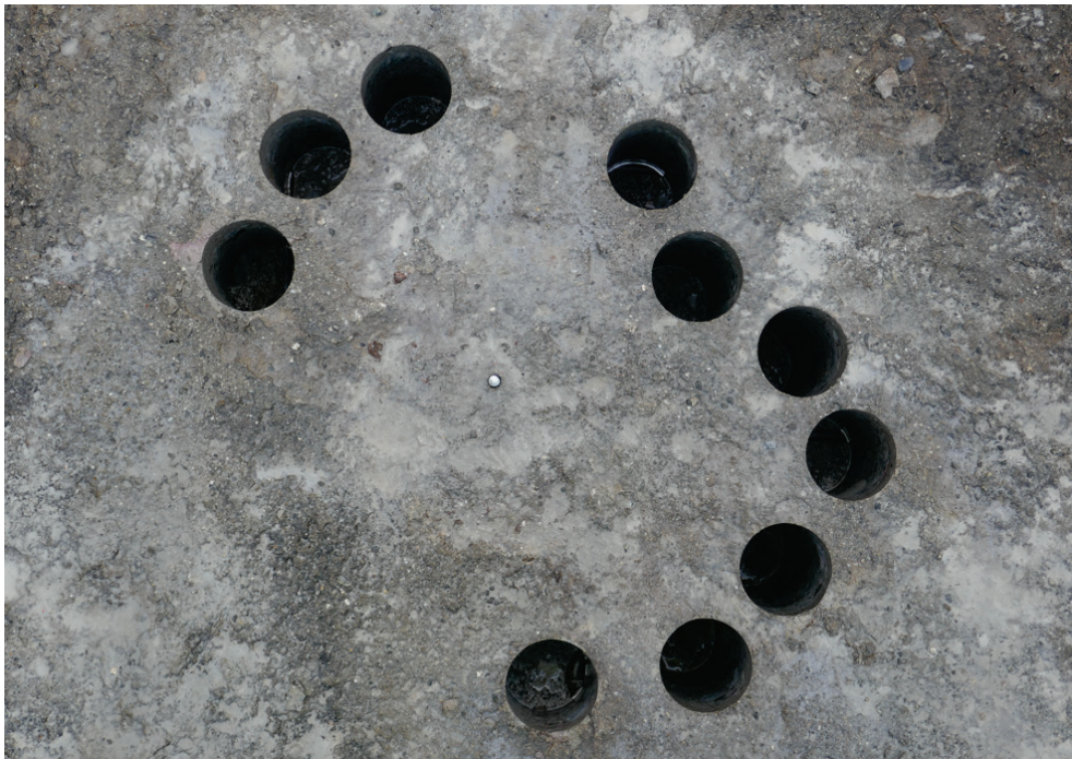
Figur 9. Hissmofors. Avslutat borrningsarbete för uttag av betongkärnor från skibordsförlängningen i utskov 5. Notera att alla kärnor inte borrades till fult djup eftersom arbetet avbröts om armeringsjärn påträffades.
