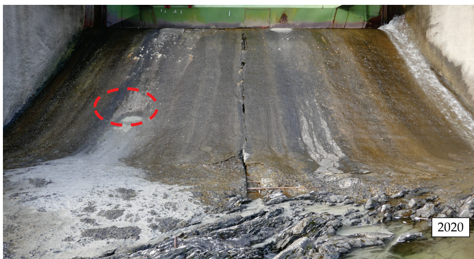
Figur 12. Kattstrudeforsen. Inringat område markerar platsen för elva betongkärnor från skibordet i utskov 2.
