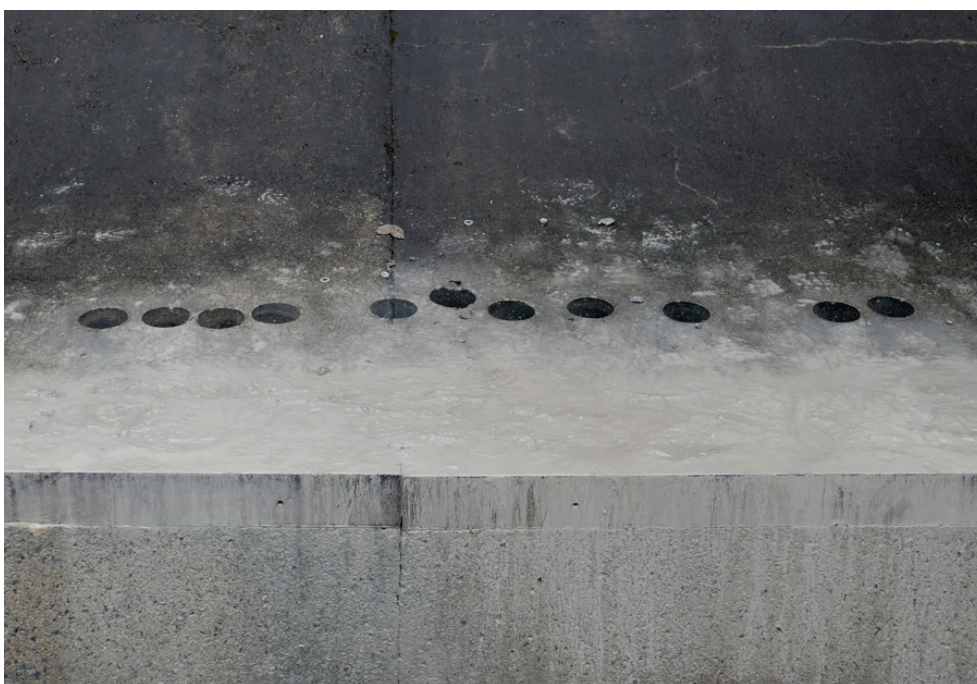
Figur 11. Kraftverk 2. Avslutat borrningsarbete för uttag av betongkärnor från skibordet i utskov C.
