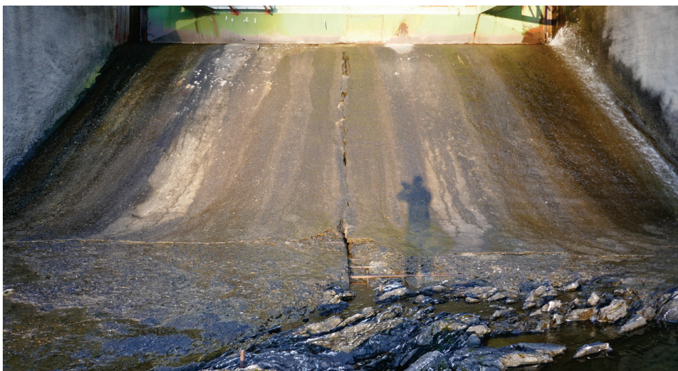
Figur 38. Kattstrupeforsen. Utskov 2. Utseendet hos skibordet i samband med utbörning av betongkärnorna.
