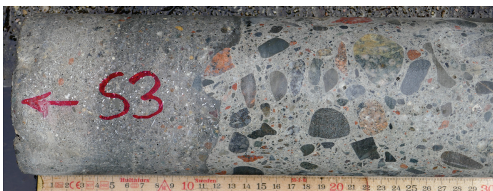
Figur 33. Kraftverk 2. Utskov C. Sprutbetongen har lagts på i två påslag om cirka 70 + 40 mm.
