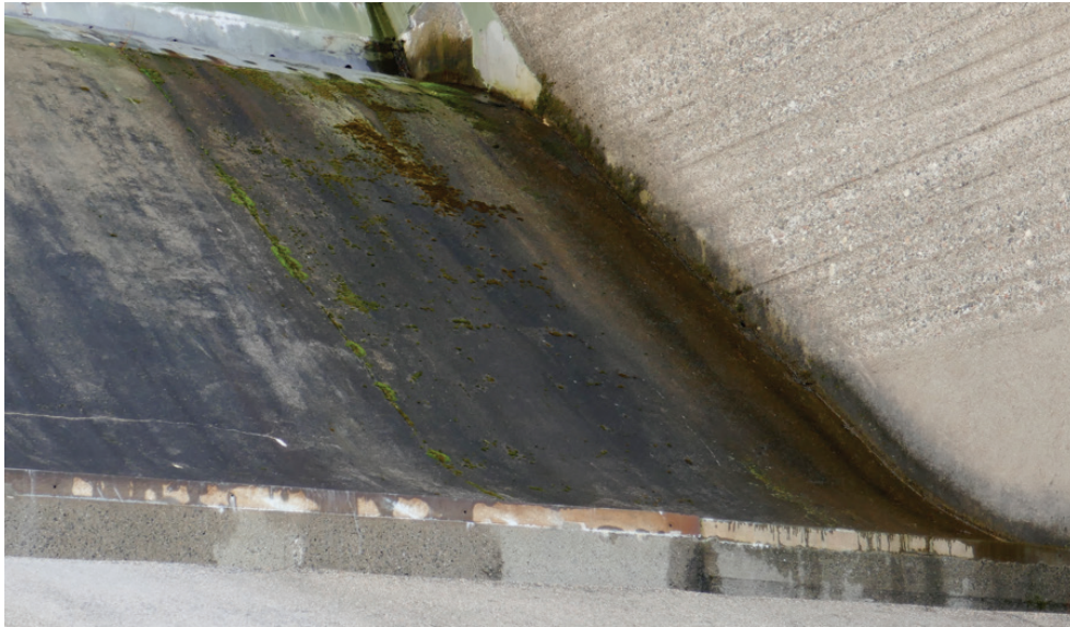
Figur 30. Kraftverk 2. Utskov C. Mossa växer på skibordet intill vänster pelare där skugga vanligtvis råder.
