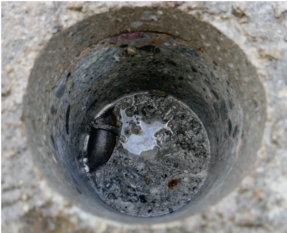
Figur 8. Hissmofors. Borrningsarbetet avbröts om armeringsjärn påträffades.
