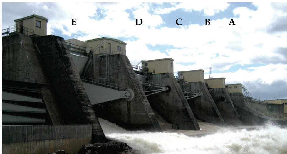
Figur 2. Kraftverk 2. Vy över nedströmssidan av utskovsdammen. De fem utskoven benämns A till och med E. Längst bort till höger i bilden syns en del av kraftverksbyggnaden.
