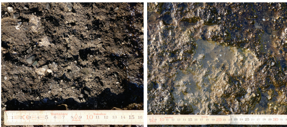
Figur 39. Kattstrupeforsen. Utskov 2. Skrovlig yta (t.v.). Tunna släppor förekom (ljus kulör t.h.).
