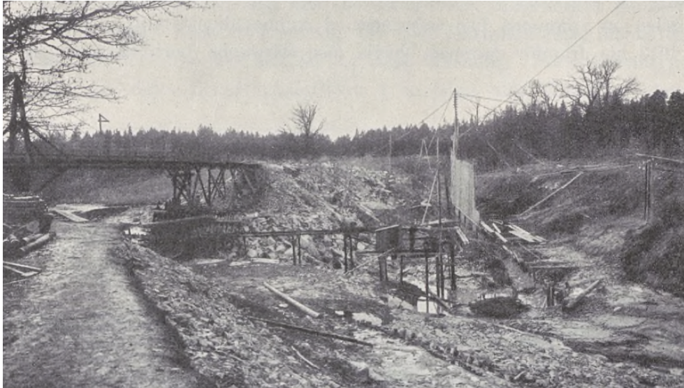
Figur 3.63 Spontning vid "avstängningsdamm" från tidigt 1900-tal (Kungliga vattenfallsstyrelsen, 1916).
