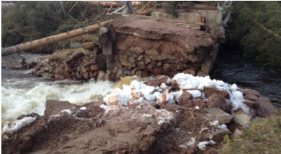
Figur 3.70 Haveriöppning med utfyllnadsmassor. Foto taget från vänster fyllningsdamm.
