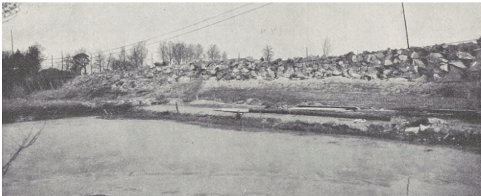
Figur 3.58 Påförda stenmassor för att framkalla sättningar i grunden (Kungliga vattenfallsstyrelsen, 1916).
