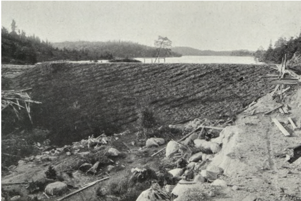
Figur 3.45 Foto från byggtiden. Nedströmsvy (Kungliga vattenfallsstyrelsen, 1910).
