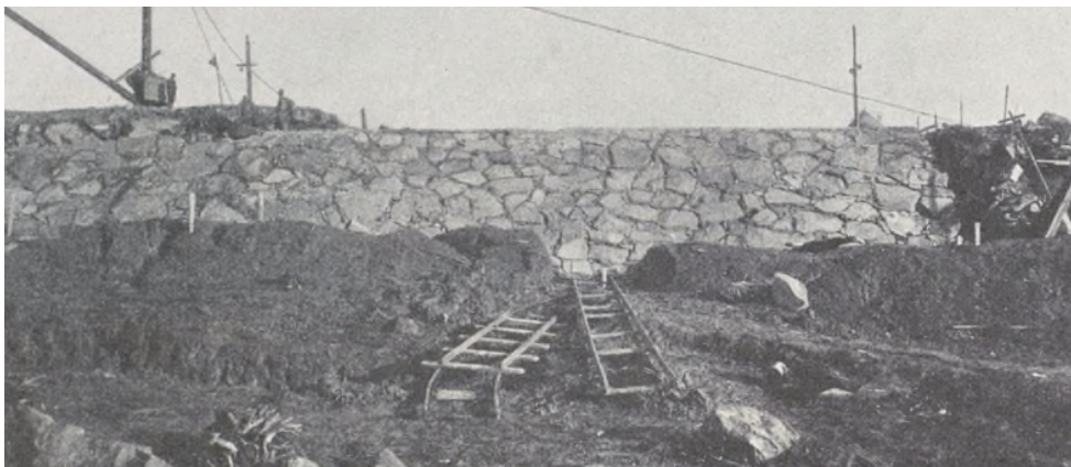
Figur 3.59 Glacisbklädd uppströmsslänt.
