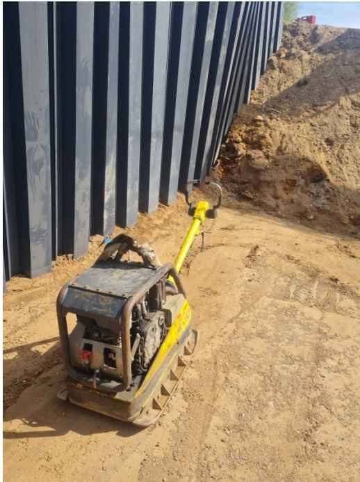
Figur 3.20 Plastspont installerades i stället för träspont. Foto: Mats Lund.
