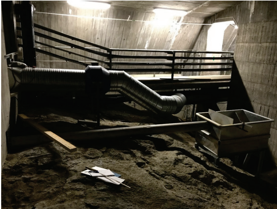
Figur 4—3 Läckageuppsamling med mätöverfall vid en svensk betongdamm
