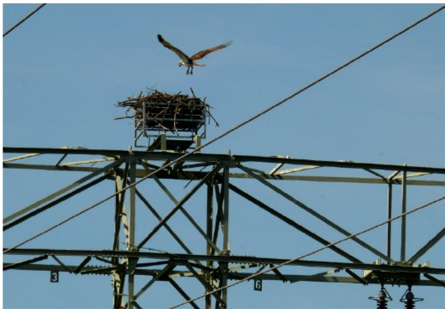
Figur 14. Exempel på typ av plattform som kan byggas ovanpå kraftledningstorn (Canario & Prinsen, 2011)
