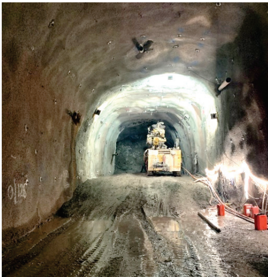
Figur 3-14 Utloppstunneln uppströms rasområdet efter installation av kompletterande förstärkning (foto SWECO)
