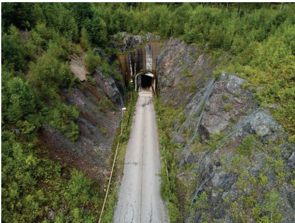
Figur 3-6 Portal till kraftstationens tillfartstunnel. Svalltunneln, som ansluter till tillfartstunneln, användes som tillfartsväg till rasområdet i samband med reparationsåtgärderna (foto SWECO)
