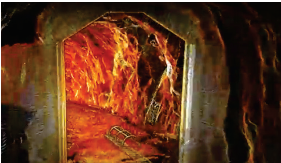
Figur 3-10 Anslutning mellan tillfartstunnel och svalltunnel, animering av skanning utförd med drönare (AMVKO i samarbete med Scior Geomanagement och Ängelholms Geodesi).
