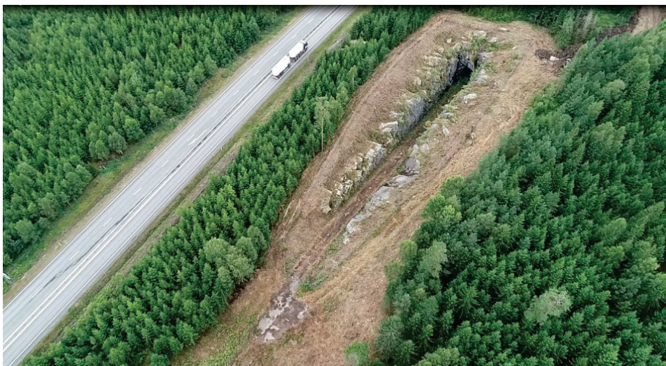
Figur 3-5 Flygfoto över mellanpåslaget efter röjning (foto Ängelholms Geodesi).
