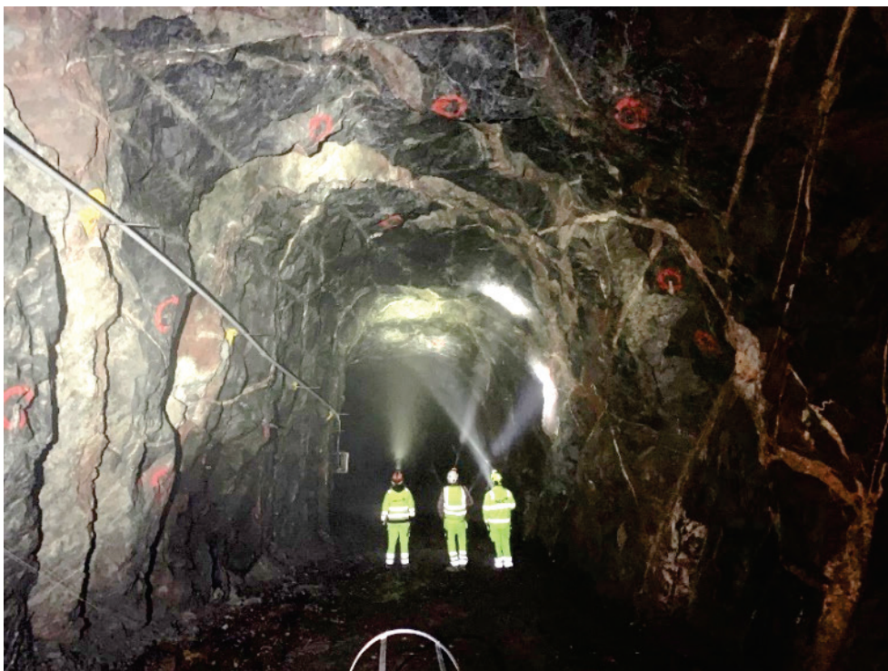
Figur 3-12 Platsbesök i svalltunneln under oktober 2020 (foto SWECO)
