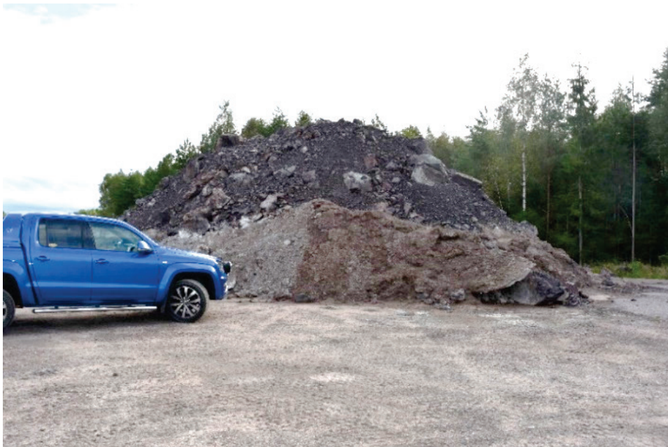
Figur 3-27 Upplag med massor som lastats ut från tunneln (foto SWECO)
