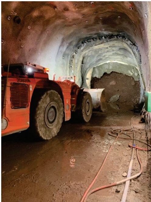
Figur 3-24 Utlastning av rasmassor (foto SWECO)
