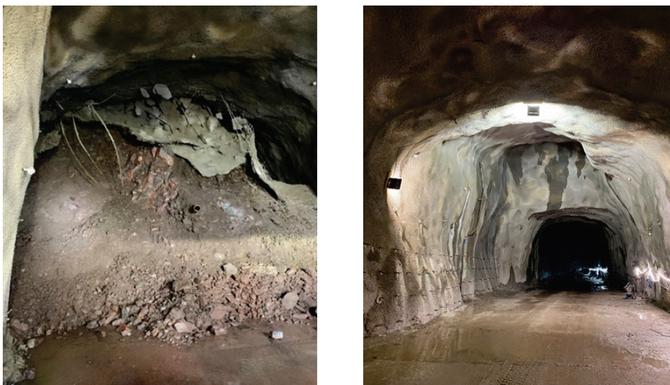
Figur 1-1 Aktuell tunnelsektion före och efter utlastning av rasmassor
