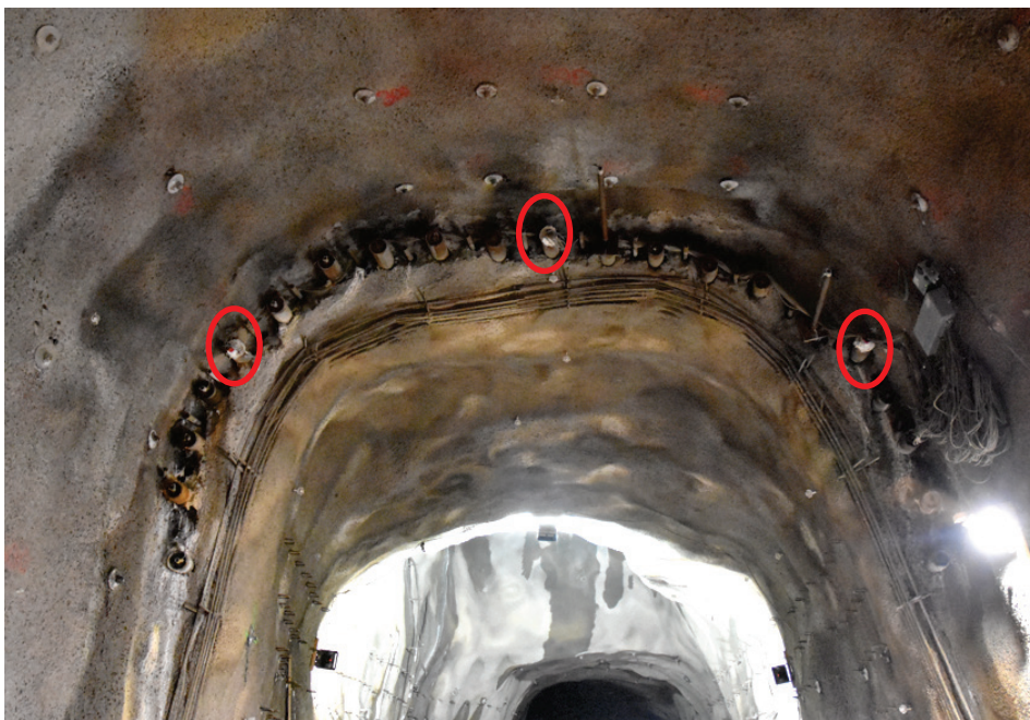
Figur 3-19 Foto som visar installerade spilingrör där inklinometrarna kan observeras i rör i hjässan och anfangen (foto SWECO)
