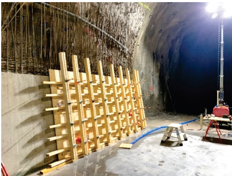
Figur 3-29 Gjutning av nedre delen av väggen (foto SWECO)
