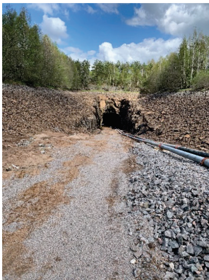
Figur 3-3 Utloppstunnelns mynning sedd från utloppskanalen (foto SWECO)
