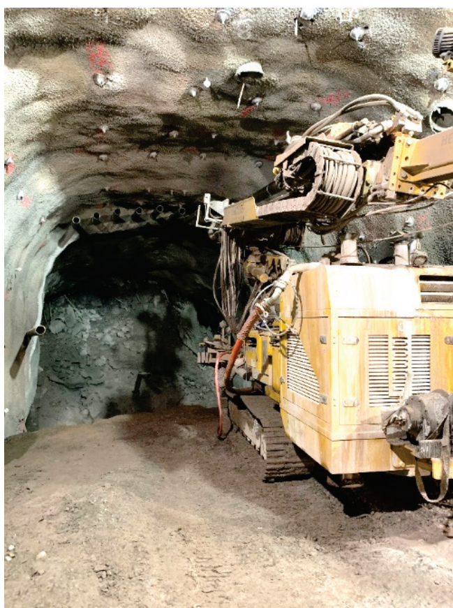
Figur 3-16 Installation av spilingrör påbörjades i mars 2021 (foto SWECO)
