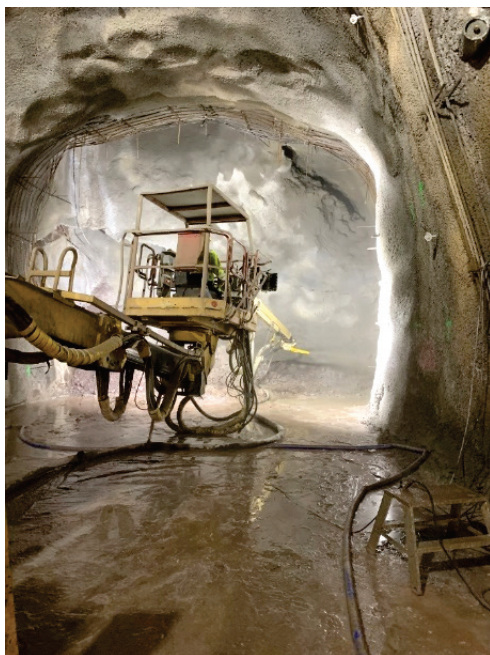
Figur 3-22 Installation av sprutbetong efter utlastning av rasmassor (foto SWECO)
