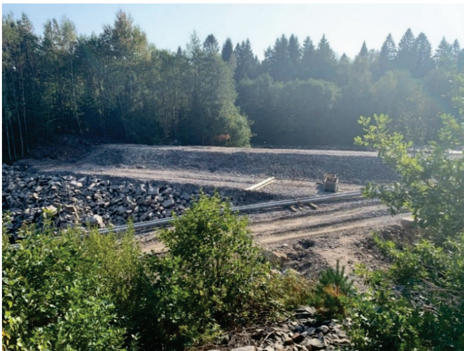
Figur 3-4 Fångdammen vid utloppskanalens utlopp (foto SWEKO)
