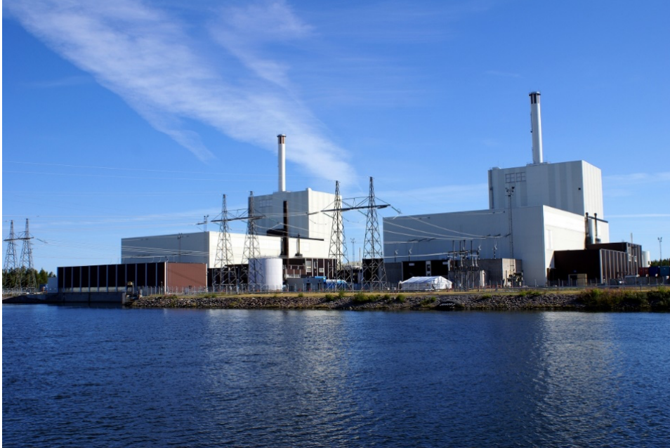
Figur 4. Forsmark kärnkraftverk (bild tagen från Vattenfalls webbplats)
