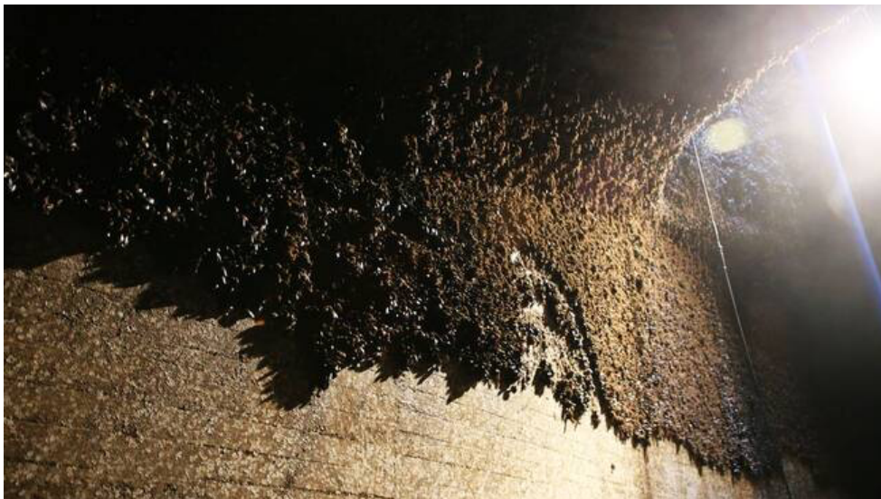
Figur 8. Den nedre delen av betongväggen är rengjord med vattenkanon. Foto: Ringhals
