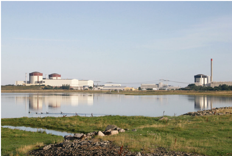
Figur 3. Ringhals kärnkraftverk (bild tagen från Vattenfalls webbplats)
