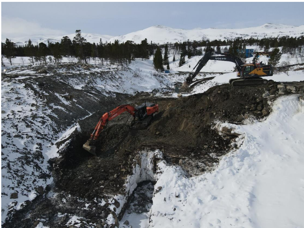
Figur 3.5 Schaktarbeten vid bottenutskovet på dammen nedströms sida.
