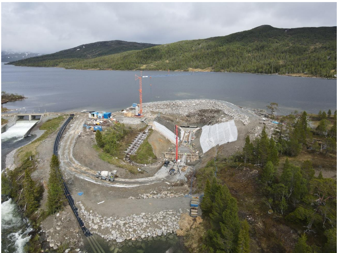
Figur 2.3 Dammanläggningen i Burvattnet vid dammprojektet.
