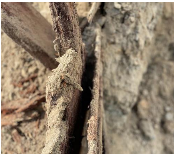
Figur 6 Närbild spont, uppströms
