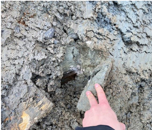
Figur 21 Organiskt material från byggnationen av dammen påträffades i schaktlinjen, handsågat plank som var intryckt i schaktlinjen
