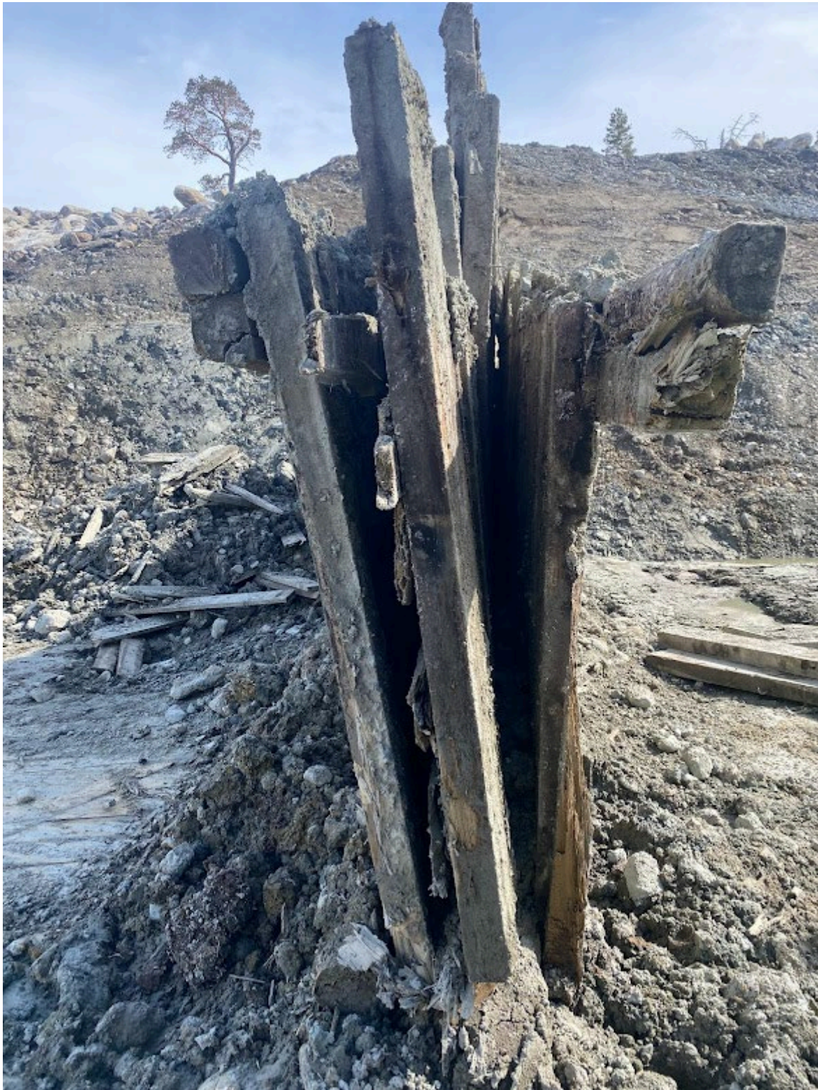
Figur 3d. Centrala delen av sponten samt kulverttak.
