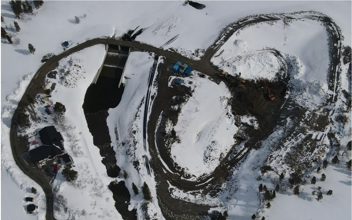
Figur 8a. Fotografiet visar t.ex. uppströms fångdamm, ytutskovet med två utskovsluckor, tillfälligt hävertutskov (svarta rör) samt pågående schaktarbeten.
