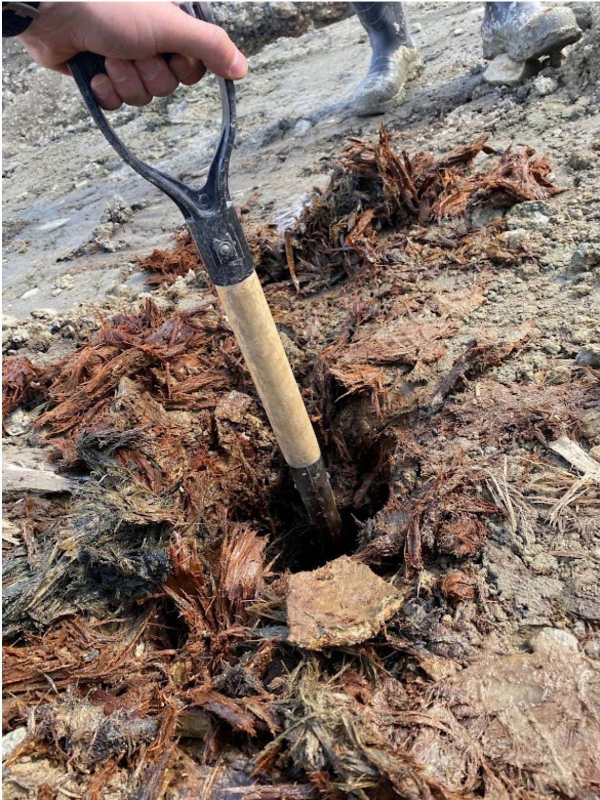
Figur 4b. Kulverttak, nedströmssida.
