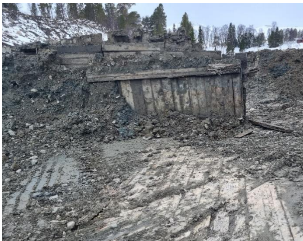
Figur 9 Spont i dammlinjen möter kulvert, bild är tagen uppströms ifrån
