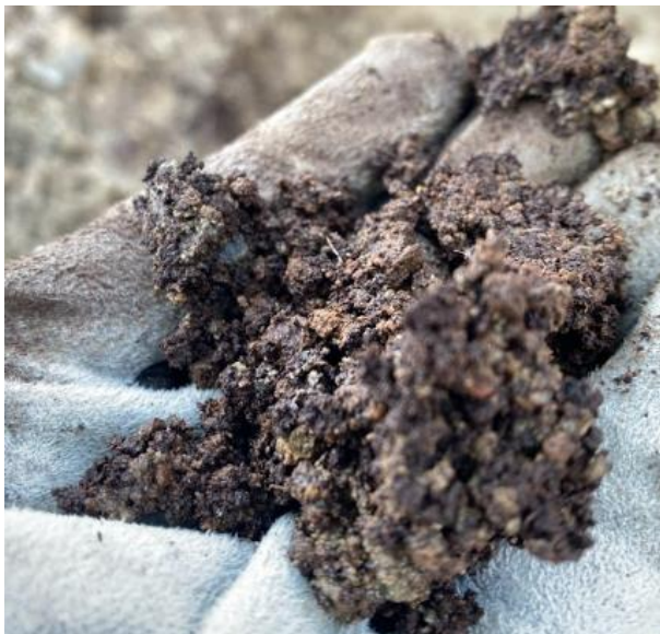
Figur 20 Närbild Organiskt material mellan tätkärna och erosionsskydd nedströms, sektion 0/175
