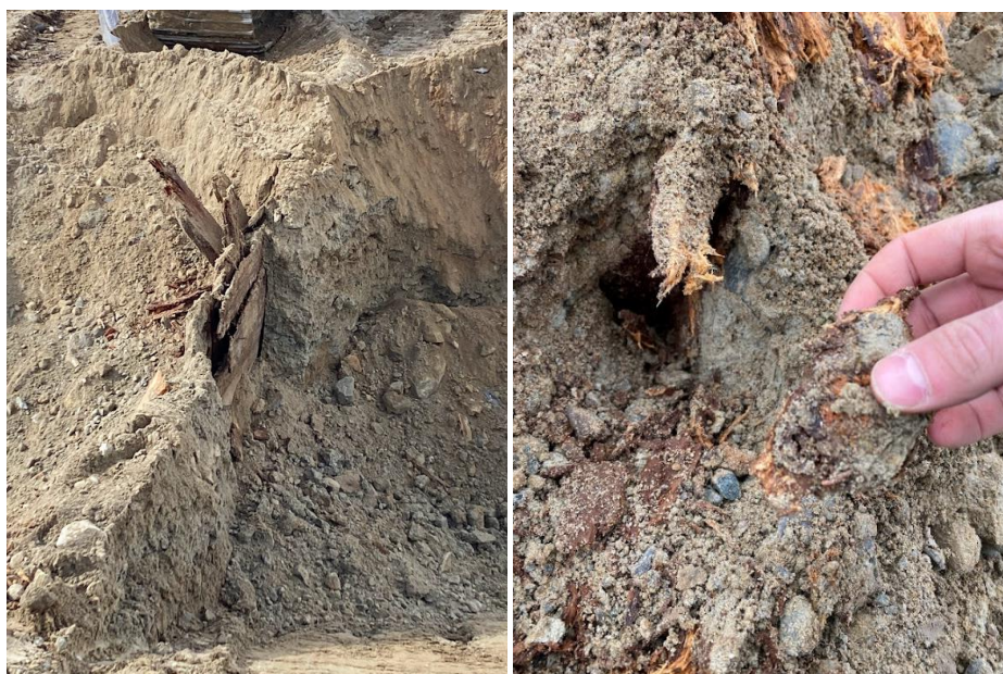
Figur 3.2 Exempel på träspont i Burvattnet.
