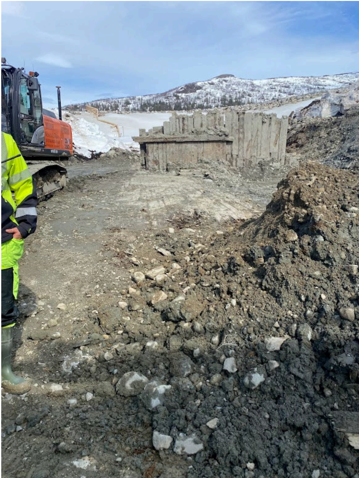
Figur 3a. Centrala delen av spanten samt kulverttaket på bottenutskovet, vy från nedströmssidan.
