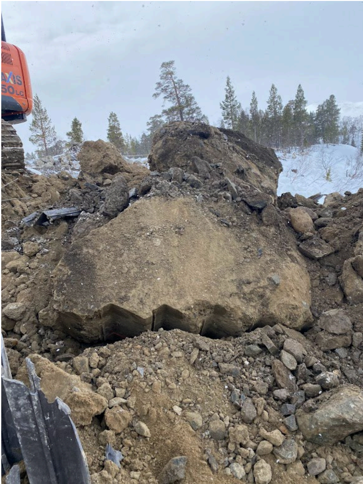
Figur 6b. Tjälblock, övre delen av dammen.
