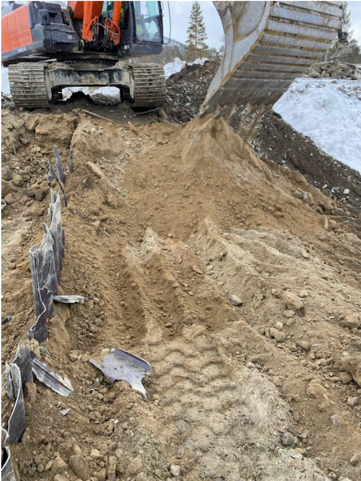
Figur 1a. Plastspont, nära dammkrönet (nivå ca. +566m).
