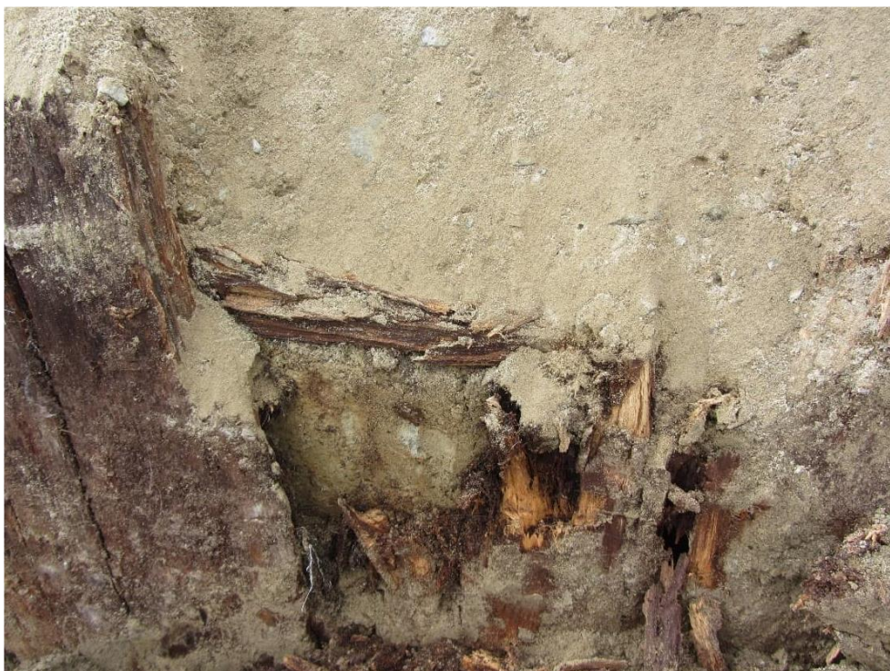
Figur 3.3 Håligheter genom den övre delen av sponten.
