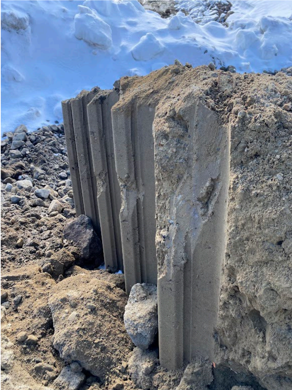
Figur 6a. Tjälblock, övre delen av dammen.
