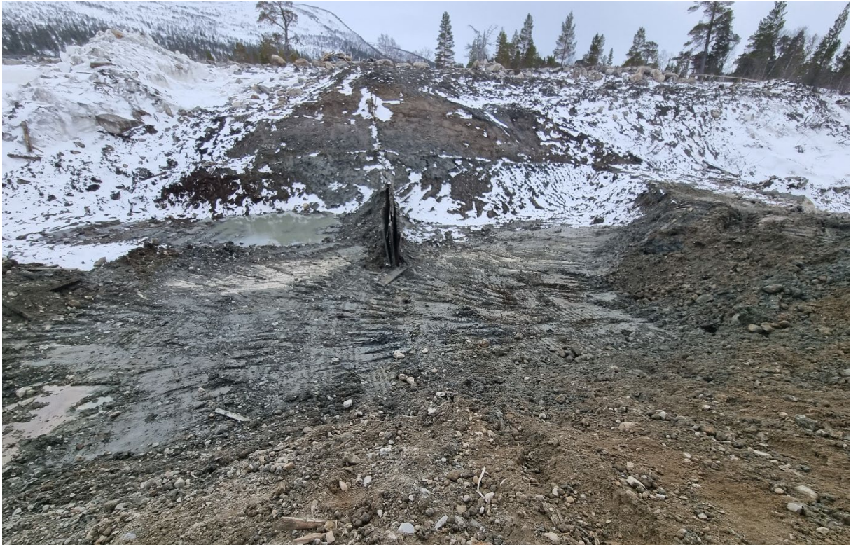
Figur 3b. Centrala delen av spanten samt kulverttak.
