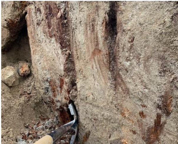
Figur 8 Träspont övre del, ingen skillnad i kvalitet kan påvisas mellan uppströms och nedströms sida av sponten, bild tagen nedströms, ca nivå för bilden är +563
