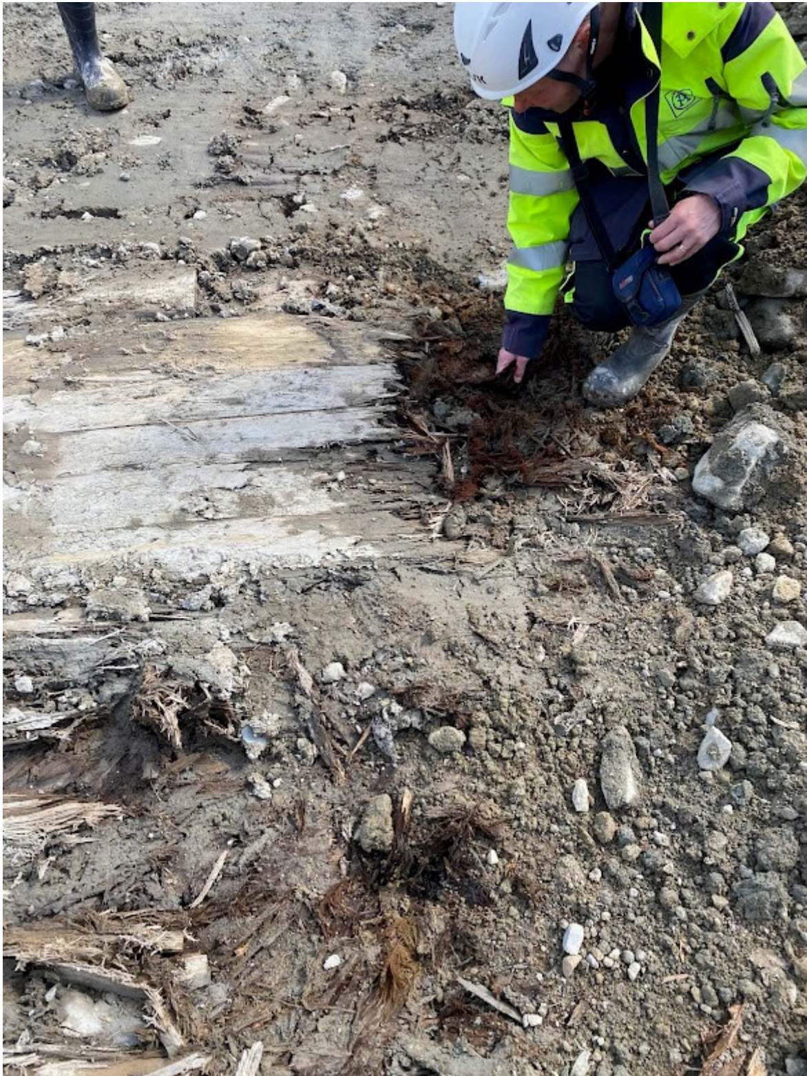
Figur 4a. Kulverttak, nedströmssida.
