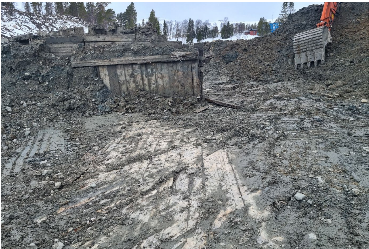
Figur 3c. Centrala delen av spanten samt kulverttak och vänster slänt i fyllningsdamm.
