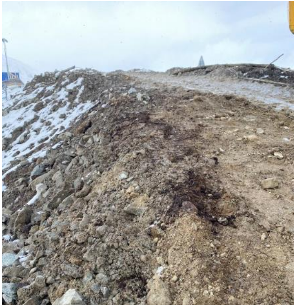
Figur 19 Organiskt material mellan tätjord och erosionsskydd nedströms, sektion 0/175
