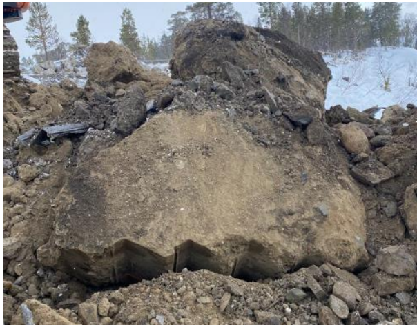
Figur 1 Tjälblock intill spont, ca en meters mäktighet, sträckte sig tom nivå +562,5
