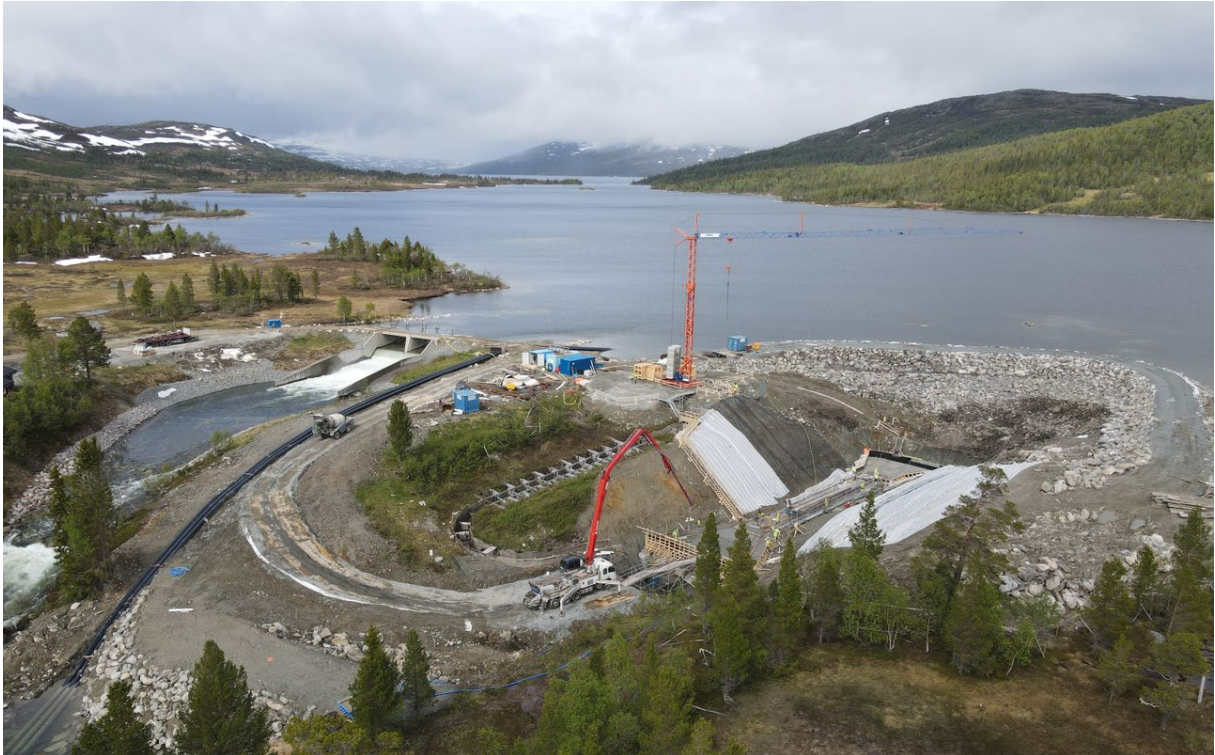
Figur 8b. Fotografiet visar att moränslänterna i läget för där dammen schaktats ner är skyddade. Man ser fiskvägen och att man spiller i ytutskovet, man ser nedströms fångdamm.
