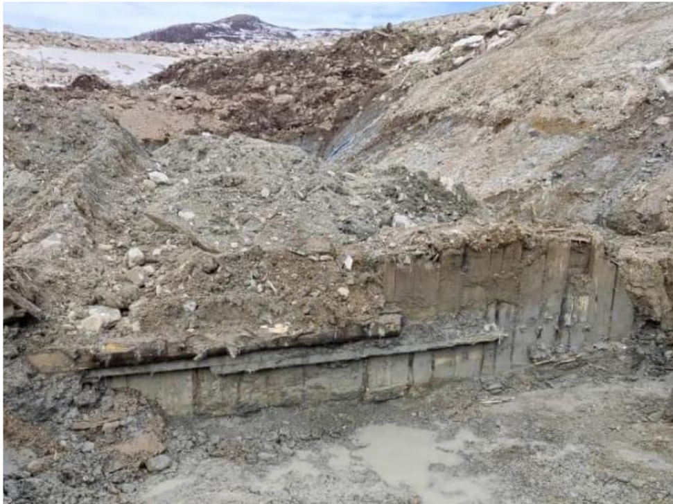
Figur 3.4 Nedströmssidan av spanten i grundläggningsytan under bottenutskovet.
