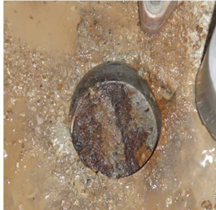
Armeringsstänger var under upplösning
