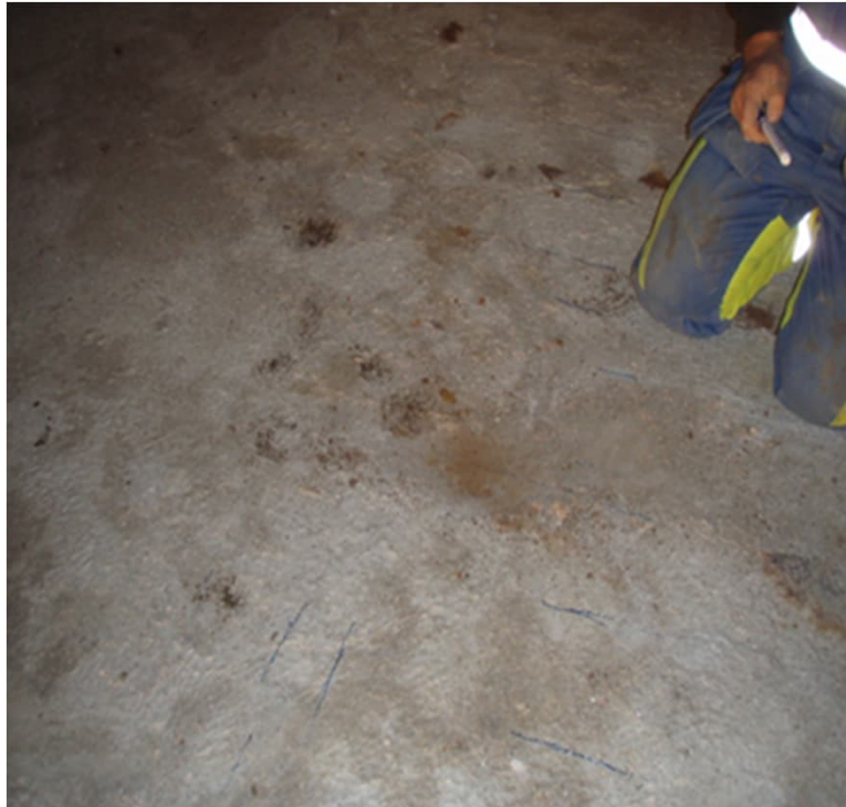
Bom förekom nästan överallt. Vita utfällningar täckte hela plattans yta.
