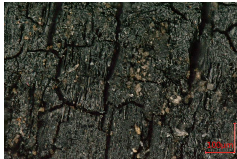
Optisk avbildning av ytan på en korroderat tätplåt
