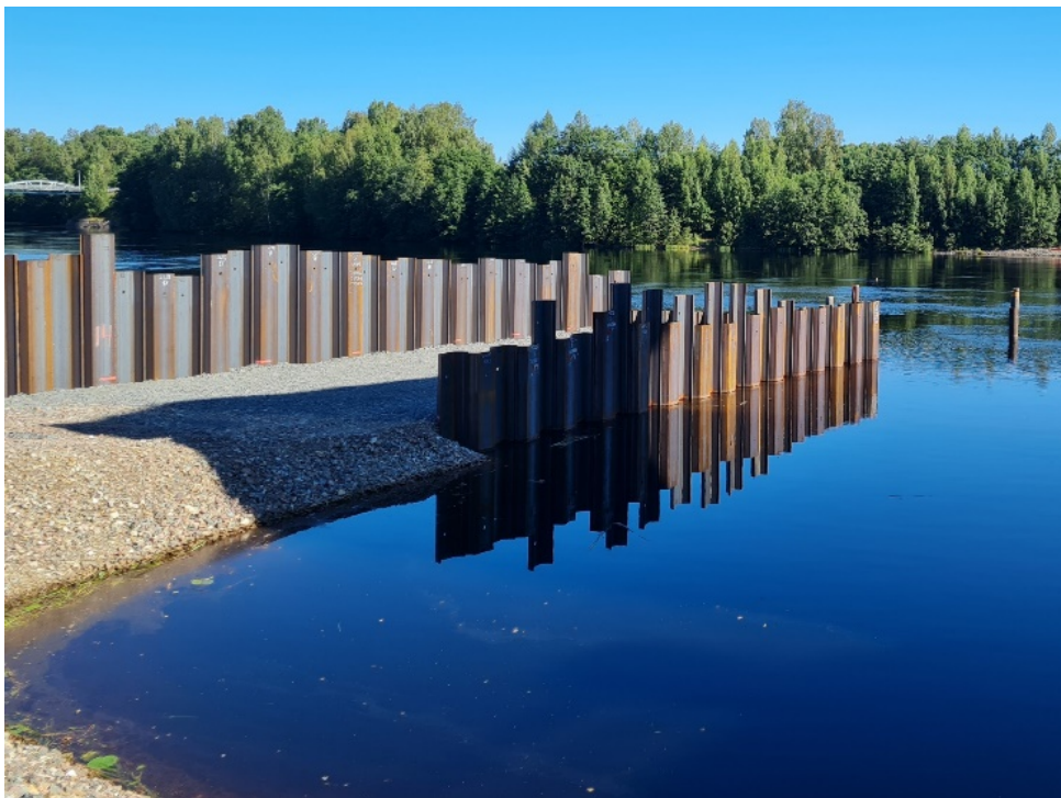
Figur 8 Dubbelspont under uppförande (foto Fortum)
