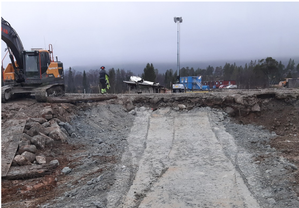
Figur 27 Anslutning av fångdammen mot befintlig fyllningsdamm
