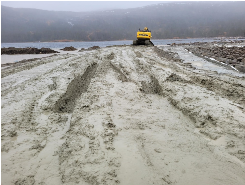
Figur 25 Blöta moränmassor ledde till ändrat packningsförfarande
