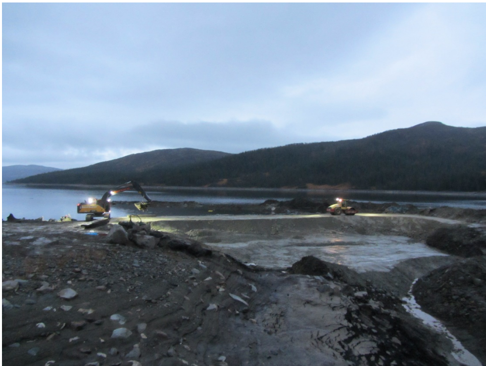
Figur 21 Nedströmsvy av fångdammen under arbetets gång
