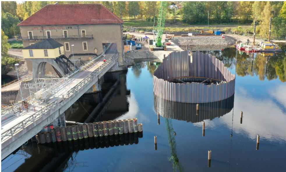
Figur 11 En kombination av olika fångdammar. Två celler under byggnation (foto Fortum)
