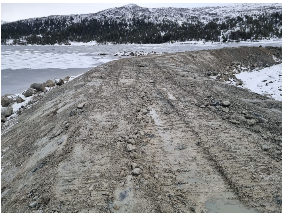
Figur 29 Övre delen av fångdammen innan utläggning av uppströms erosionsskydd och nedströms stödbank
