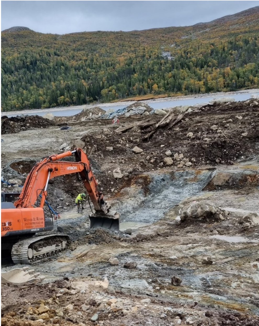
Figur 19 Schakt av tätdike för grundläggning av fångdammen
