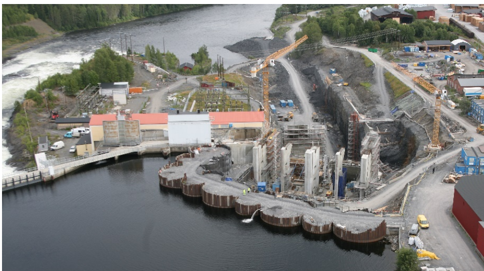
Figur 44 Uppströmsvy av cellfångdammen i Hissmofors (foto Jämtkraft)
