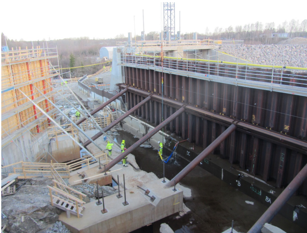
Figur 41 Nedströmssidan av fångdammen under etapp 2. På andra sidan fylldes magasinet upp till dämmningsgräns vid driftsättning av nya dammdelar (se Figur 42)
