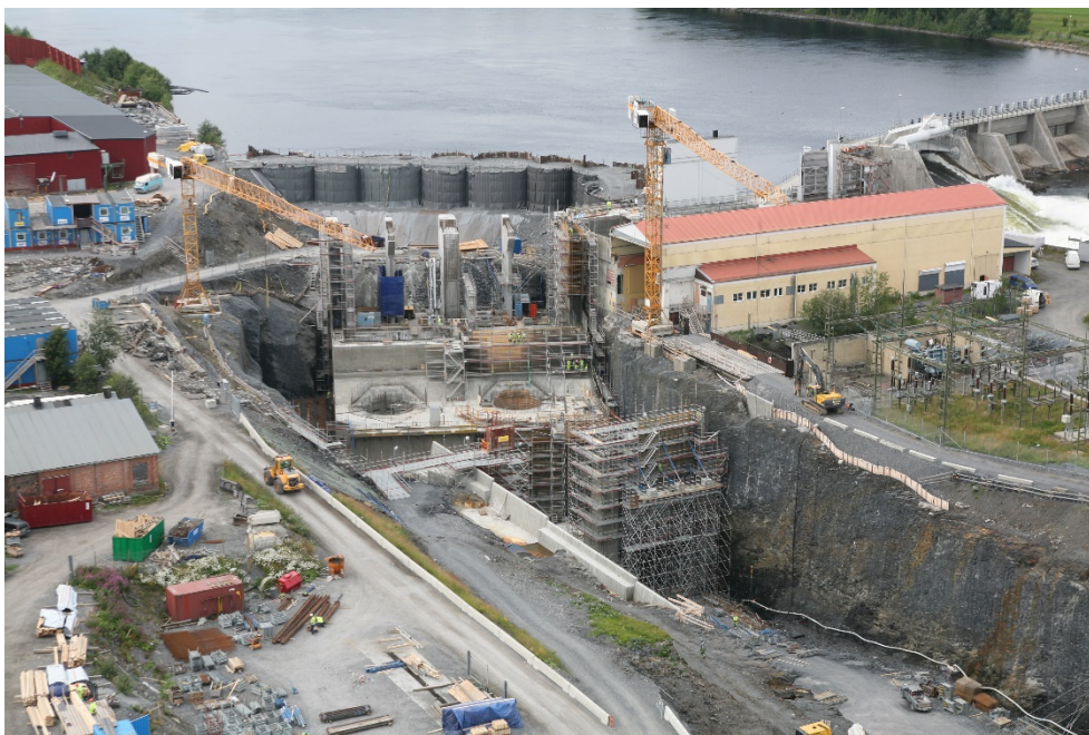
Figur 45 Nedströmsvy av cellfångdammen i Hissmofors (foto Jämtkraft)
