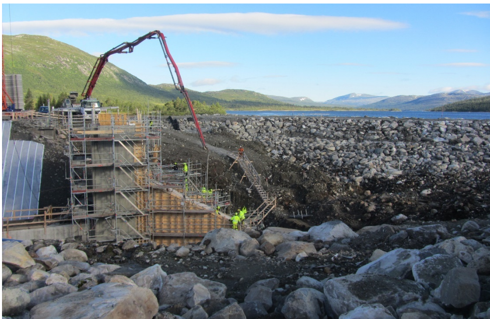
Figur 14 Färdig fångdammen i bakgrunden under pågående återuppbyggnad av huvuddammen
