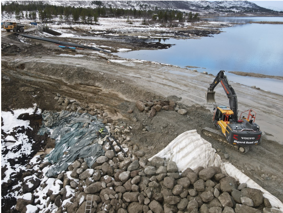
Figur 24 Geotextil och utsorterad sten på fångdammens nedströmsslänt
