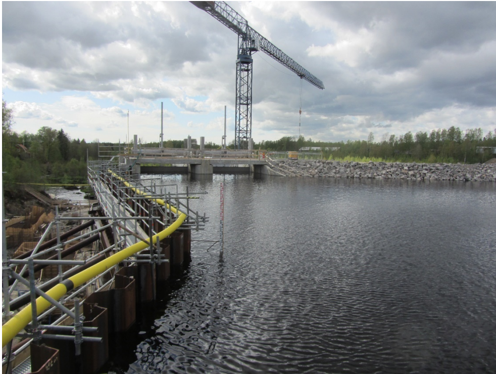
Figur 42 Fångdammen (klädd med byggställning) belastad med vattenlast under etapp 2
