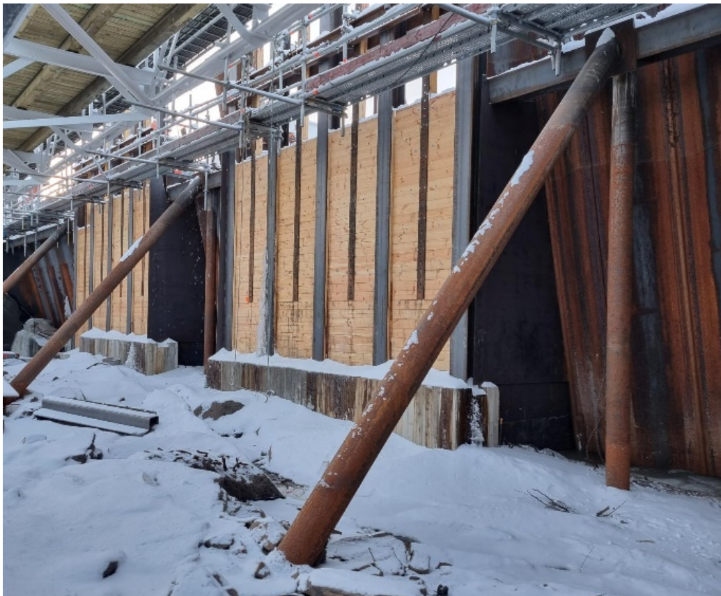
Figur 13 Fångdamm med luckor kan vara ett alternativ om byggarbetsplatsen kan utrymmas och vattenvägen nedströms fångdammen klarar avbördning (foto Fortum)
