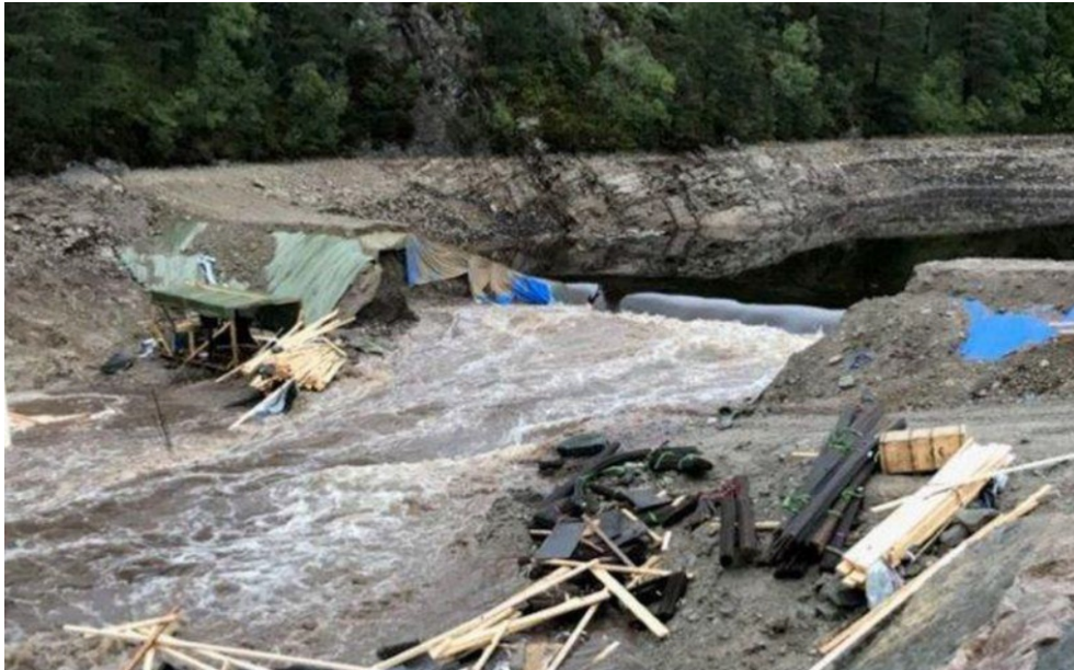
Figur 50 Fullständigt dammhaveri (från presentationen Planning and design of cofferdams in light of Munkbottsvatn dam failure , Sigtryggsdóttir, NTNU)
