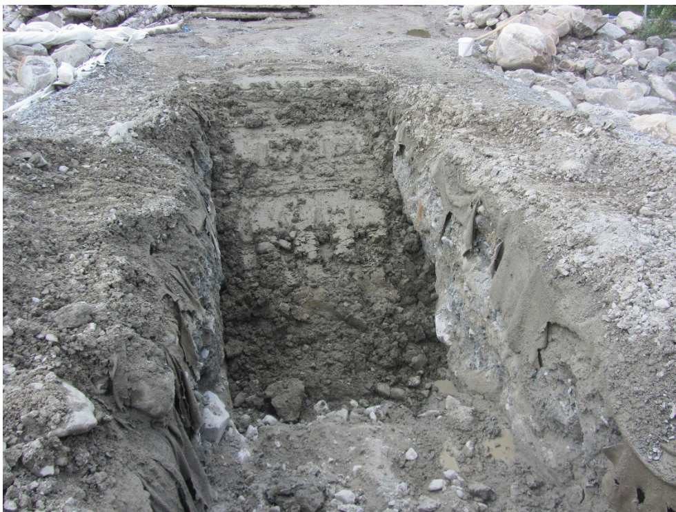
Figur 32 ... och ersattes med blöt morän som ursprungligen var tänkt att användas till tätkärnan i den återuppbyggda dammen
