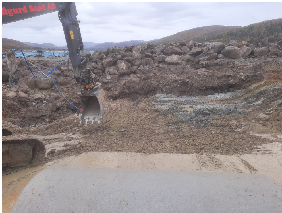
Figur 20 Grundläggning av fångdammen
