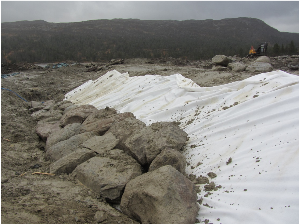
Figur 22 Geotextil och erosionsskydd av utsorterad sten på fångdammens uppströmsslänt
