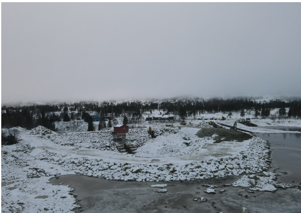
Figur 28 Översiktsbild av fångdammen strax innan den är uppe i full höjd. I bakgrunden syns huvuddammen.
