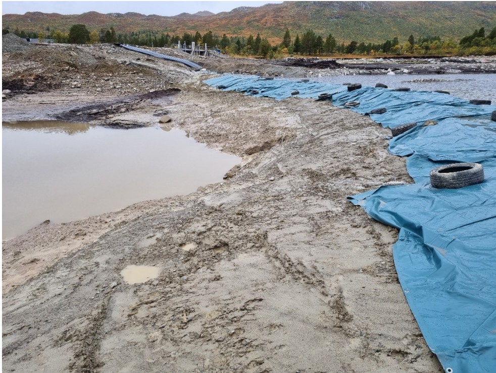
Figur 18 Färdig mindre fångdamm uppströms huvudfångdammen. Presenningen är lagd som ett tillfälligt skydd mot nederbörd
