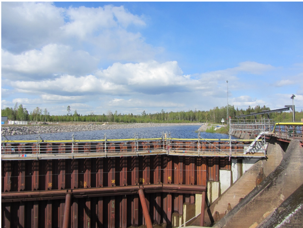
Figur 43 Nedströmsvy av fångdammen under etapp 2
