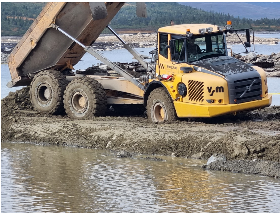
Figur 17 Moränmassor till den mindre fångdammen läggs ut i vatten
