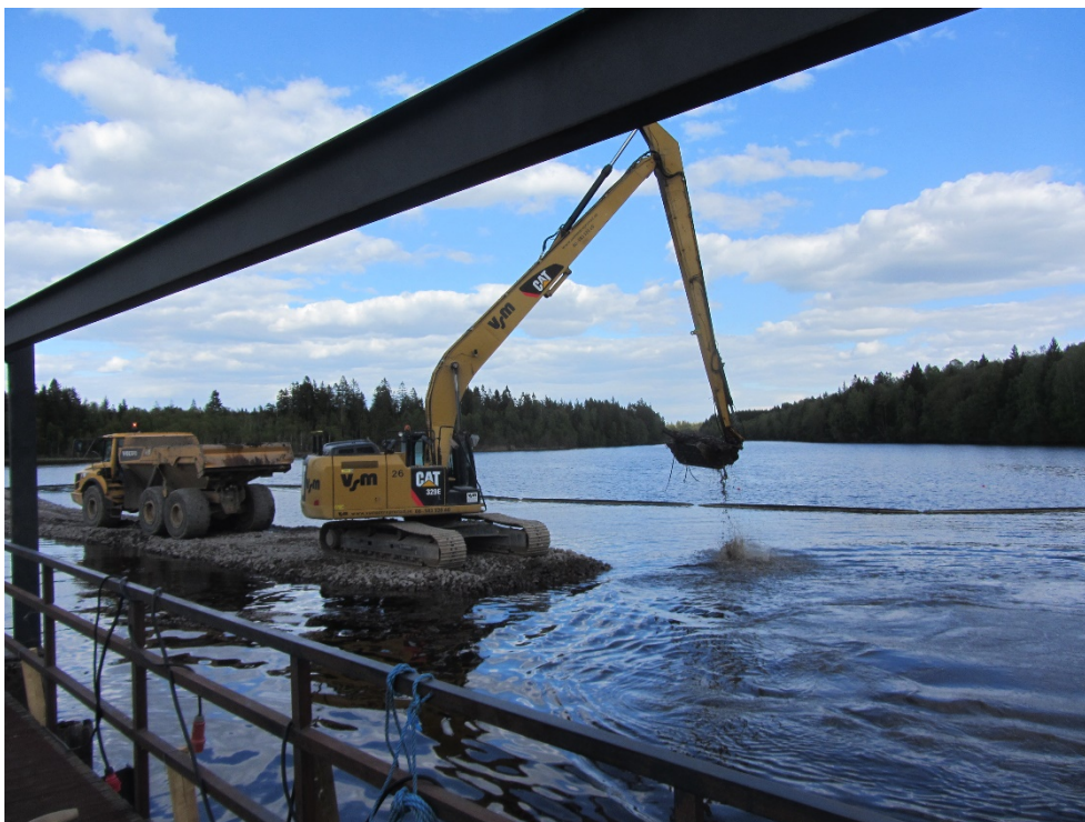
Figur 37 Utläggning av sprängsten är påbörjad. Rensning av löst material på magasinbotten pågår. Siltgardinen syns i bakgrunden
