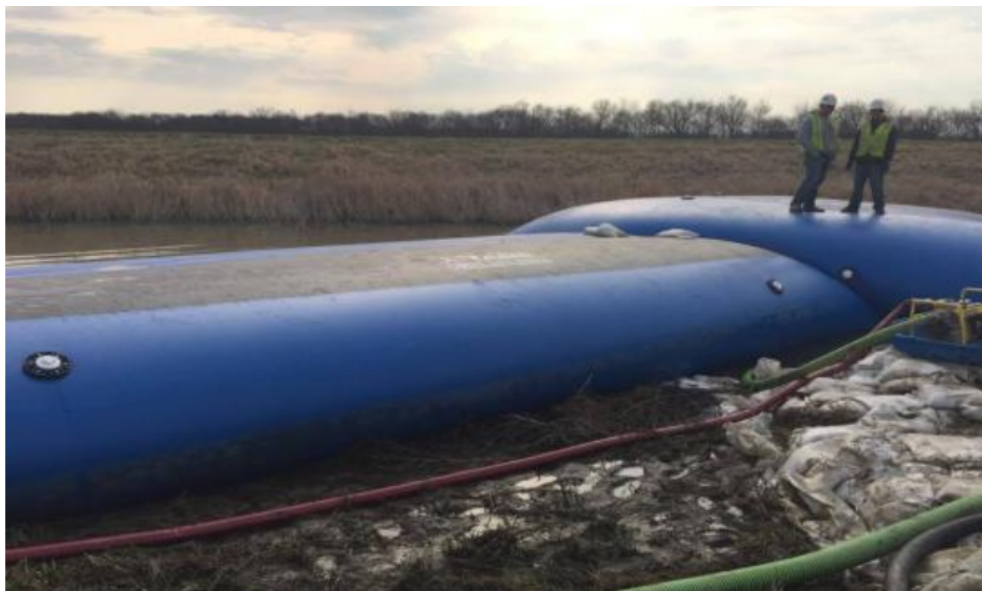
Figur 1 Återanvändbar vattenfylld fångdamm. Fångdammsystemet medger att flera vattenfyllda dammar ansluts till varandra genom överlappning. Material av polyester med vinylbeläggning. Från Detroit Tarp ( https://detroittarp.com )
