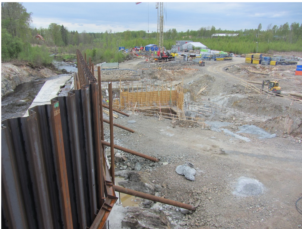
Figur 40 Nedströmssidan av fångdammen under etapp 1. Vatten kan spillas till vänster om sponten
