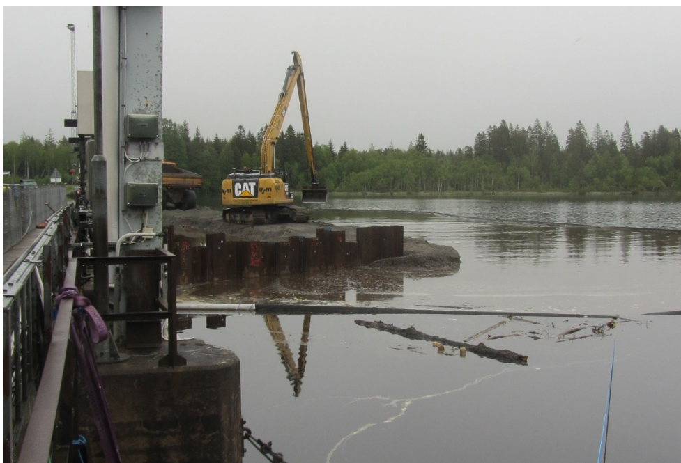
Figur 38 Utläggning av morän på uppströmssidan av fångdammen. Fyllningsdammen ansluter till befintlig dammpelare med en stålspont
