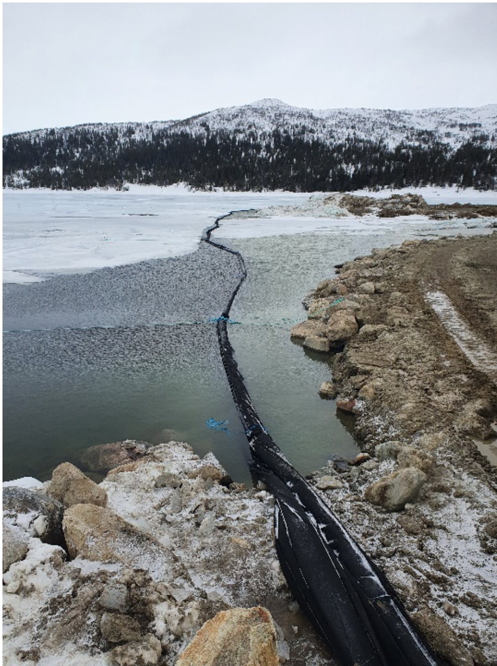
Figur 34 Siltgardinen på plats inför rivning av fångdammen
