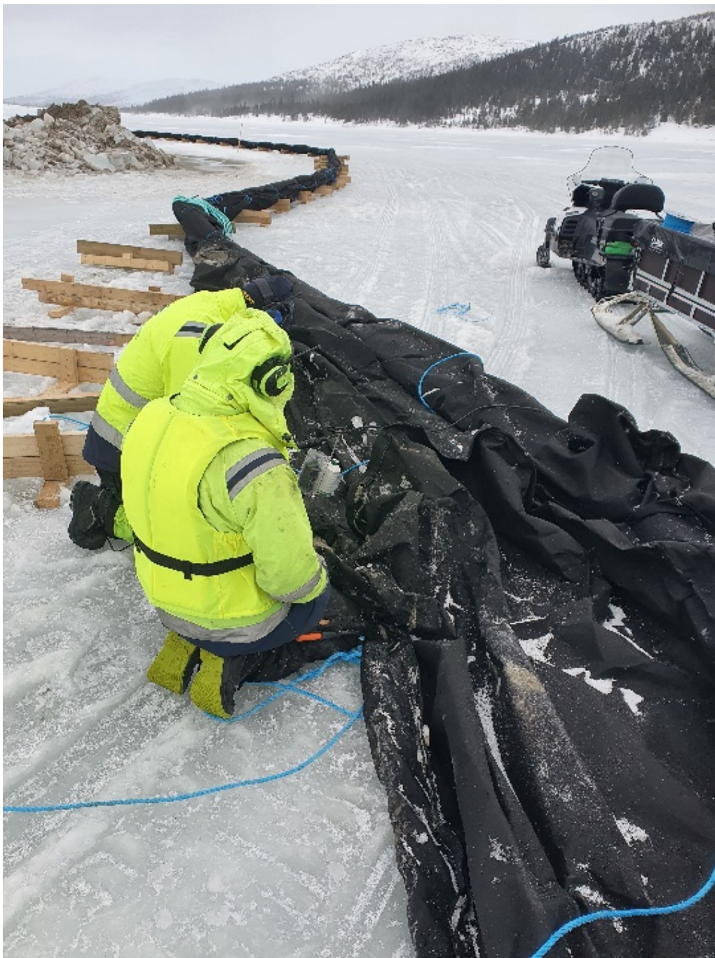
Figur 33 Siltgardinen sys ihop på plats inför rivning av fångdammen
