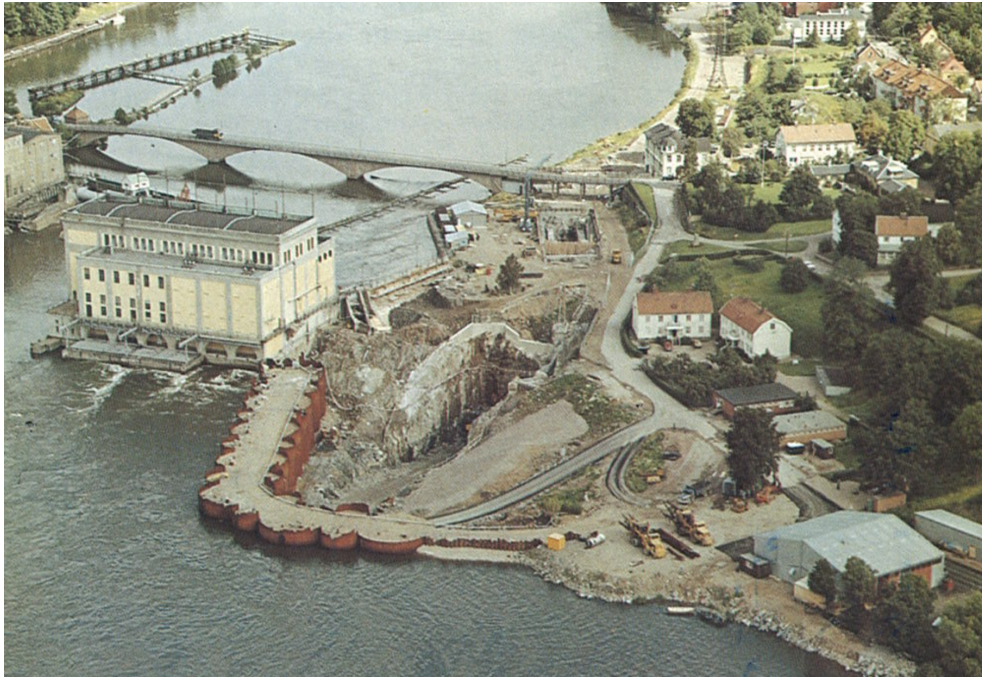
Figur 10 Exempel på cellfångdamm. Utbyggnad av Lilla Edet kraftverk aggregat 4 (maj 1978 till april 1979) 11
