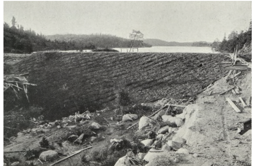
Dammens nedströmssida av fyllning
