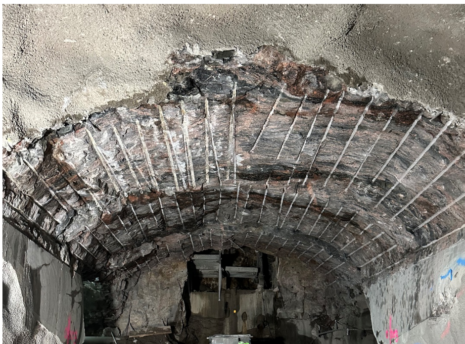
Figur 18 Tunnelkontur efter kemisk spräckning under jord vid Henriksdals reningsverk (Foto: Christer Skönnerud).
