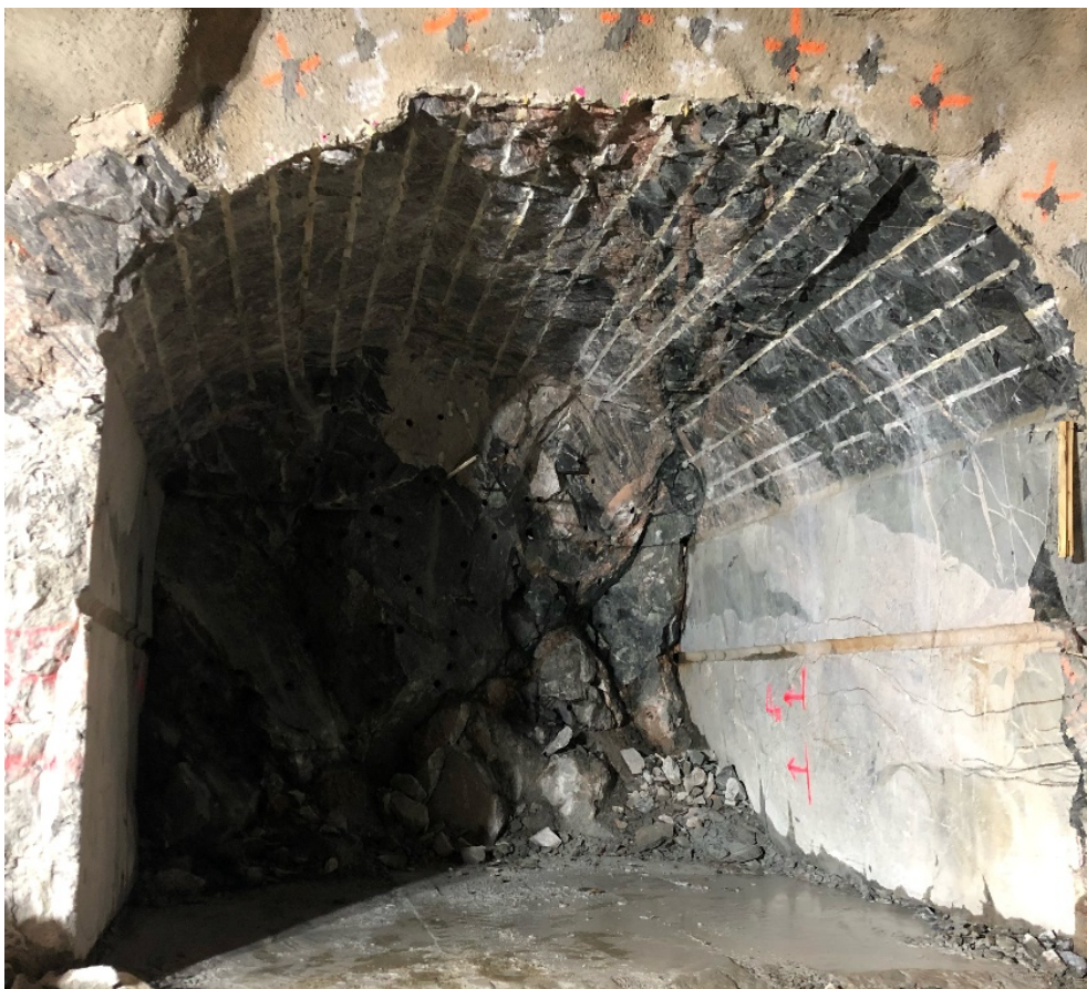
Figur 16 Berguttag i Henriksdals reningsverk som gjorts i kombination med flera metoder. Tunneltaket är uttaget med kemisk spräckning, väggarna är blind cut-sågade och resten har brutits med hydraulisk spräckning (Foto: Christer Skönnerud).
