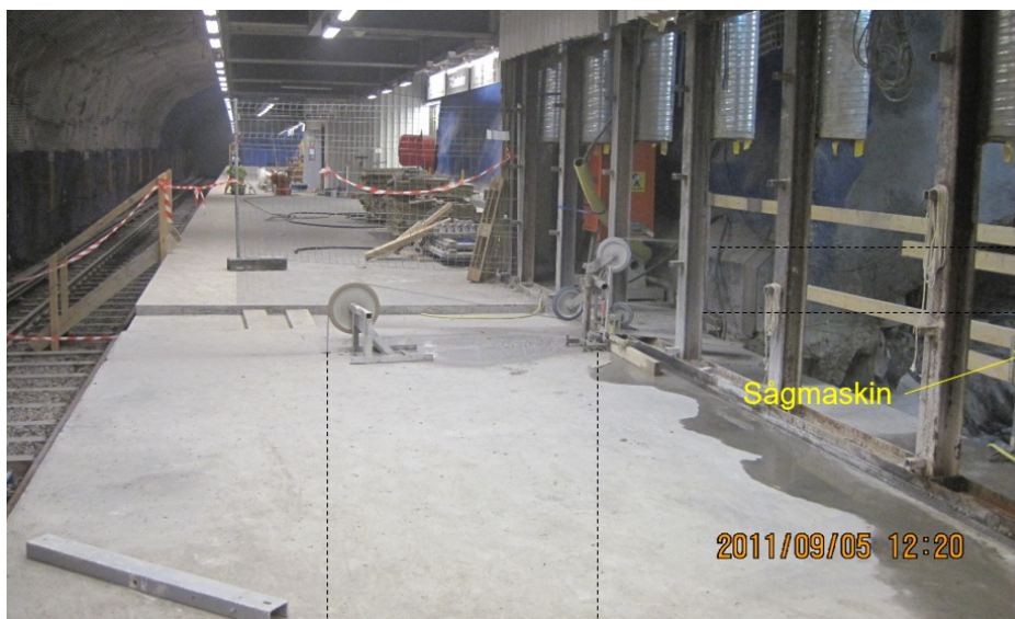
Figur 5 Sågning av ett vertikalt snitt med konventionell vadersågning och flera hjul. Foto från blå tunnelbana station T-centralen, projekt Citybanan (Foto: Robert Swindell).
