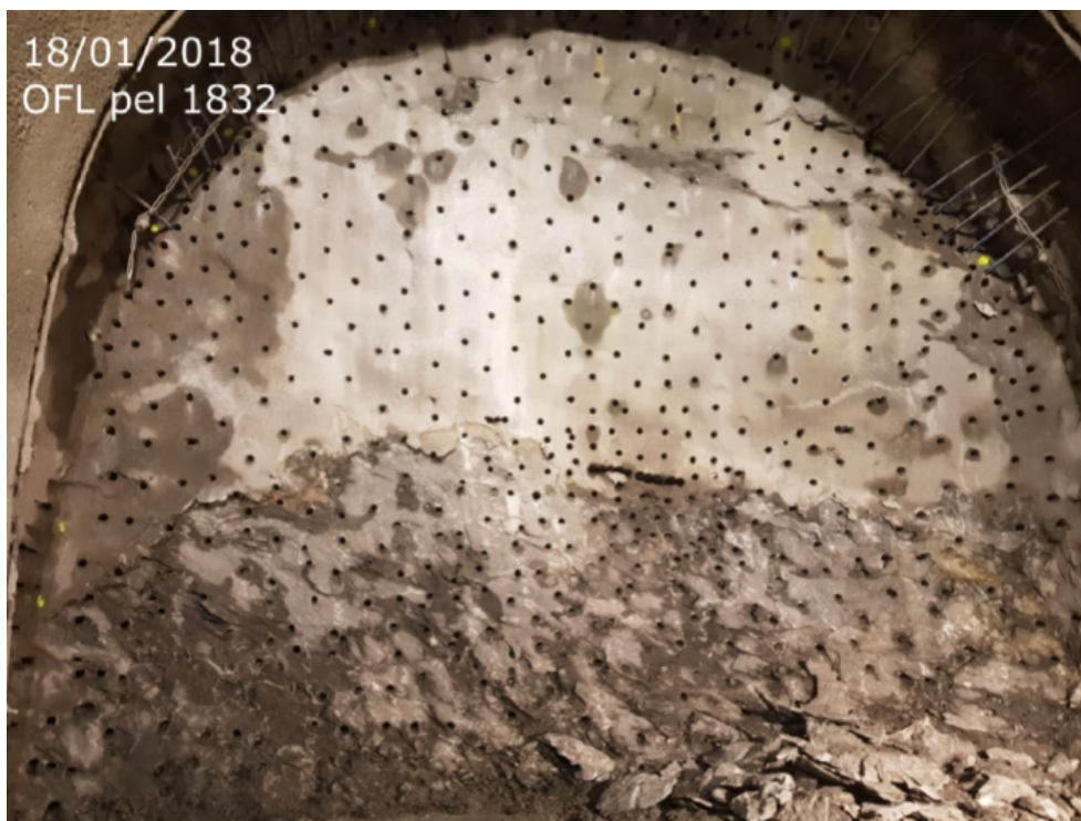
Figur 13 Borrad tunnelfront inför hydraulisk spräckning i Follobaneprojektet 28 .
