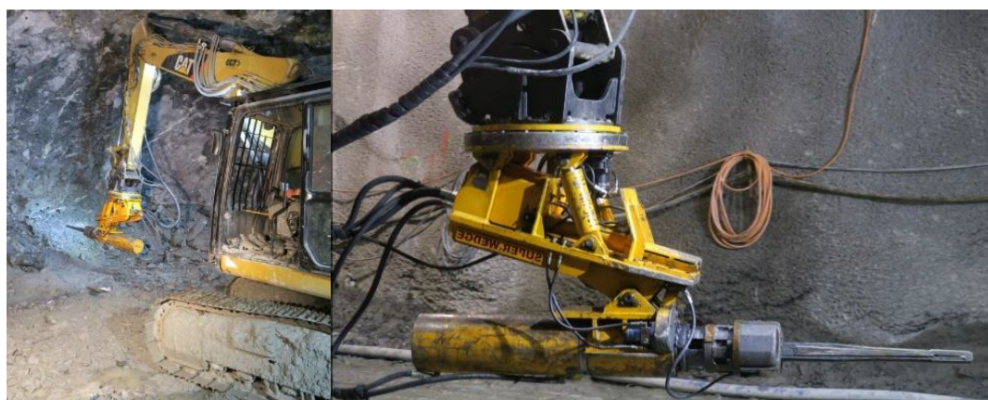
Figur 14 SuperWedge monterat på grävmaskin 28 .
