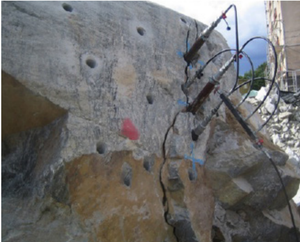
Figur 12 Spräckning av berg vid Nya Karolinska Solna med hydrauliska splitters 26 .
