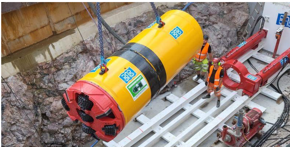
Figur 22 Installation av en MTBM i schakt (Foto: BAB Rörtryckning AB).
