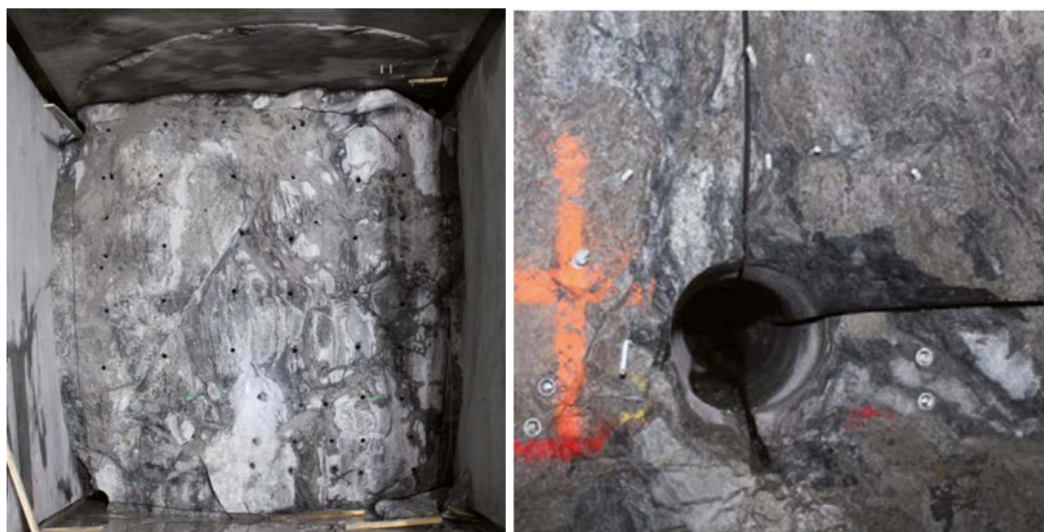
Figur 7 Horisontell tunneldrivning med vadersågad kontur i Citybanan 14 .
