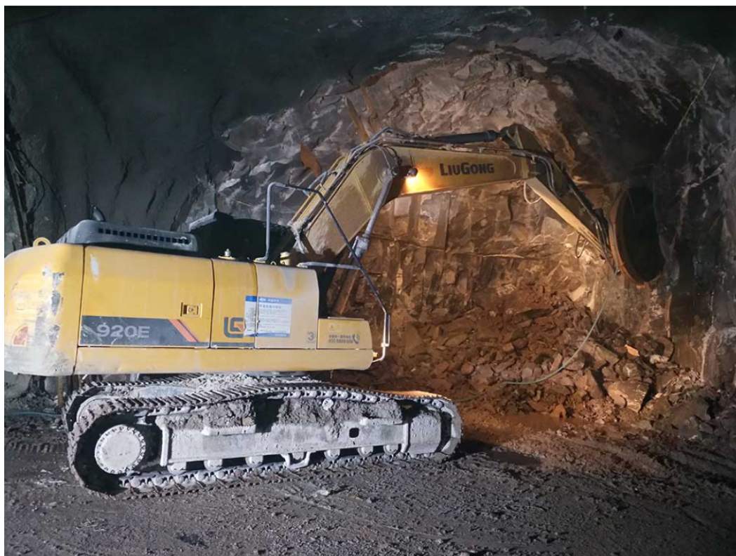
Figur 9 Klingsågning med grävmaskin i tunnel 22 .
