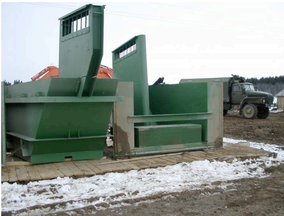
Figur 3.5 Tillverkade Hydroplus-gates innan installation i dammen (Hydroplus 2010).
