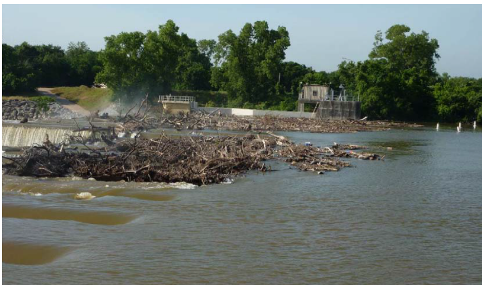
Figur 7.4 Drivgods som samlas vid Lake Brazos labyrinthutskov (Crookston et al. 2015).
