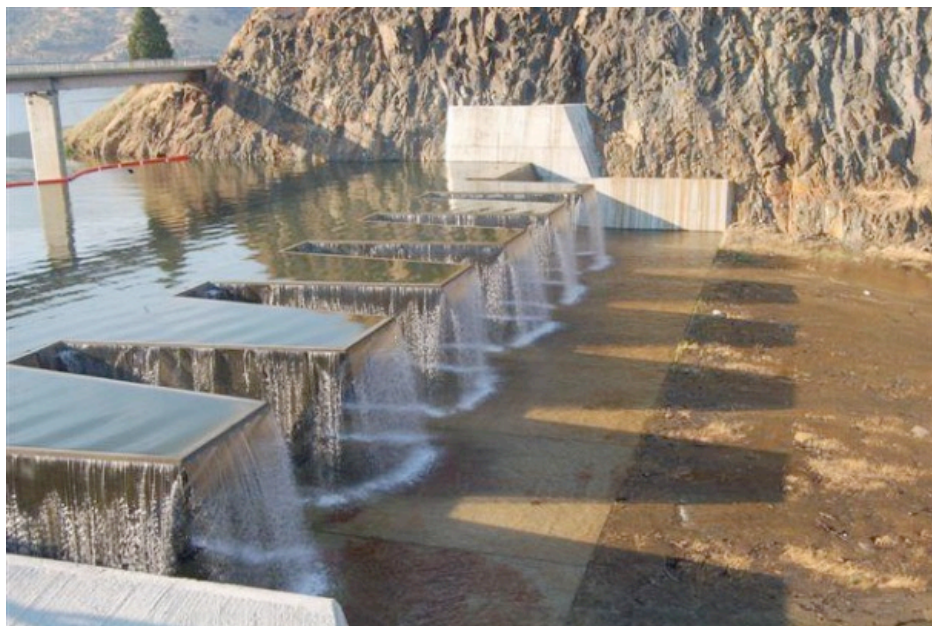
Figur 3.2 Terminus dammen, California (källa: Bureau of Reclamation 2014).
