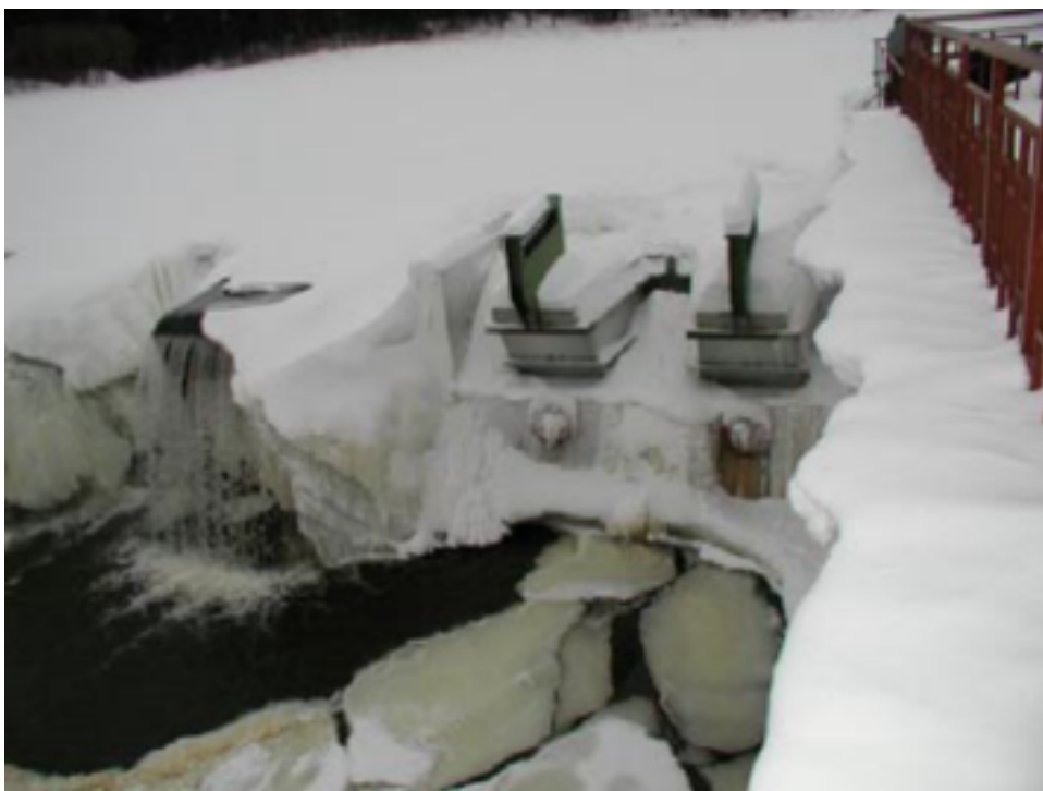
Figur 4.4 Issituation vid fuse gate- och labyrinthutskov under fältförsök 2001–2002 (Hydroplus 2010, Chapuis 2018, Kocahan and Rodionov 2003). Det är oklart när foto (a) är taget men foto (b) är från 2002-01-04.
