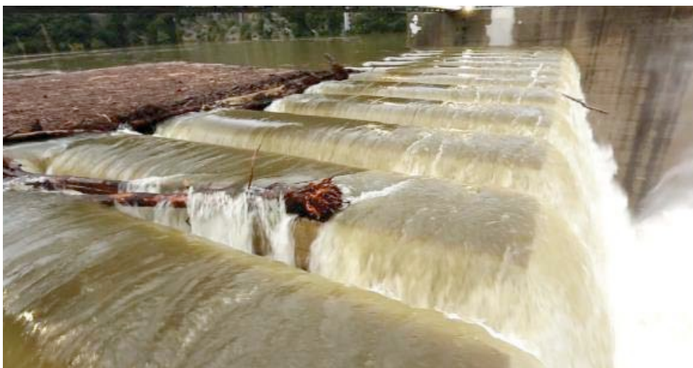
Figur 7.1 Beteenden av drivgods av träd vid pianotangentutskov (Gebhardt et al. 2017). Om överfallshöjden ej är tillräckligt stor för att lyfta drivgods över utskovet samlas det i magasinet.
