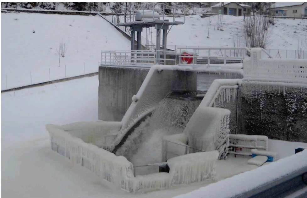
Figur 6.2 Avbördning under vinter genom pianotangentutskov vid Escouloubre-dammen, Frankrike (källa EDF; Erpicum, et al. 2013).
