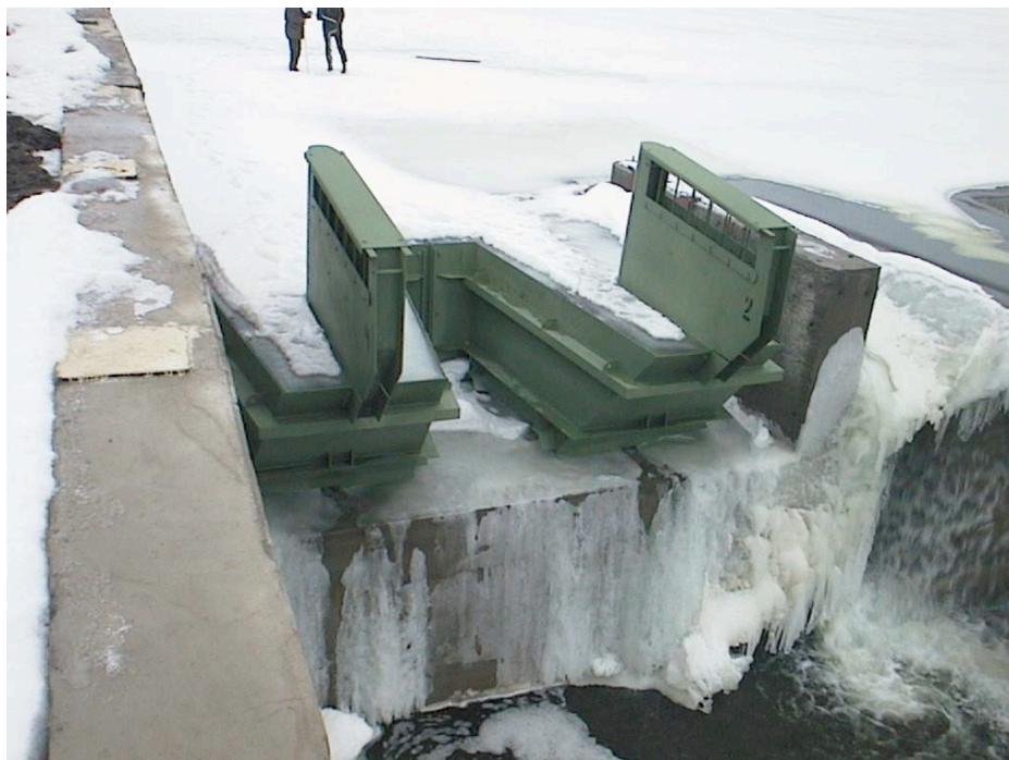
Figur 3.9 Situation med is och istäcken när plus-temperaturen varade drygt en vecka och isen började smälta (Hydroplus 2010, Kocahan and Rodionov 2003).
