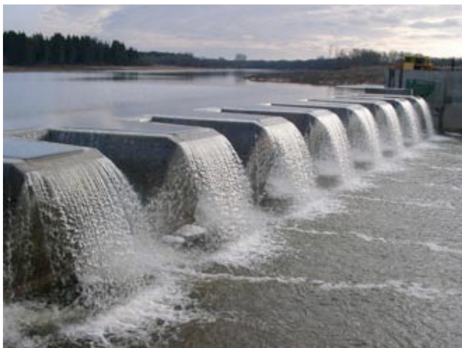
Figur 3.3 labyrinthutskov vid Khorobrovskaya dammen, hösten 2001 (Kocahan and Rodionov 2003).
