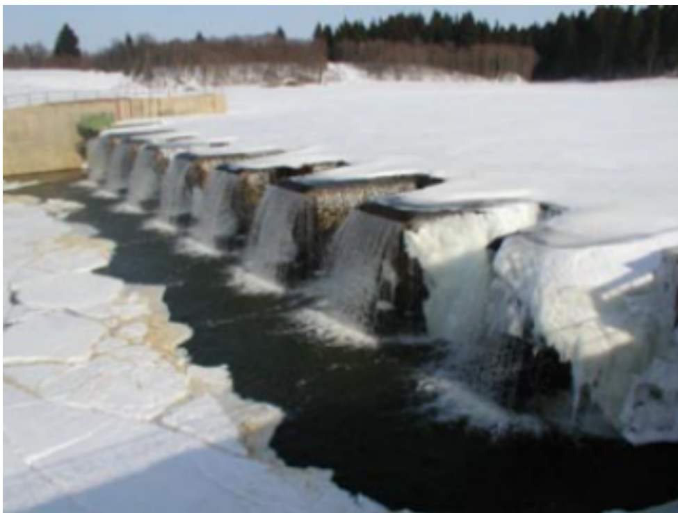
Figur 4.3 Labyrintutskov vid Khrorbrovskaya dammen, med isläggning och vid avbördning i början av vintern 2001 ((Hydroplus 2010, Kocahan and Rodionov 2003).
