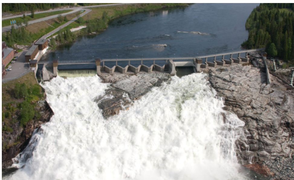
Figur 4.1 Labyrinthutskov i Nedre Fiskumfoss kraftverk (foto Aslak Løvoll, Norconsult AS).
