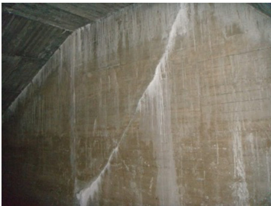
Figur 3-19 – Sprickbildning i en utskovspelare orsakad av säsongsb beroende termisk kontraktion.
