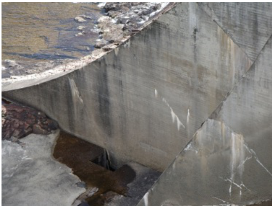
Figur 3-19 – Sprickbildning i en utskovspelare orsakad av säsongsb beroende termisk kontraktion.
