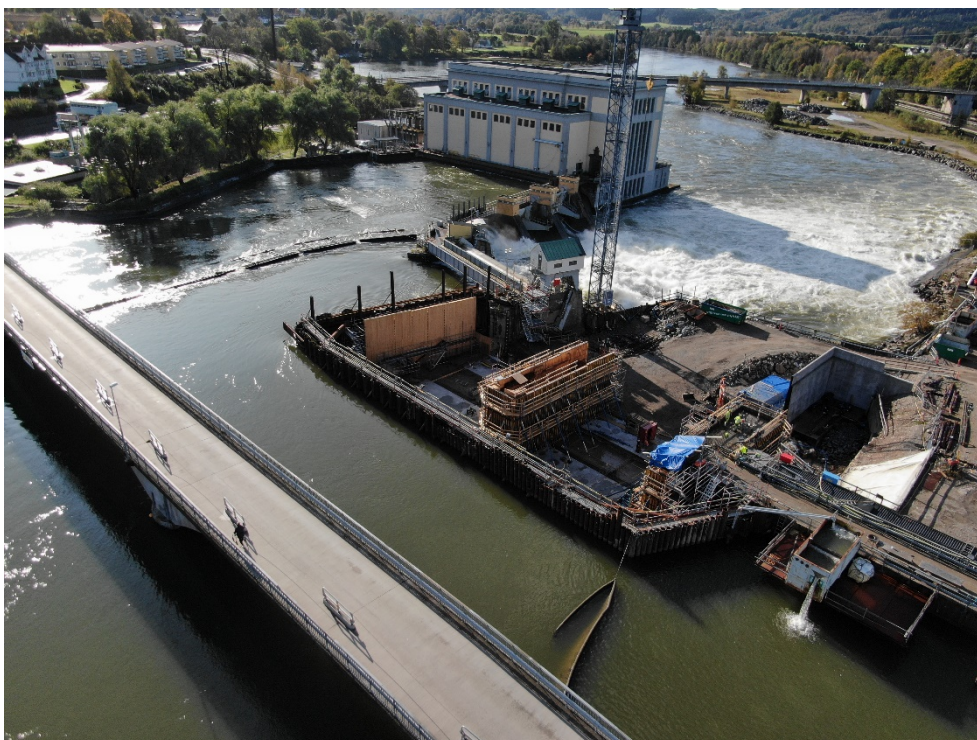
Figur 3. Foto över Lilla Edet, från uppströmssidan. Foto av Vattenfall.
