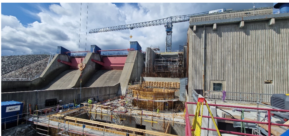
Figur 5. Foto från formsättning generatorkammare i Rengård. Foto av NCC.
