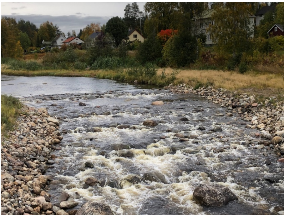
Figur 35 Anlagd tröskel vid medelvattenföring
