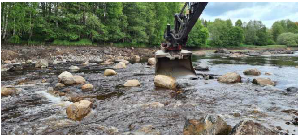
Figur 22 Utläggning av sten vid ett av de f.d. dammlägena
