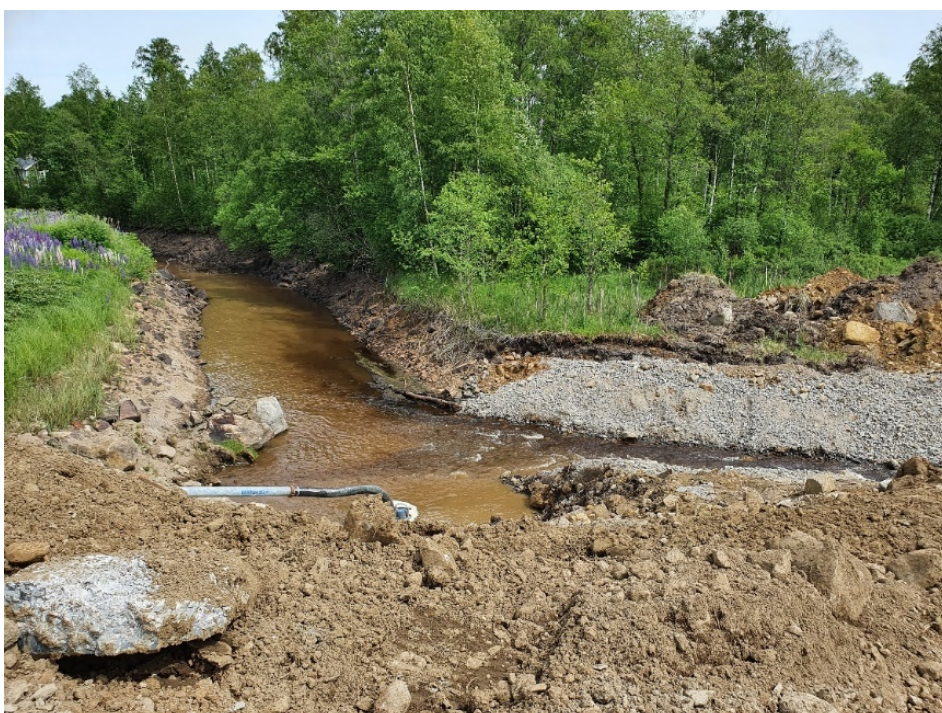
Figur 19 Tillfällig omledning av Klubbån för att kunna arbeta i torrhet. Mintappning hanteras med hjälp av pumpning. Fångdammen syns i förgrunden.
