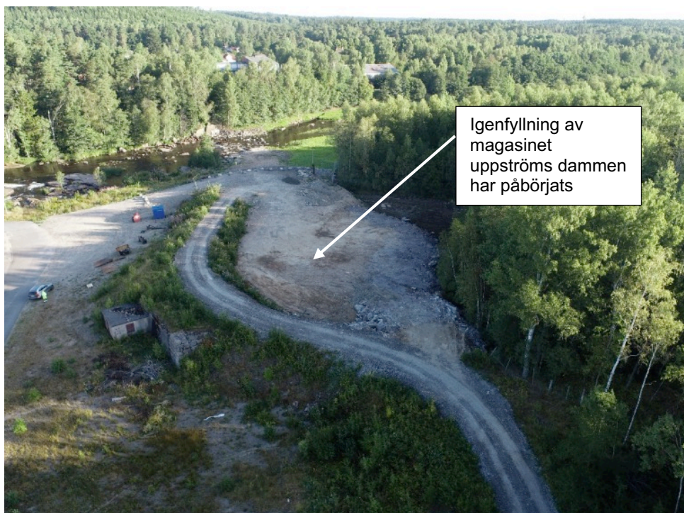
Figur 17 Igenfyllnad av magasinet uppströms fyllningsdammen
