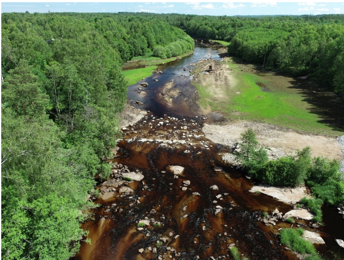
Figur 27 Flygfoto vid det f.d. dammläget vid Sägverksdammen. Fotot är taget några månader efter utrivningen.
