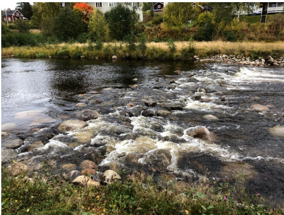
Figur 36 Anlagd tröskel vid medelvattenföring
