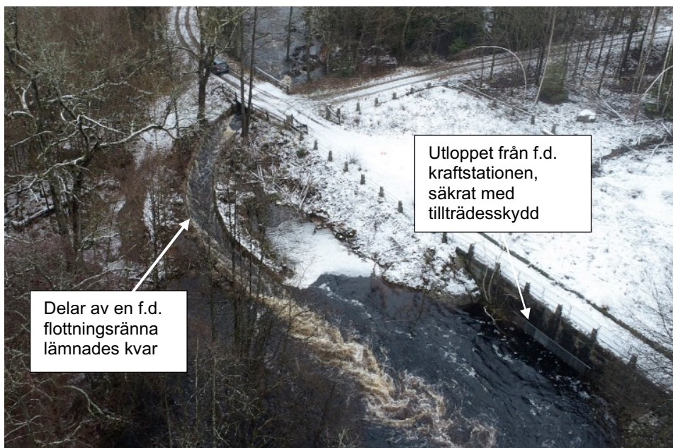
Figur 29 Flygfoto vid utloppet från den rivna kraftstationen. Fotot är taget i samband med ett högföde.
