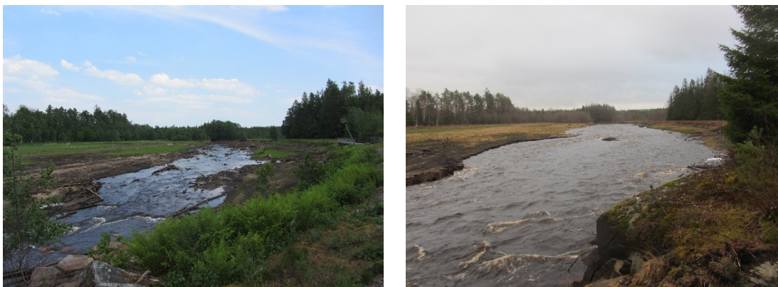
Figur 23 Foton vid det f.d. dammläget vid Glassbo. Bilden till vänster är tagen vid normalflöde knappt två månader efter utrivningen och bilden till höger är tagen i samband med ett högflöde ca 8 månader efter utrivningen
