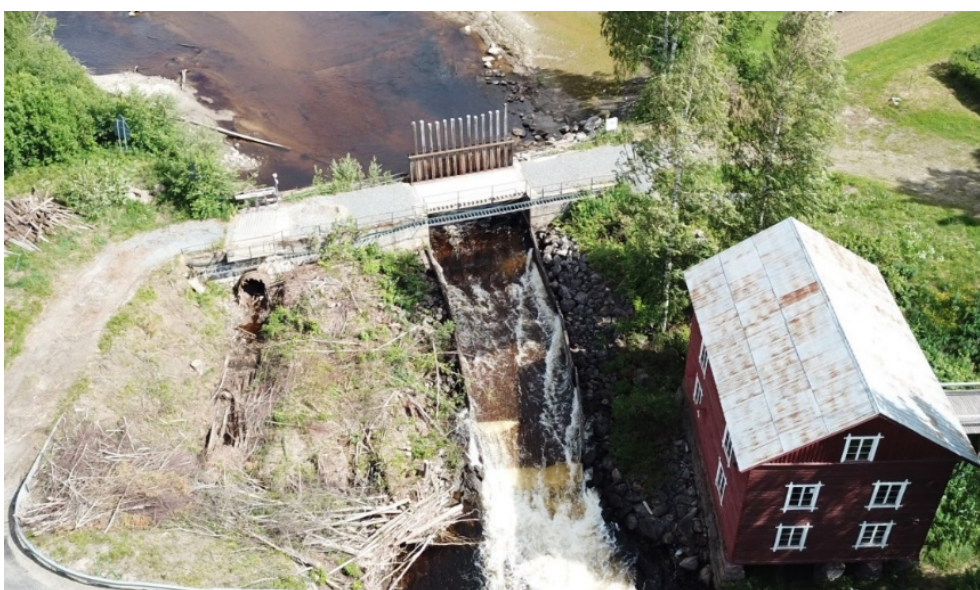
Figur 31 Översiktbild av dammanläggningen innan utrivning
