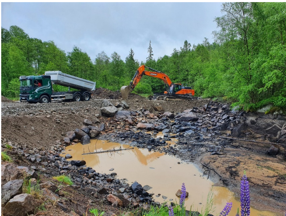
Figur 18 Bygge av fångdamm vid Klubbån
