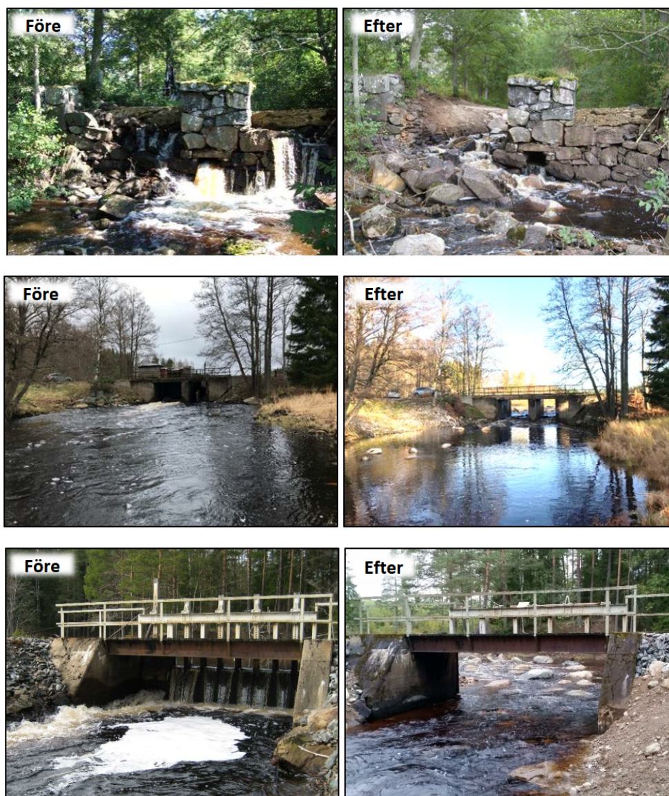
Figur 1 Exempel på dammar där anläggningsdelar lämnats kvar efter utrivningen. (Bilderna är tagna från rapporten Analys av kostnader i samband med borttagande av dammar 1 .)
