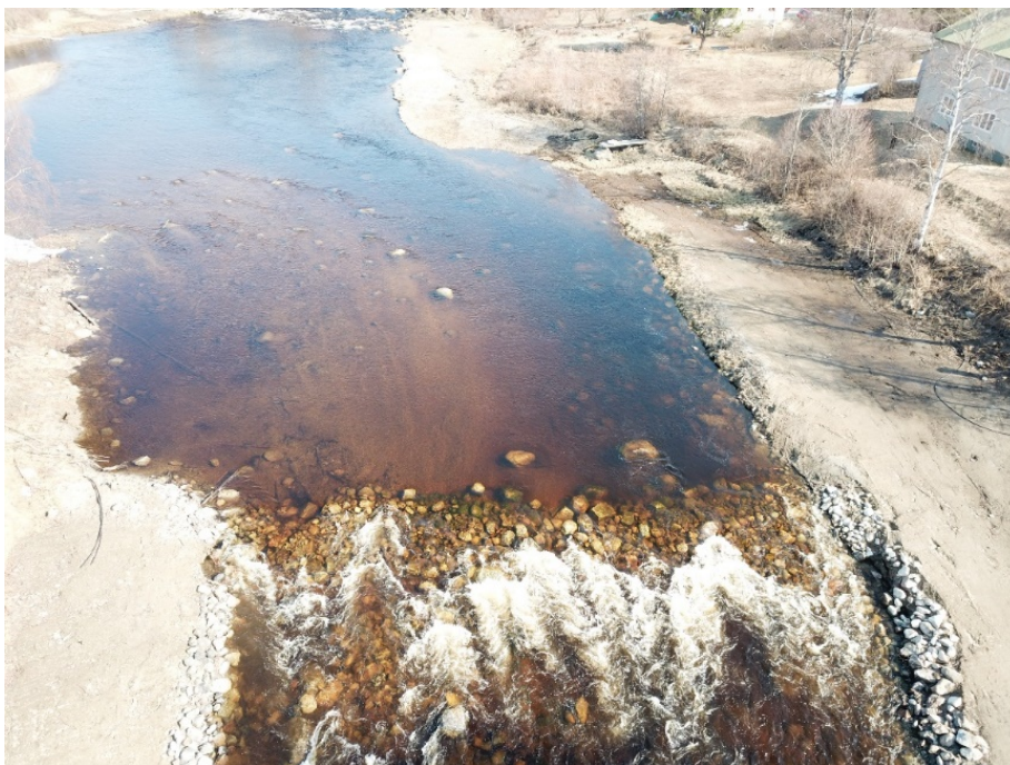
Figur 34 Anlagd tröskel vid en högfödessituation
