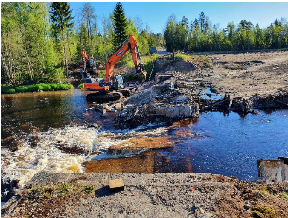
Figur 15 Rivning av Glassbodammen pågår
