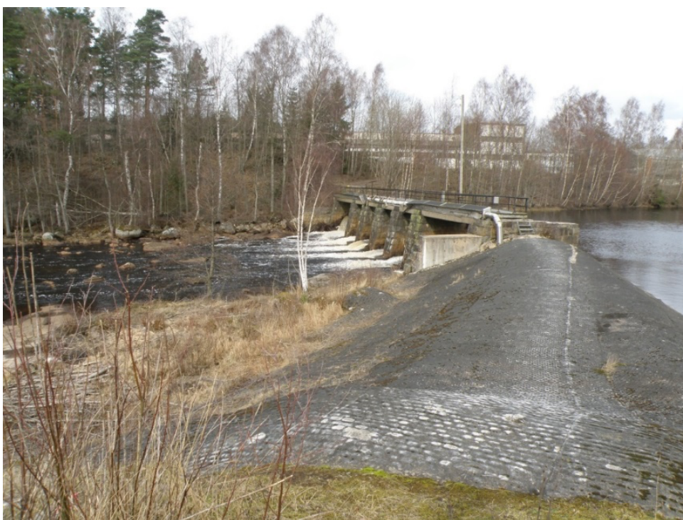
Figur 10 Överfallsdammen och utskovsdammen
