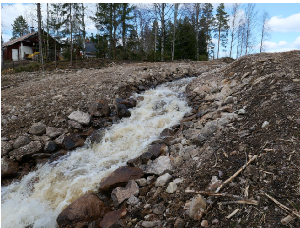
Figur 46 Foto nedströms f.d. inloppet till tuben
