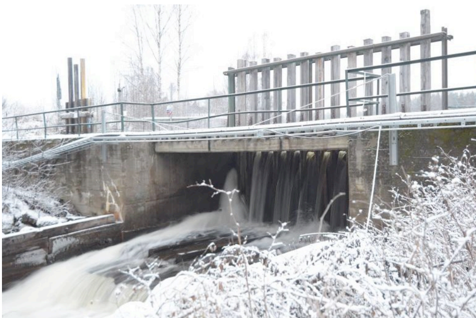
Figur 32 Bild på dammen innan utrivning
