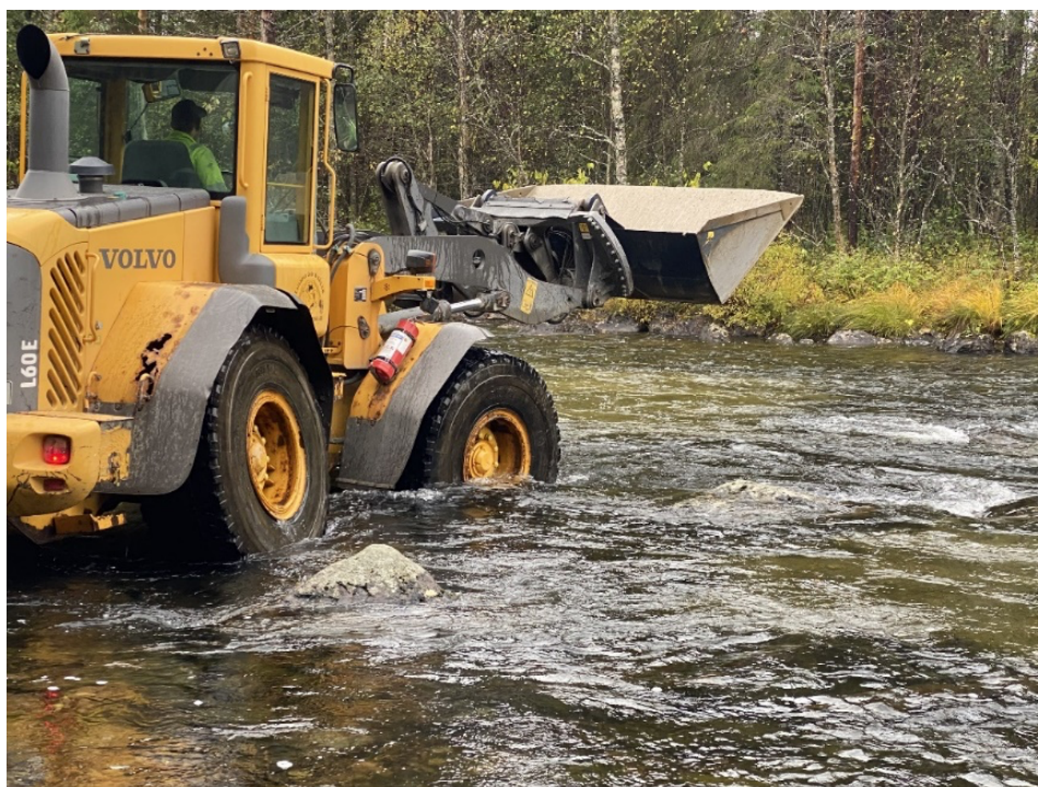
Figur 3 Grusutläggning med hjälp av hjullastare
