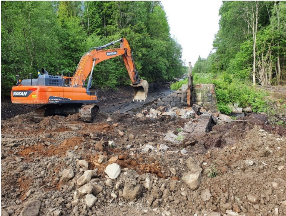
Figur 20 Arbetet med att riva utskovet vid Klubbån och återställa dess naturliga fåra pågår. Uppåt i bild syns den torrlagda intagskanalen.
