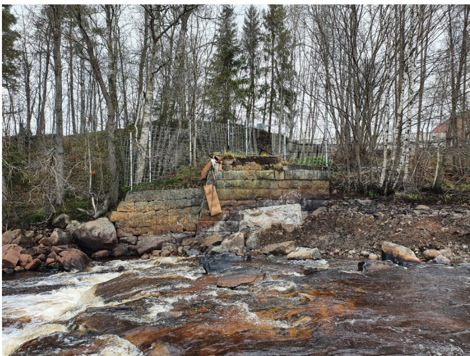
Figur 16 Delar av landfästet vid Sägverksdammen lämnades kvar av kulturmiljöskäl
