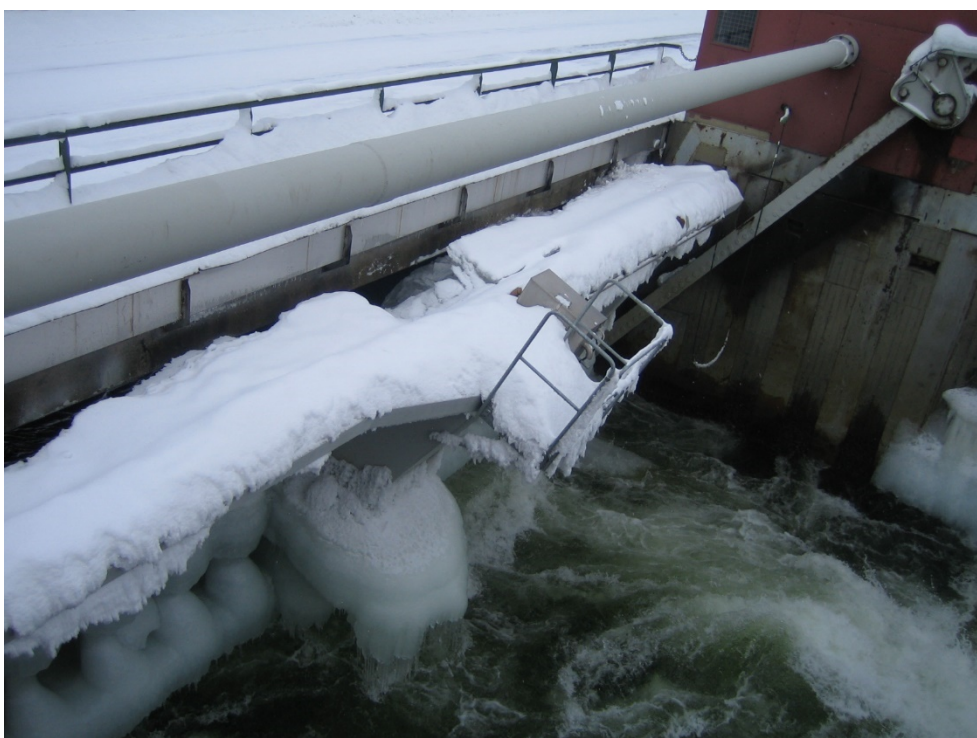
Figur 9-43. Ispåbyggnad vid bordläggning som resulterar i att det inte går att öppna då isen tar emot undersidan av bron.
