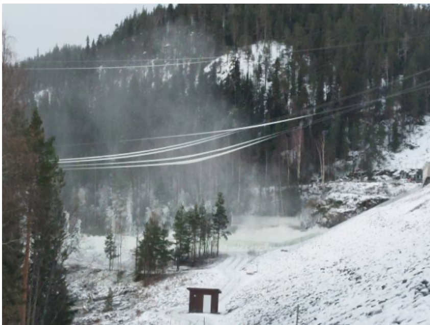
Figur 9-53. Ispåbyggnad på nedströms kraftledning från vattendimma där en uppskattad nedböjning på ledningarna blivit 5 meter.
