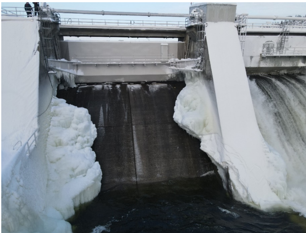
Figur 9-27. Ispåbyggnad på nedströmssidan av lucka.
