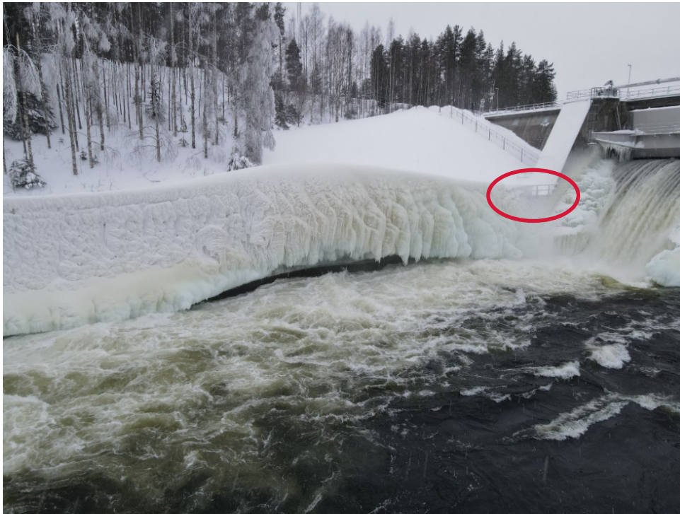
Figur 9-12. Ispåbyggnad på en nedströms ledmur sett från sidan. Räcket som knäcktes vid töväder är inringat på bilden.
