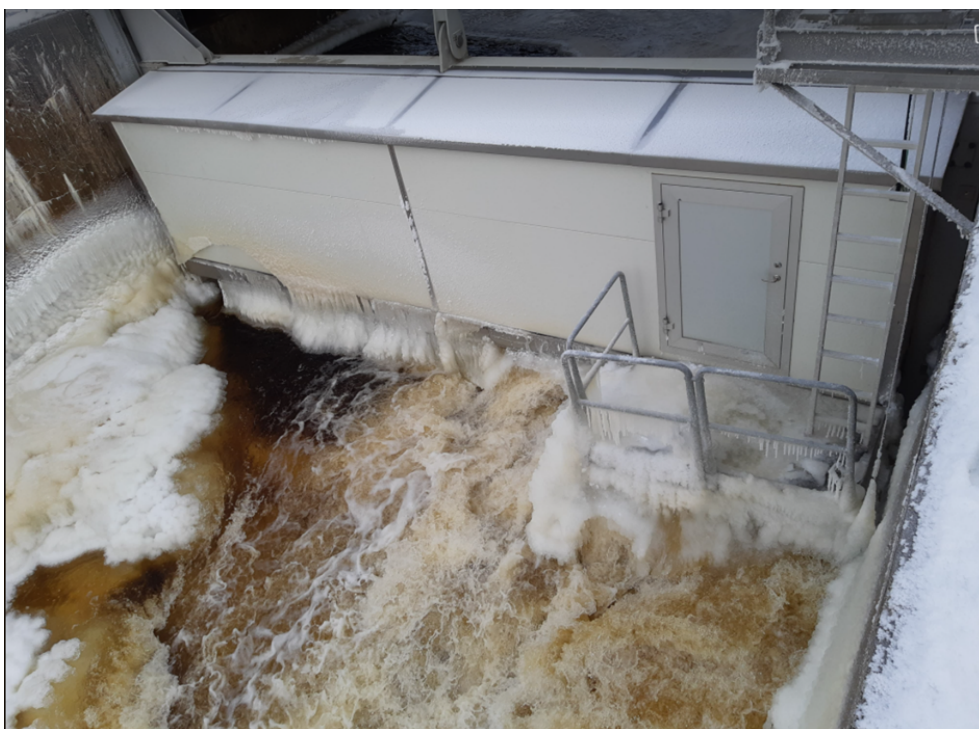
Figur 9-1. Lucka 5, vinterluckan ombyggd för ca 5 år sedan. Så här såg luckan ut då den var öppen 52cm vilket motsvarar 21 \text{ m}^3/\text{s} , men den avbördade bara lite vatten på halva luckan.
