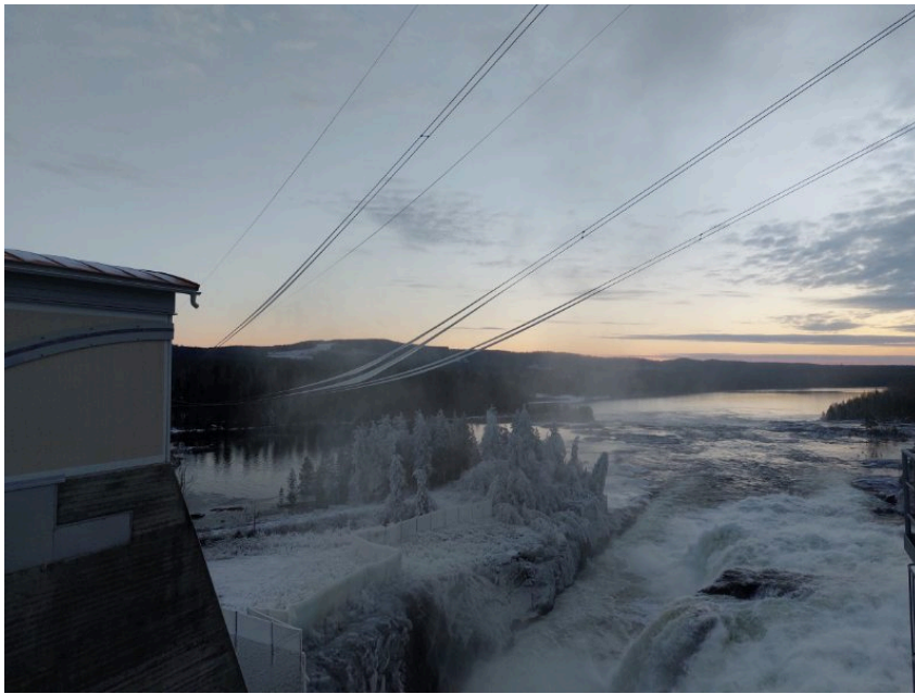
Figur 9-52 Ispåbyggnad på nedströms kraftledning från vattendimma.
