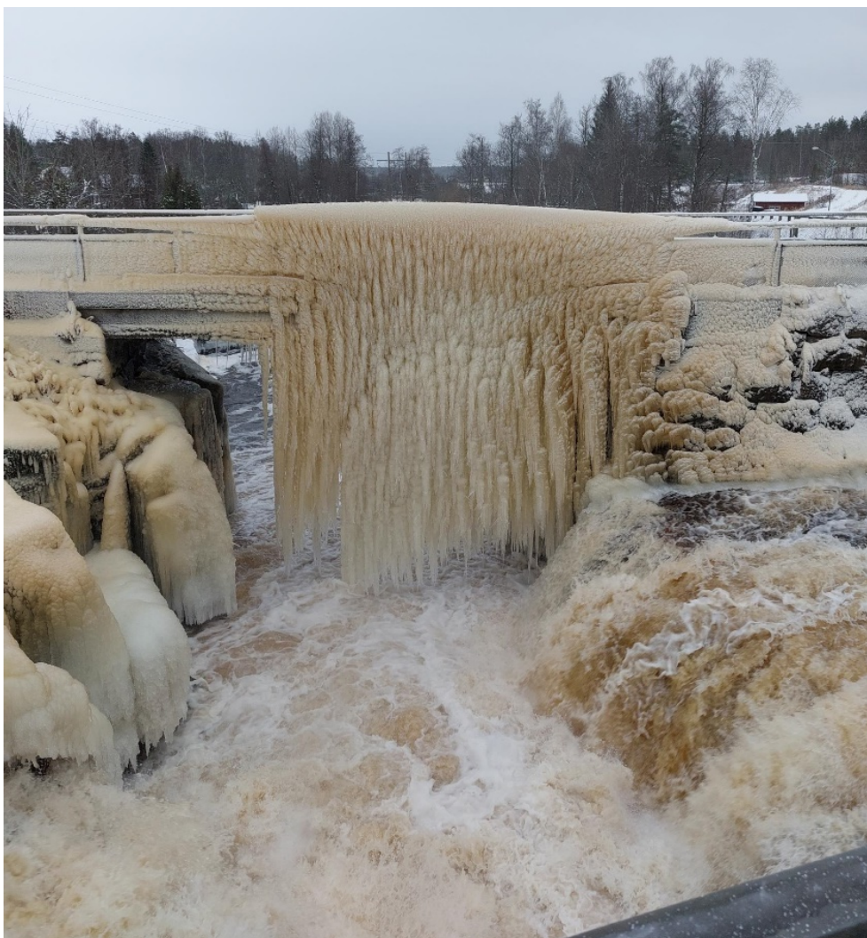
Figur 9-16. Bro strax nedströms av utskoven som presenterar inverkan av ispåbyggnad från vattendimma som bildats under vinterspill.
