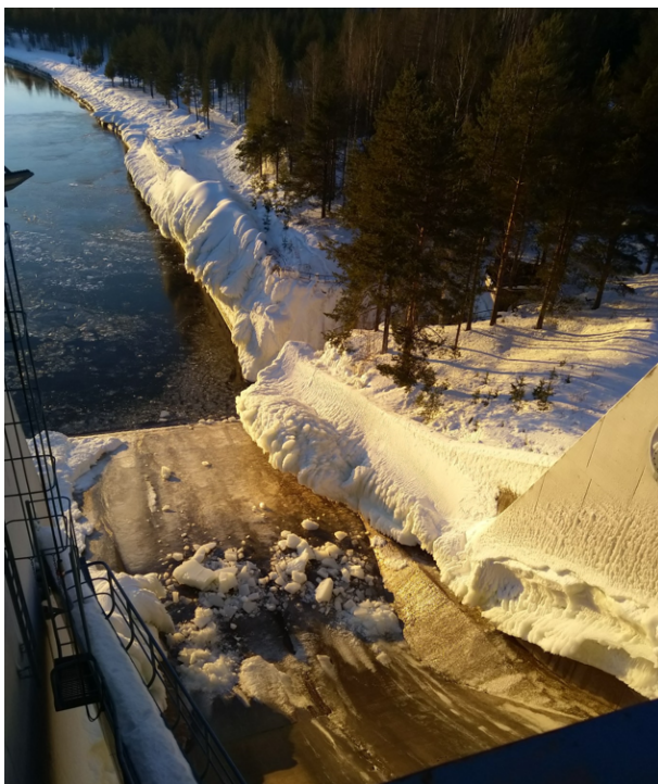
Figur 9-49 Isbildning på ledmur ns. -anläggning 3, januari 2022.
