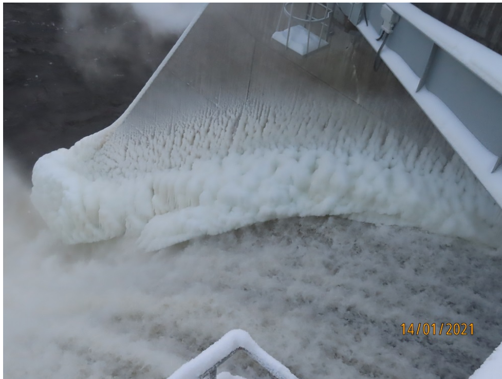
Figur 9-30. Ispåbyggnad på nedströms pelare som kontinuerligt växer på grund av skvätt och vattendimma.
