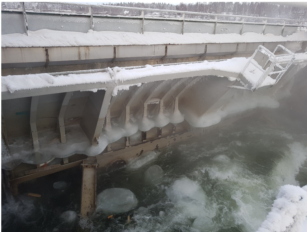
Figur 9-34. Ispåbyggnad på nedströmssidan av luckan med nedströms vattennivå som når upp till ungefär halva luckans höjd. Luckan är öppen så det är rörelse i vattnet där det även syns några isblock.
