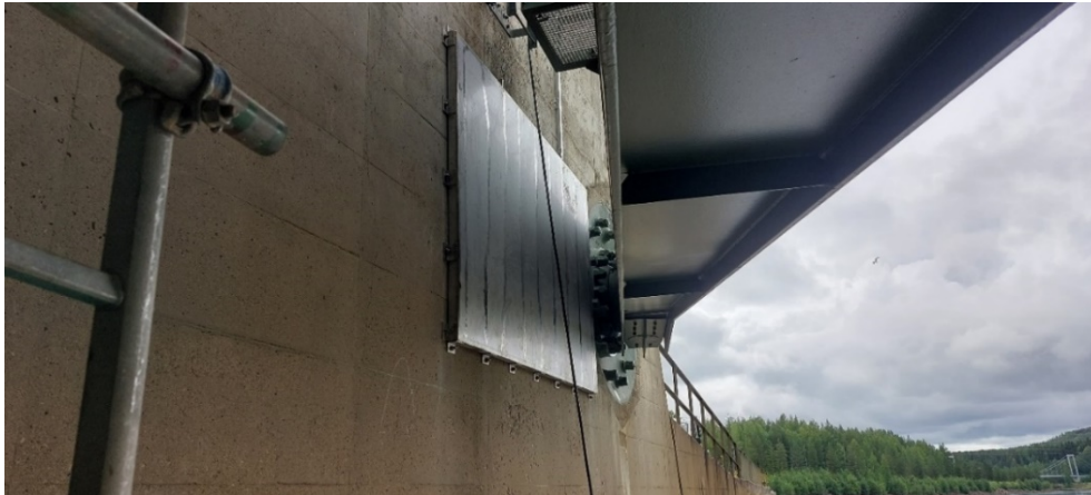
Figur 9-48 Exempel på värmeplåtar vid navet till luckan.
