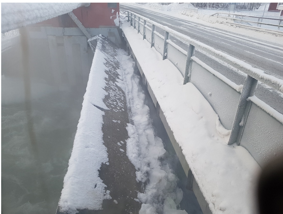
Figur 9-42. Ispåbyggnad vid bordläggning som resulterar i att det inte går att öppna då isen tar emot undersidan av bron.
