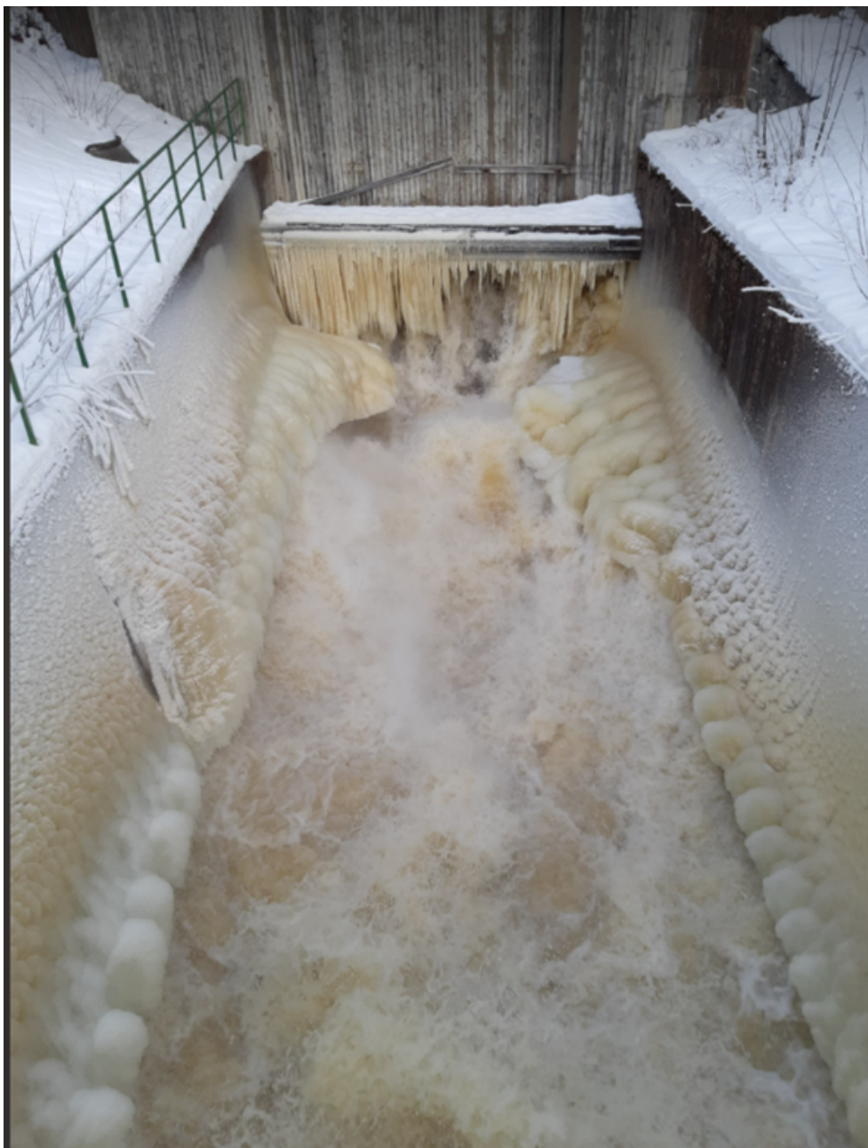
Figur 9-3. Klaffluckan tar 40 m 3 /s och går fullt på bilden, men det fattas nog ett antal m 3 /s här också p.g.a. isen. Isen byggde på betydligt mer innan allt var över.
