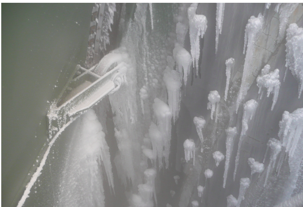
Figur 9-45 Is kring stödhjul, anläggning 1 2010.
