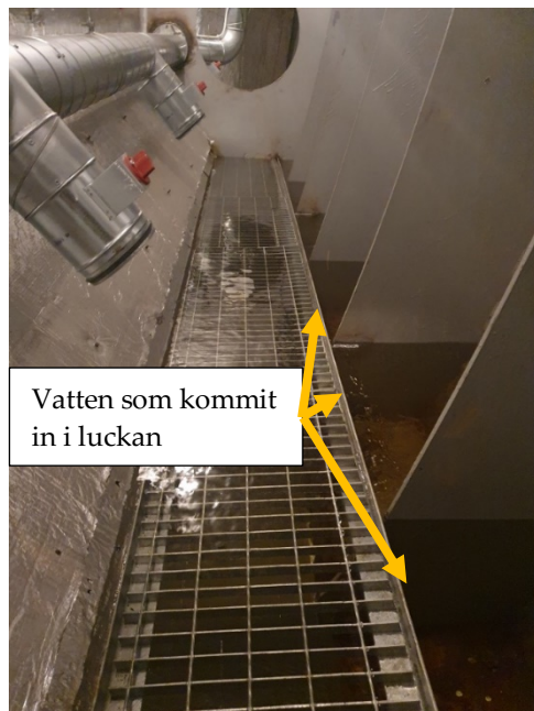
Figur 9-9. Vatten som träffat ispåbyggnad utvändigt och skvätt in genom dräneringshål och delvis fyllt luckan. Åtgärdsmetoden som vanligtvis används på den aktuella anläggningar är ångaggregat med lansar. Figur 9-10 visar typen av aggregat som ofta används, vilken kan transporteras på släp med personbil. I figuren kan man även se lansarna och tillverkade munstycken som har hål vid främre delen som möjliggör att spruta varm ånga längs med främre delen av munstycket. Den aktuella dammägaren har införskaffat 3 aggregat för att kunna sprida geografiskt och därmed möjliggöra att kunna åka ut och påbörja åtgärder relativt snabbt, oberoende av anläggning.
