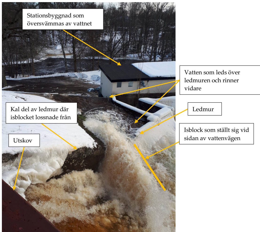
Figur 4-5. Isblock som ställt sig vid sidan av vattenvägen och agerar plog till vattnet som strömmar ut från utskovet. Vattnet lyfts upp över ledmuren så att det sedan kan rinna ner till stationshuset på nedströmssidan.
