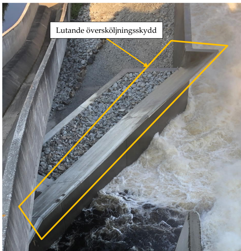
Figur 9-17. Bild av ledmuren med tillhörande översköljningsskydd vid spill då det är plusgrader ute.
