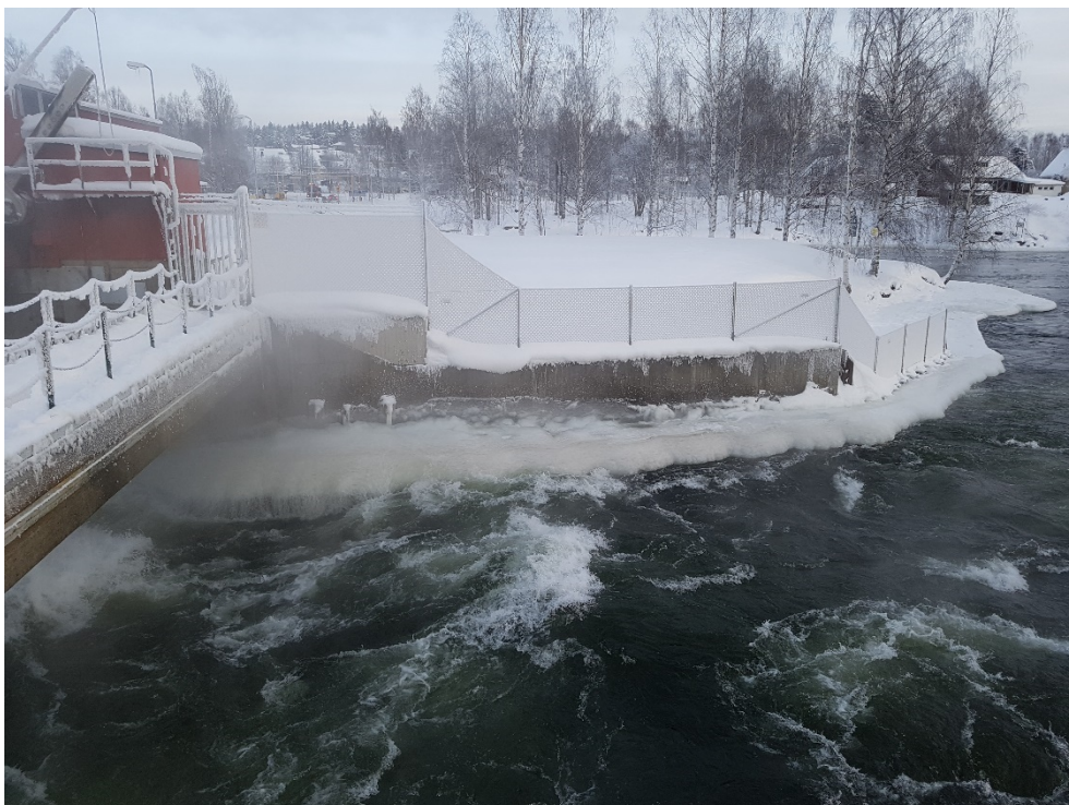
Figur 9-39. Ispåbyggnad på nedströms pelare och stödmur.
