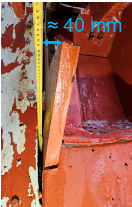
Figur 9-57 Här syns att infästningsplåten i luckan har tryckts ca. 40 mm åt sidan vid manövrering av luckan.
