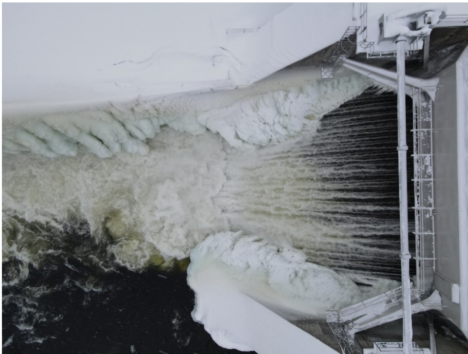
Figur 9-13. Ispåbyggnad nedströms ett utskov på pelare och ledmur sett ovanifrån.
