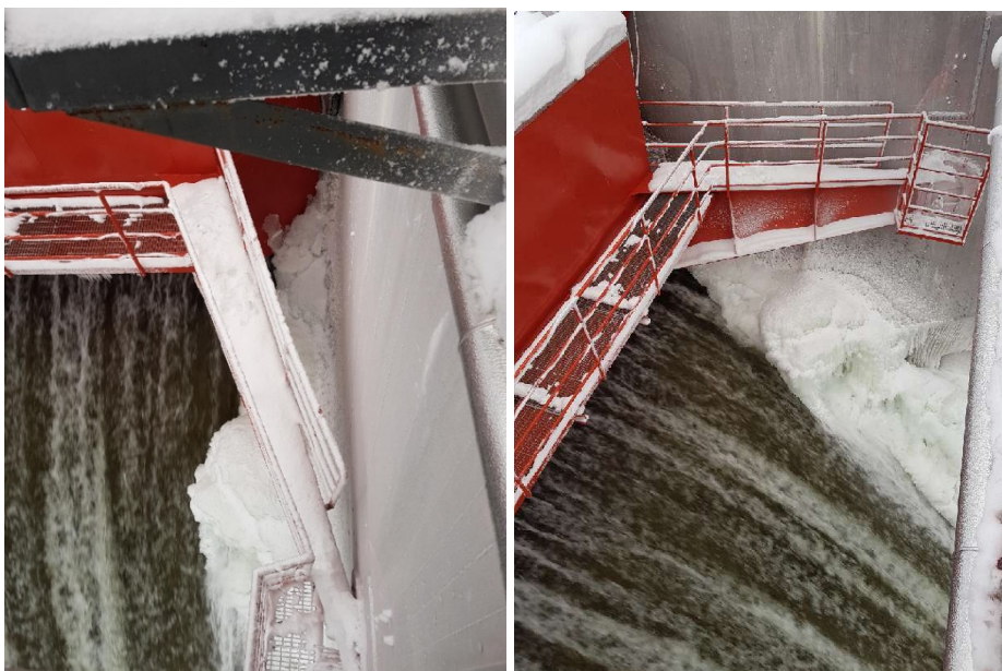
Figur 9-7. Ispåbyggnad på sidan av betongpelaren till höger om luckan.
