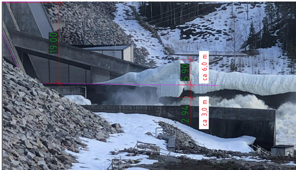
Figur 9-21. Mätningar för att uppskatta volym av ispåbyggnad.
