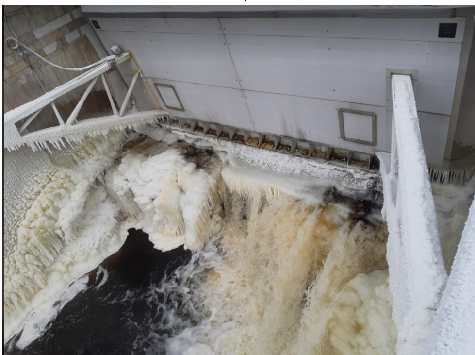
Figur 9-2. Lucka 6 har ett spill enligt hur mycket den är öppen på 26 \text{ m}^3/\text{s} men den avbördar endast några få \text{m}^3/\text{s} via en stril i mitten.
