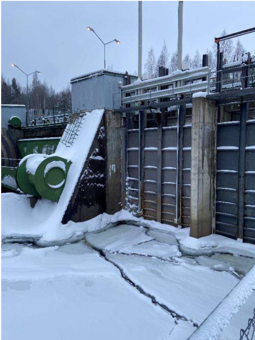
Figur 9-54 Fastfrusen planlucka som användes i projektet och testet.
