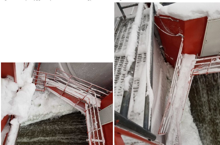
Figur 9-8. Ispåbyggnad på sidan av betongpelaren till vänster om luckan.
