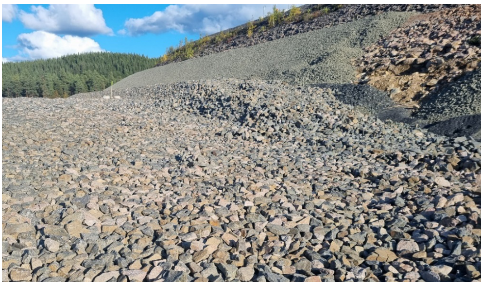
Figur 1. Nedströmssidan av en fyllningsdamm förstärks med erosionsskydd, vilket kommer att förlänga tiden för ett dammhaveri genom inre erosion att utvecklas.
