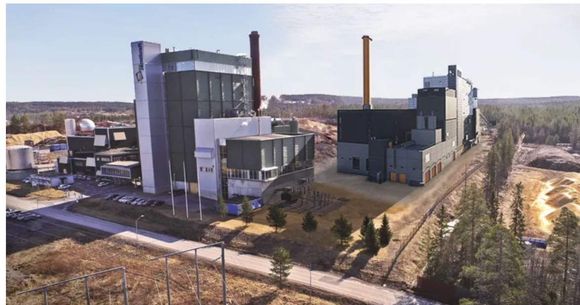
Metanolfabriken kommer att byggas intill Jämtkrafts kraftvärmeverk i Lugnvik. Foto: Jämtkraft
