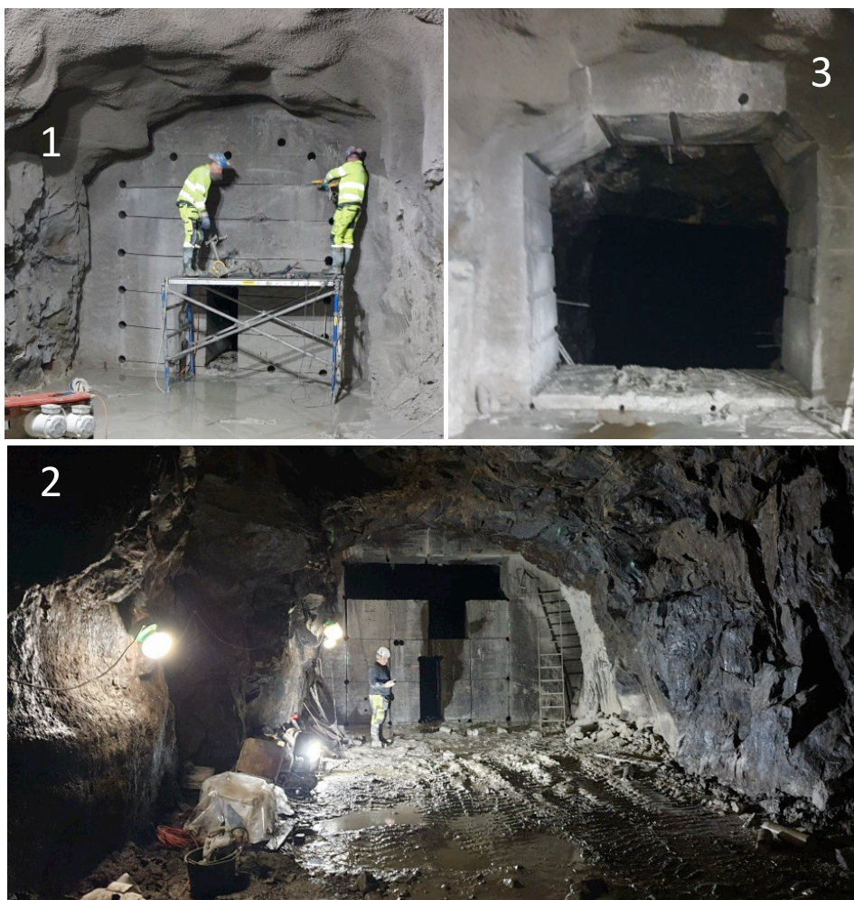
Figur 43 Håltagning av betongförsegling. 1: Borrning genom 2 m betong, 2: Betongblock sågades ut ur pluggarna 3: Färdig öppning.
