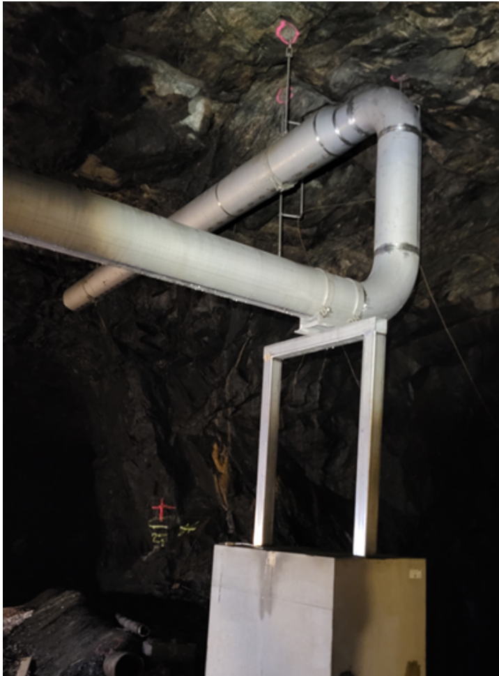
Figur 34 Varma dysan i övre delen av bergrummet. Ledningen fortsätter till vänster mot pump och VVX. Foto: Mälarenergi.
