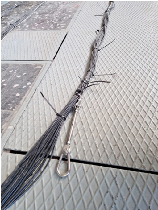
Figur 53 Givarkablage kopplat till stålwire.
