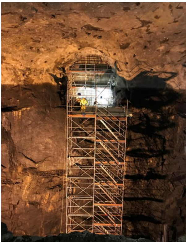
Figur 10 Arbete under konvertering av oljebergum i Hudiksvall. 10
