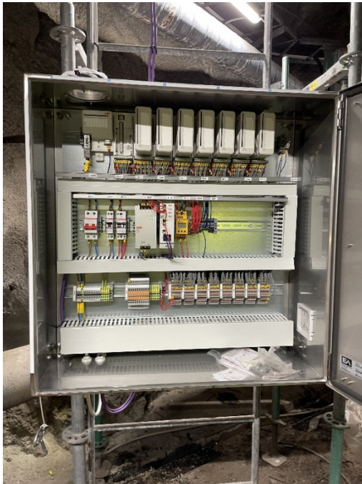
Figur 67 Mätkopplets apparatskåp för loggning av temperaturen.
