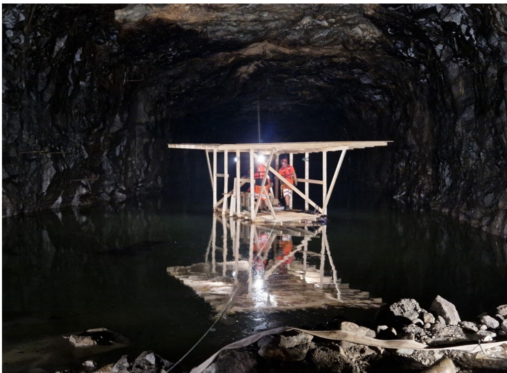
Figur 55 Flotte med dykare och platsbyggt tak för skydd mot ev. lösa stenar.
