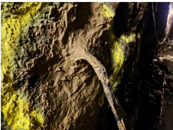
Figur 64 Borrhålet fyllt med injekteringsmassa.
