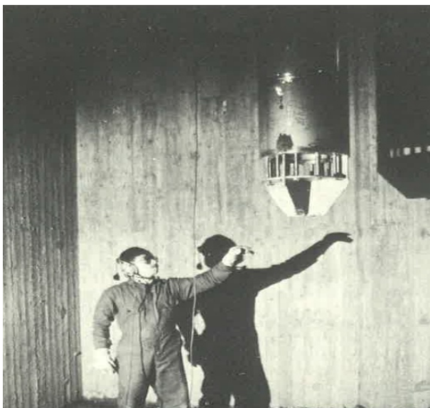
Figur 4 Montage av in/utloppsrör med diffusor, Lyckebo. 5
