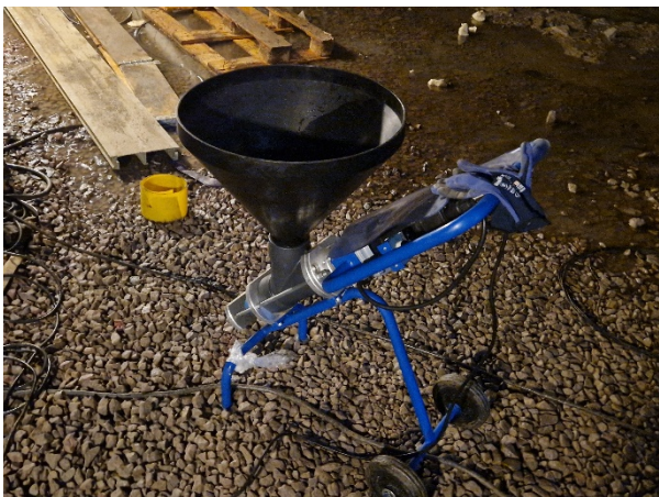
Figur 62 Bild på Injekteringsutrustningen som användes.
