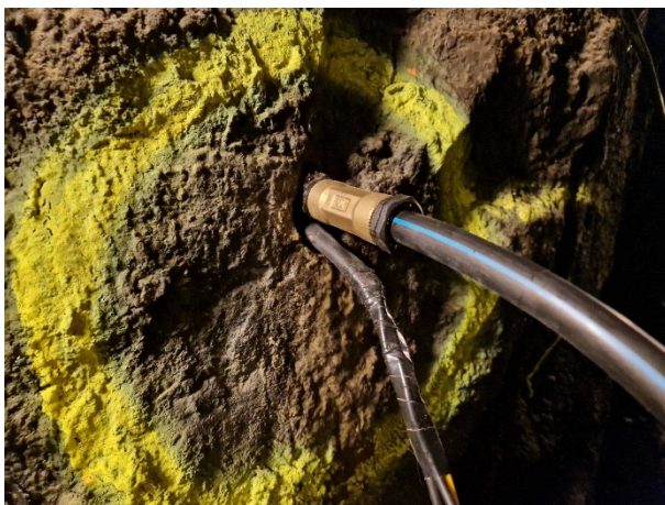
Figur 63 Borrhålet med infört mätkoppel och injekteringsslang.
