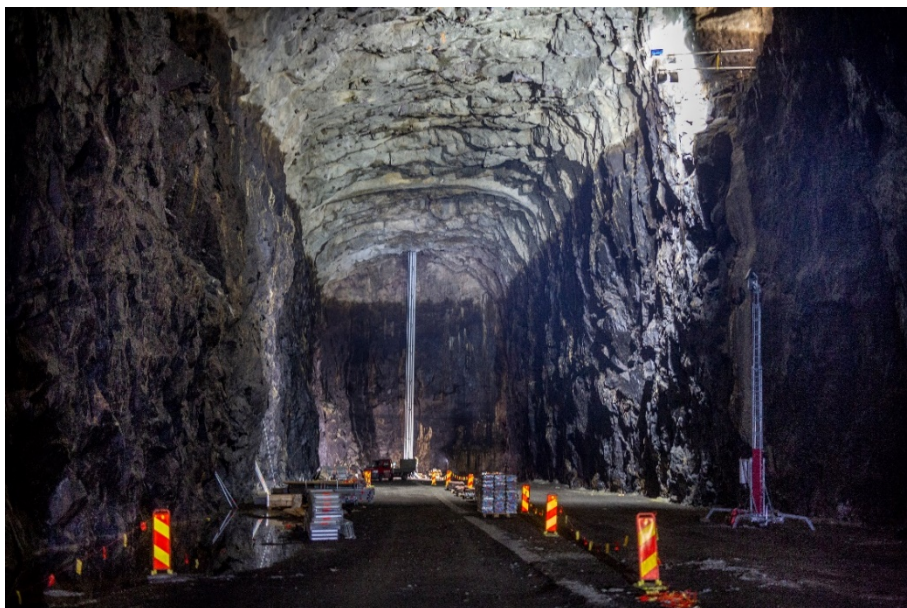
Figur 11 Ett av bergrummen i Hudiksvall under ombyggnaden. Bergrummen är 25 meter höga och 18 meter breda. Foto: Lars Sundin
