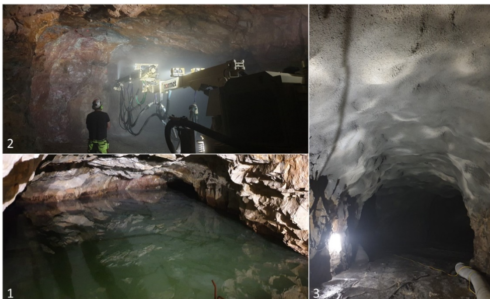
Figur 42 Förarbeten i nedfartstunnel till bergrum 102 och 103. 1: Läckvattensjö före pumpning, 2: Högtryckstvätt för att få loss lösa stenar i bergväggar och tak 3: Tunneltaket fixerat med sprutbetong
