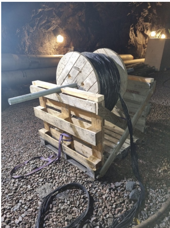
Figur 56 Kabeltrumma med kablage på land.
