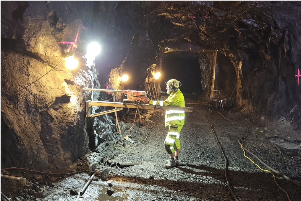
Figur 60 Borrning av hål för givare för temperaturuppföljning i bergväggen C102. Foto: Mälarenergi.
