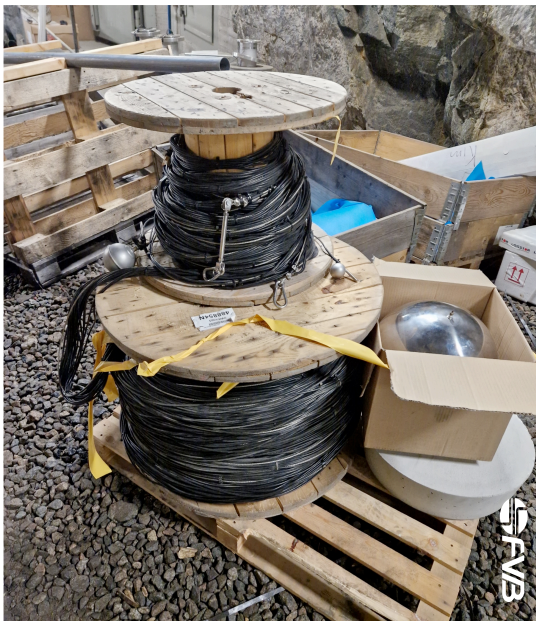
Figur 54 Mätkoppel upprullat på kabeltrummor för installation i bergrumscisternen.
