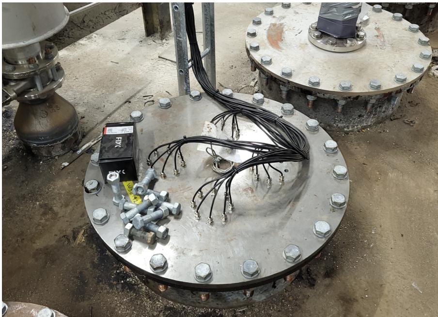
Figur 66 Genomföringstuts med givarkopplets kablage.
