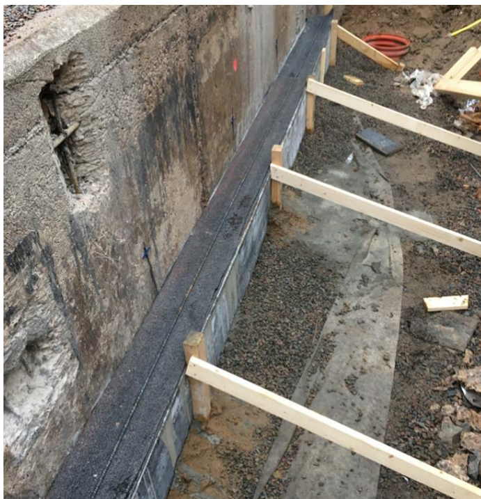
Figur 14. Nygjuten vot med ingjutet anodband (foto Öresundskraft).
