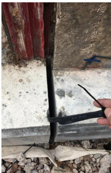
Figur 16. Påsvetsade bygeljärn för att erhålla elektrisk kontinuitet mellan stålarmeringen hos voten.
