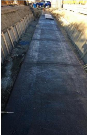
Figur 19. Tätning av betongkulvert (foto Öressundskraft)
