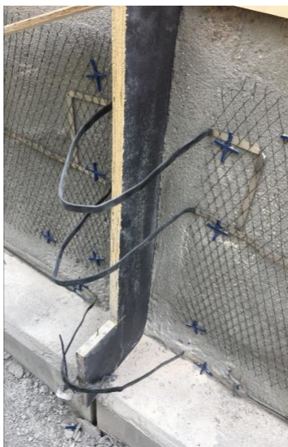
Figur 17. I hopskarvning av titannät mellan olika betongkulvertar (foto Öresundskraft).
