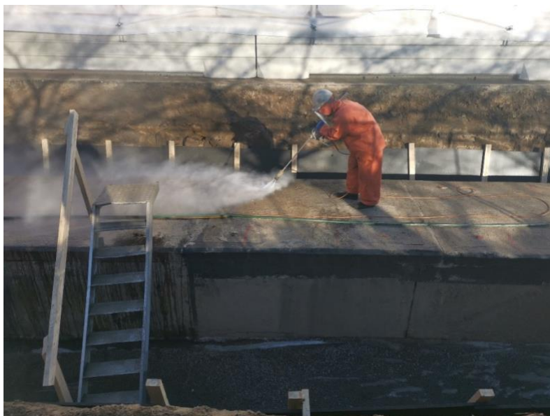
Figur 10. Högtryckstvätt av betongkulvert (foto Öresundskraft).
