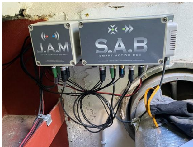
Figur 4. Mätningar utförda med akustiska ljudvågor (Delta-T) (foto Öresundskraft)
