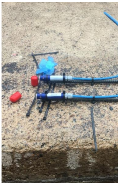
Figur 12. Referenselektroder av mangandioxid som monteras fast på armeringen före betonglagning (foto Öresundskraft)
