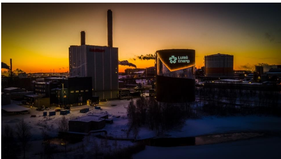
Figur 13 Luleå Energis hetvattenackumulator, 30 000 m 3 som invigdes 2022. Källa: Luleå Energi
