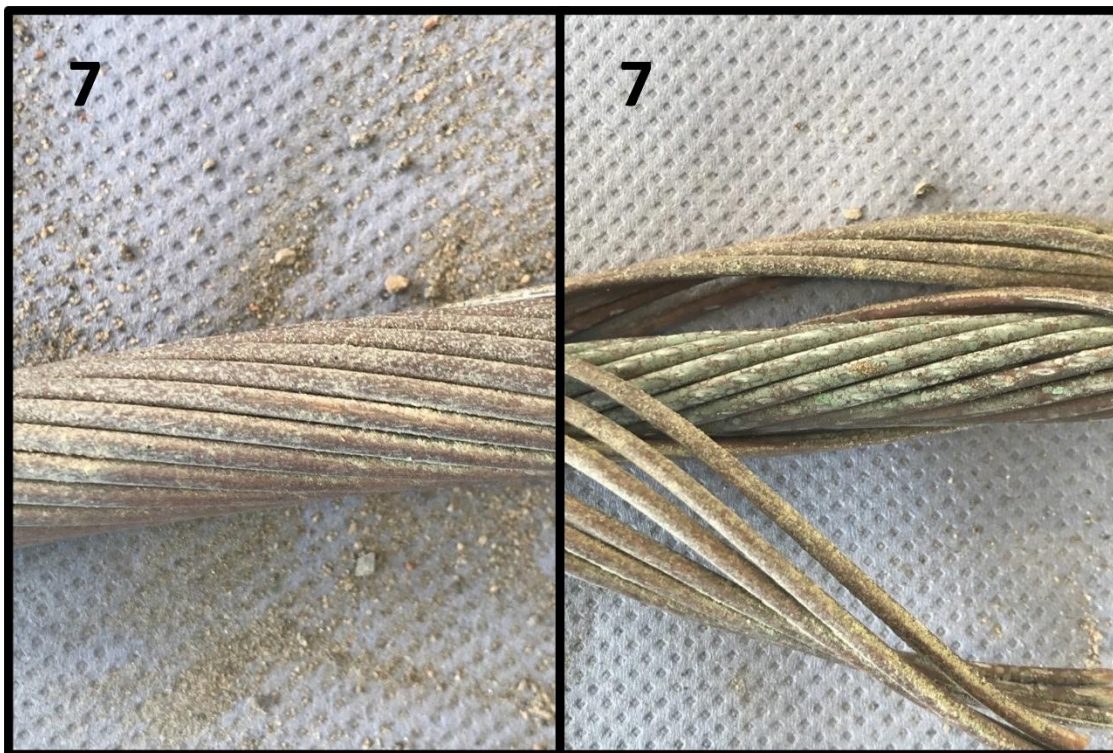
Figur 25: Närmare inspektion prov 7.
