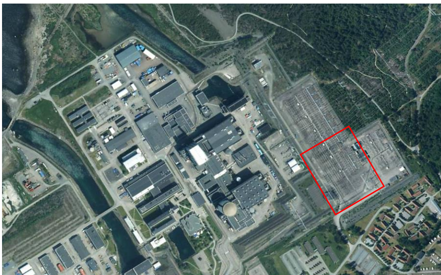
Figur 2. Ställverket där undersökningen utfördes är markerat med rött
