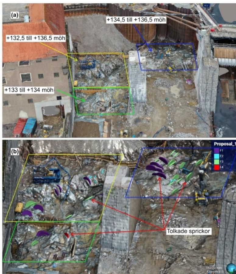
Figur 15 Övergripande bild över den uppbyggda 3D-modellen utifrån drönbilder för dammanläggning 1: (a) med uppmätta bergnivåer från uppbyggd 3D-modell utifrån drönbilder tagna i områden med rensad berggrund; (b) med karterade sprickor tolkade med programvarorna CloudCompare och Leapfrog.
