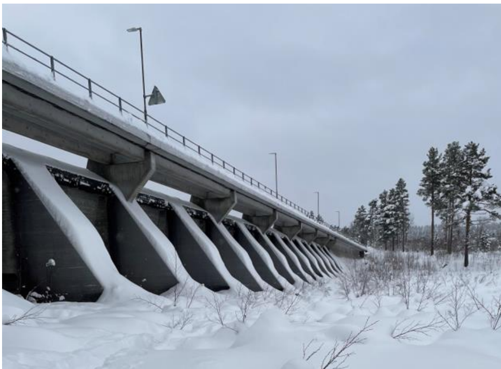
Figur 6. Anläggning 3. Bild från platsbesök.
