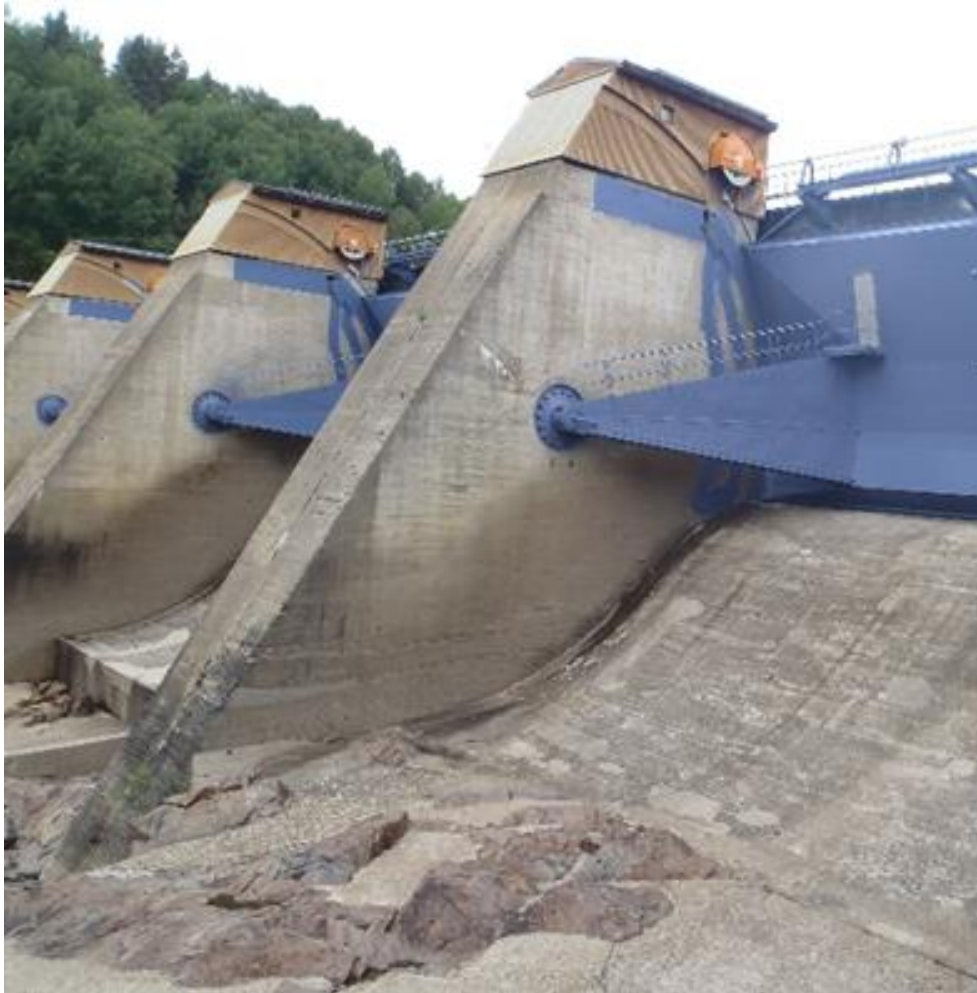
Figur 13. Anläggning 10. Bild från platsbesök.
