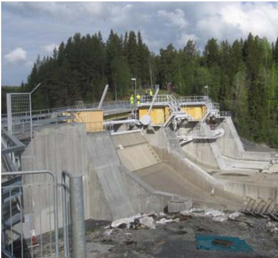
Figur 8. Anläggning 5. Bild från platsbesök.
