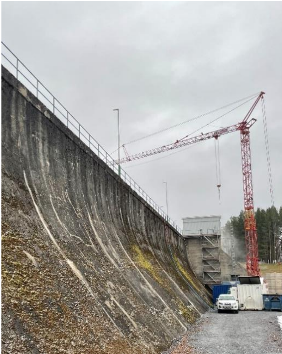
Figur 4. Anläggning 1. Bild från platsbesök.
