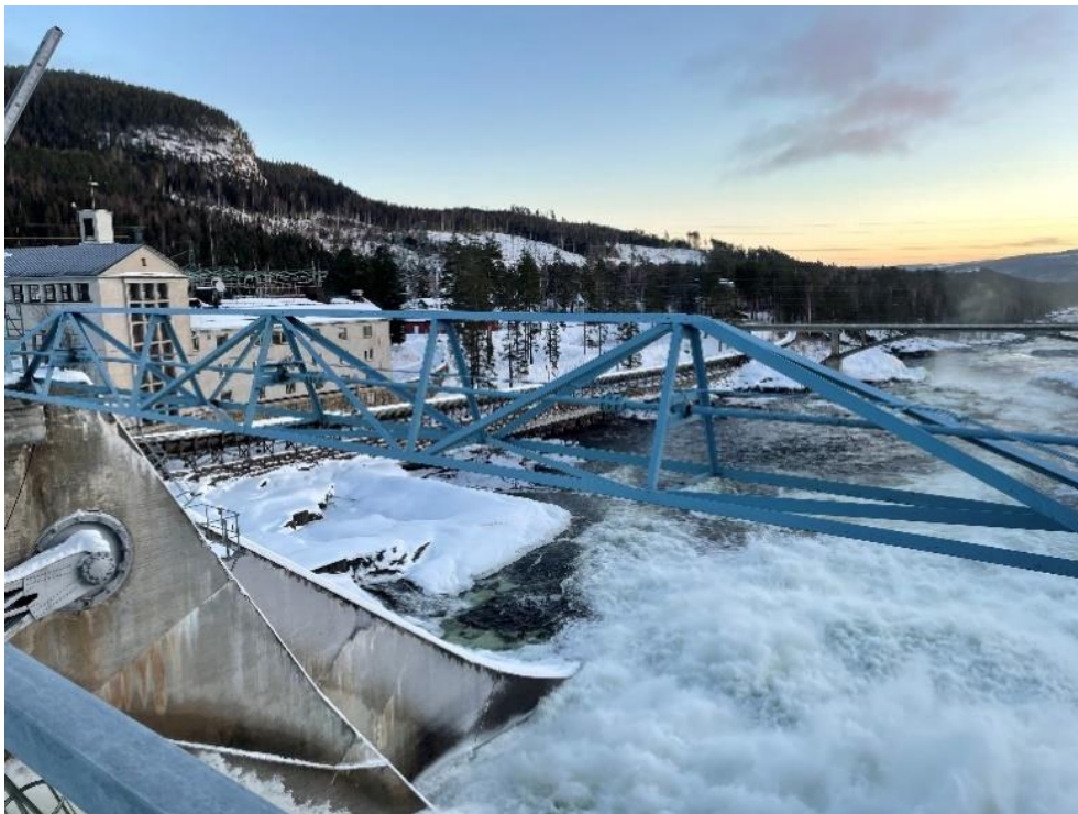
Figur 7. Anläggning 4. Bild från platsbesök.
