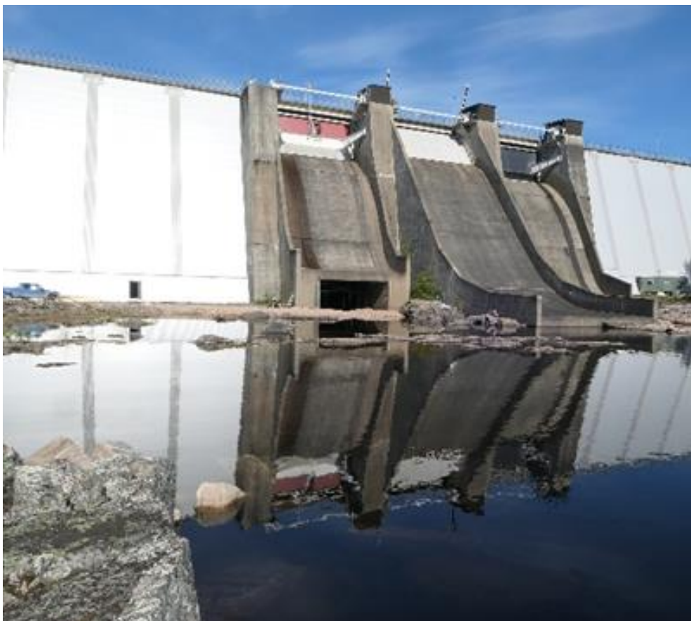
Figur 9. Anläggning 6. Bild från platsbesök.
