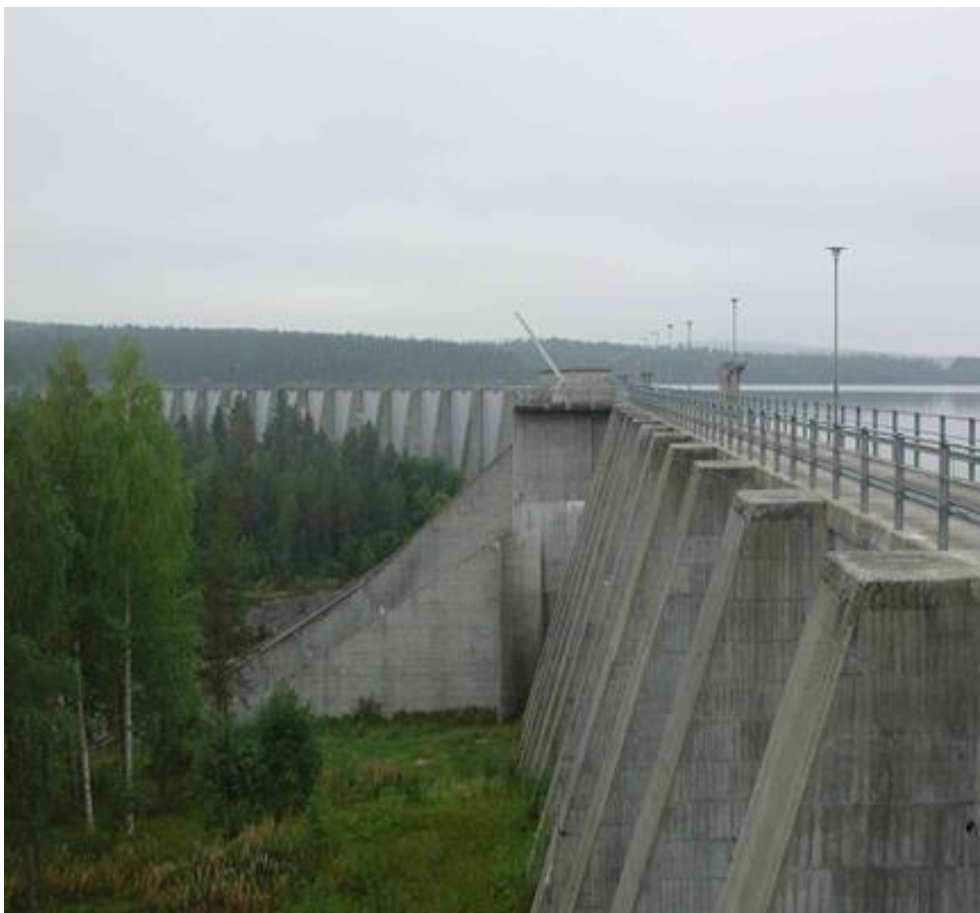
Figur 11. Anläggning 8. Bild från platsbesök.
