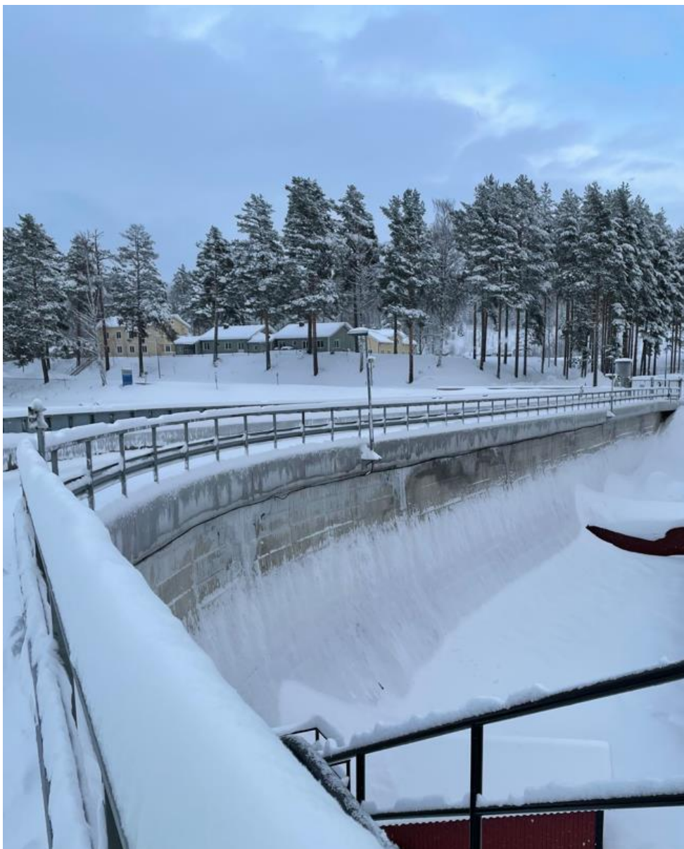
Figur 12. Anläggning 9. Bild från platsbesök.
