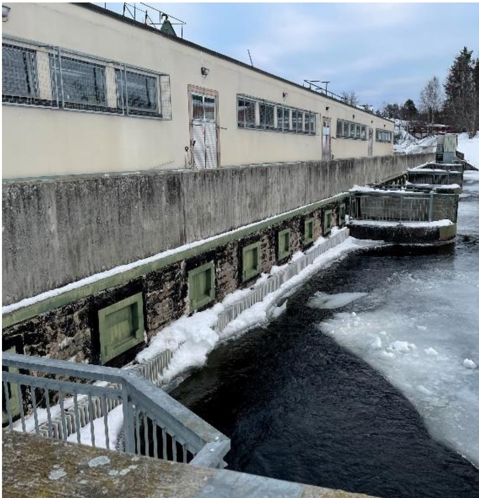
Figur 16. Anläggning 13. Bild från platsbesök.
