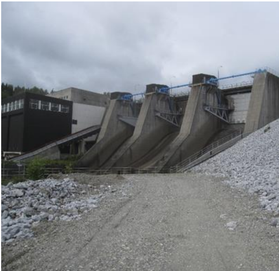
Figur 14. Anläggning 11. Bild från platsbesök.
