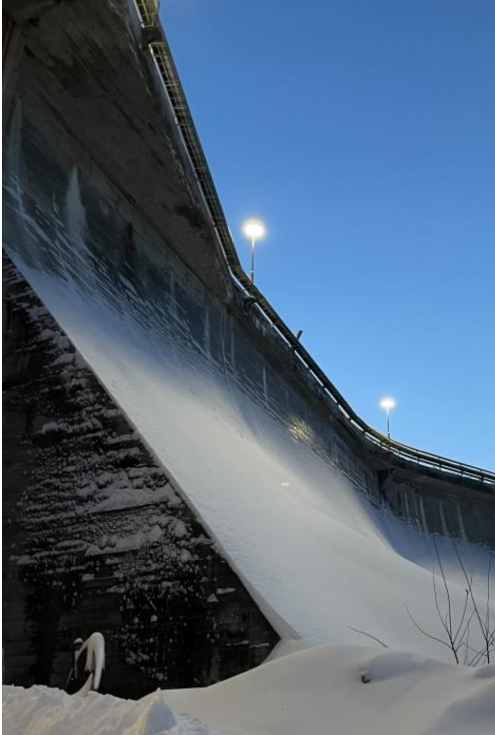
Figur 5. Anläggning 2. Bild från platsbesök.
