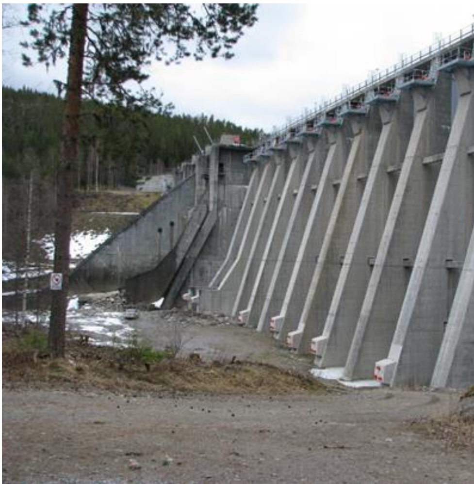
Figur 10. Anläggning 7. Bild från platsbesök.
