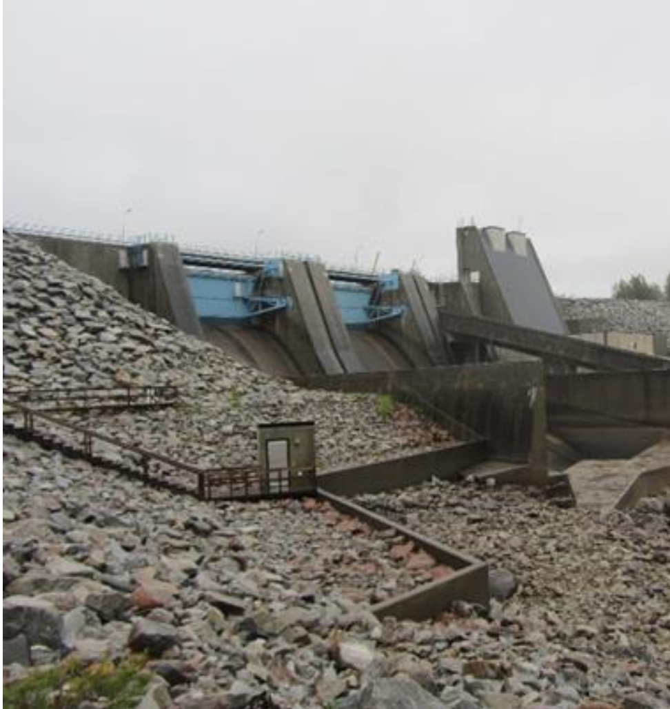
Figur 15. Anläggning 12. Bild från platsbesök.
