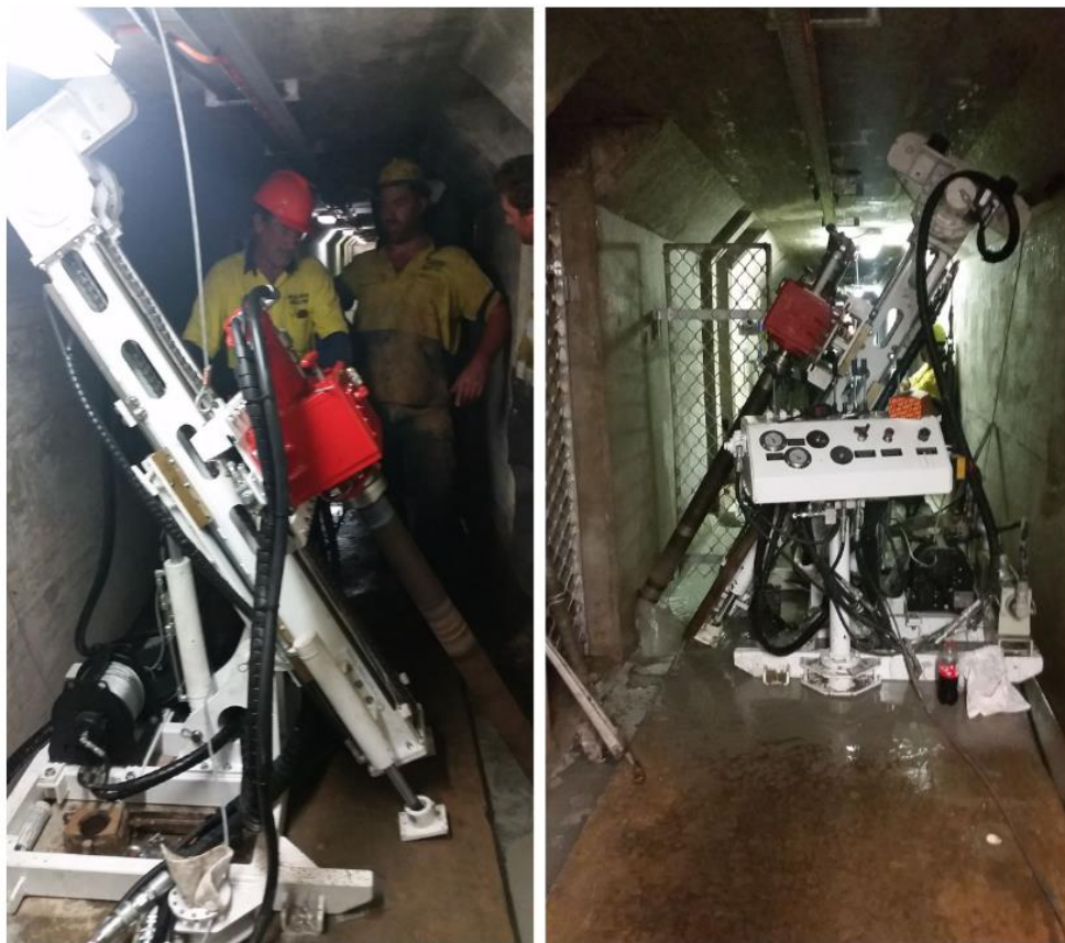
Figur 13. Trippeltubskärnborrning med 94 mm (HQ3) borrhål med DT Gallery Rig vid Somerset Dam (Bild: Mulligan Geotechnical).
