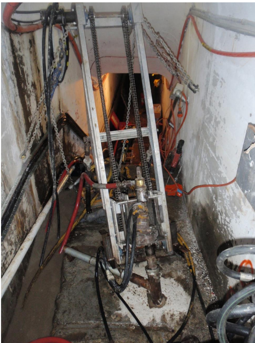
Figur 16. 1750 Scout vid borrning i galleri vid Burdekin Dam. Returvattnet fördes mot dräneringsfåran till vänster i bild (Bild: Mulligan Geotechnical).
