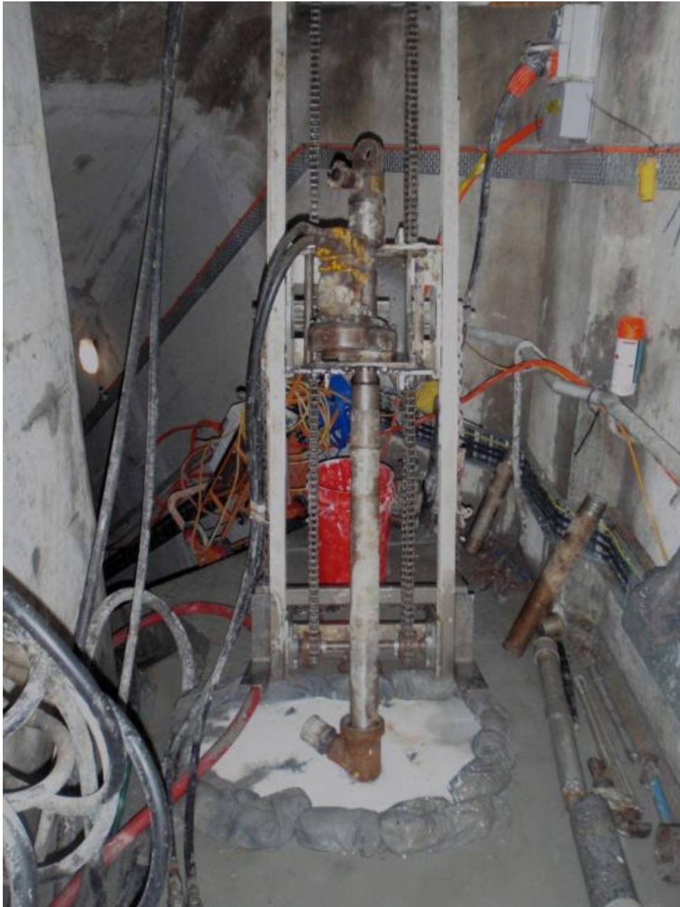
Figur 11. 1750 Scout-borrigg med montering för kranventil vid borrhålsmyningen för hantering av vattenupstryck ur borrhålet. Bilden är tagen i samband med ett annat uppdrag (Bild: Mulligan Geotechnical).
