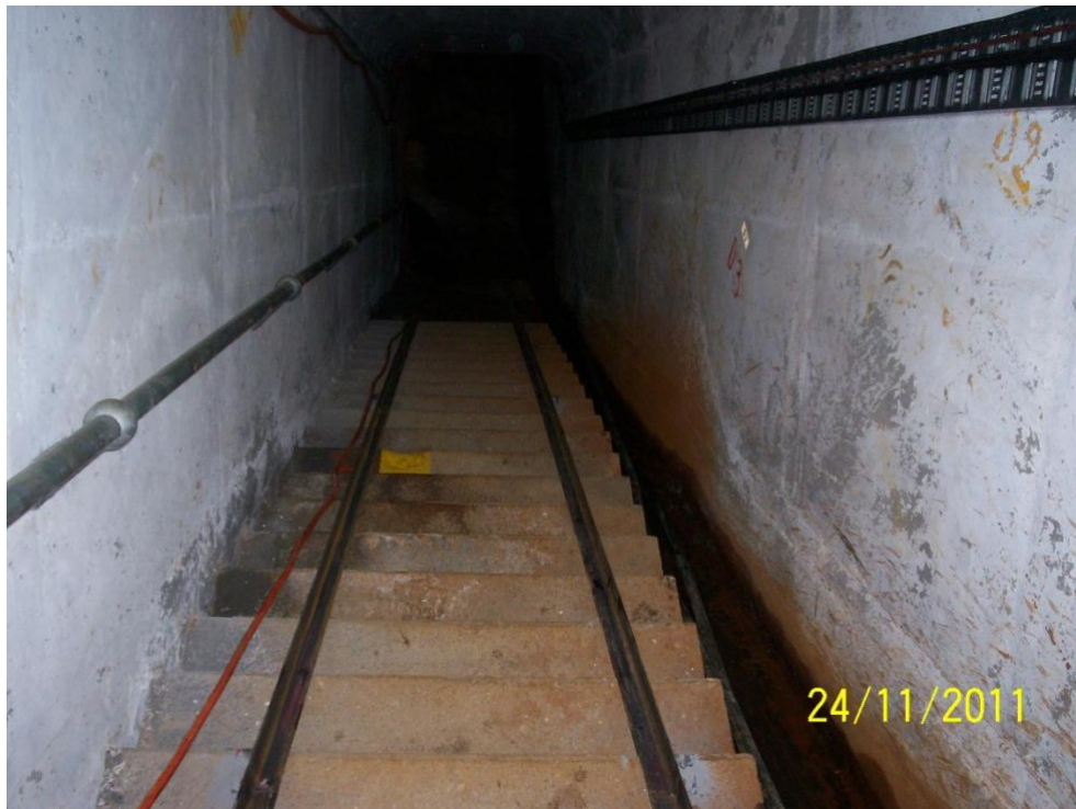
Figur 14. Järnramp vid trappa för transport av borrhög och övrig utrustning på släde och vagn i Burdekin Dam (Bild: Mulligan Geotechnical).
