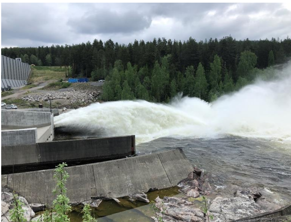
Figur 3 Exempel på ett bottenutskovs-utlopp med strålupplyftare. Foto av Uniper.
