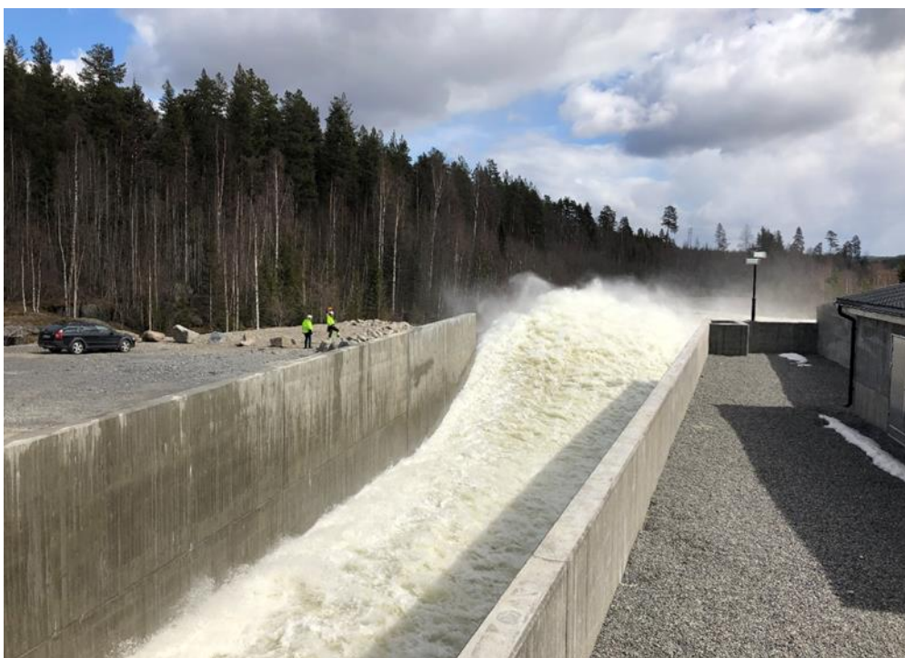
Figur 2. Spill från bottenutskov med rak utloppskanal. Foto av Uniper.
