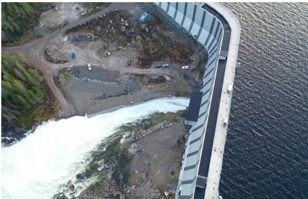
Figur 1. Spill från bottenutskov med krökt utloppskanal. Foto av Uniper.
