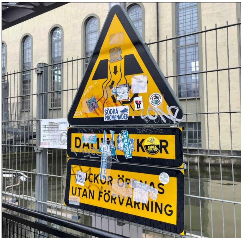
Figur 2. Exempel på en varningsskylt som är i dåligt skick och bör bytas ut. Skylten sitter vid en dammanläggning belägen mitt i en stad. Graffiti och klistermärken gör att budskapet/varningen på skyltarna inte når fram till allmänheten. Foto: Lisa Carlsson, Sweco.
