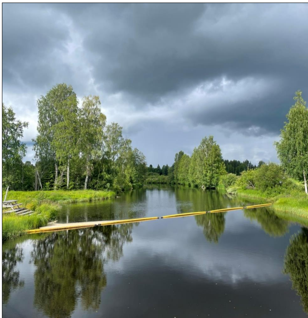
Figur 6. Exempel på avspärrning med säkerhetsbommar uppströms vattenkraftanläggningen Mjövattsforsen i Bureälven, Skellefteå kommun. Foto: Lisa Carlsson, Sweco.
