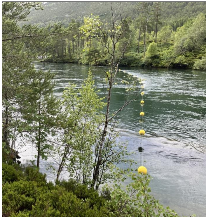
Figur 8. Exempel från Norge där en luftspänd markeringslina, p.g.a. hög vattenföring i älven, ligger i vattnet. Kulorna utmed linan döljs också delvis av vattnet och blir därmed svårare att se. Foto: Ingvill Storøy, Sweco.
