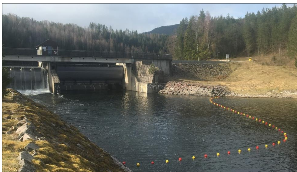
Figur 9. Exempel på markeringslina nedströms Statkrafts vattenkraftanläggning vid Hogga, i Telemarkskanalen i Norge, vilken är avsedd att varna människor som färdas i båt eller paddlar kanot/kajak. Foto: Bent Kristian Hasle, Vassfall.
