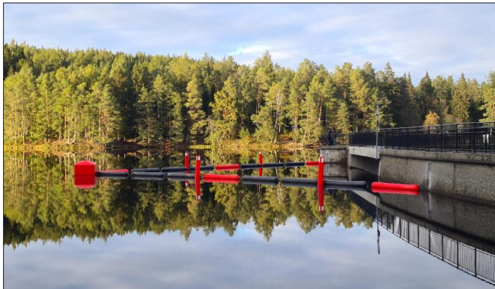
Figur 7. Exempel på avspärning med säkerhetsbommar i magasinet Baklidammen i Trondheims kommun, Norge. Under sommaren är syftet att förhindra att människor åker ner över överfallsdammen och på vintern är syftet att varna för osäker is framför dammen. Foto: Benedicta Kiplesund, Trondheim kommun.
