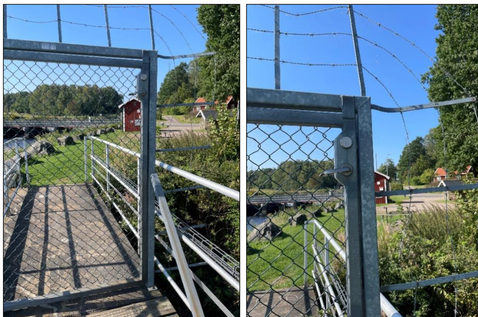
Figur 5. En vattenkraftanläggning där dammkrönet är försett med en grind, där handtaget för att öppna grinden har flyttats så att det är utom räckhåll för små barn. Foto: Lisa Carlsson, Sweco.
