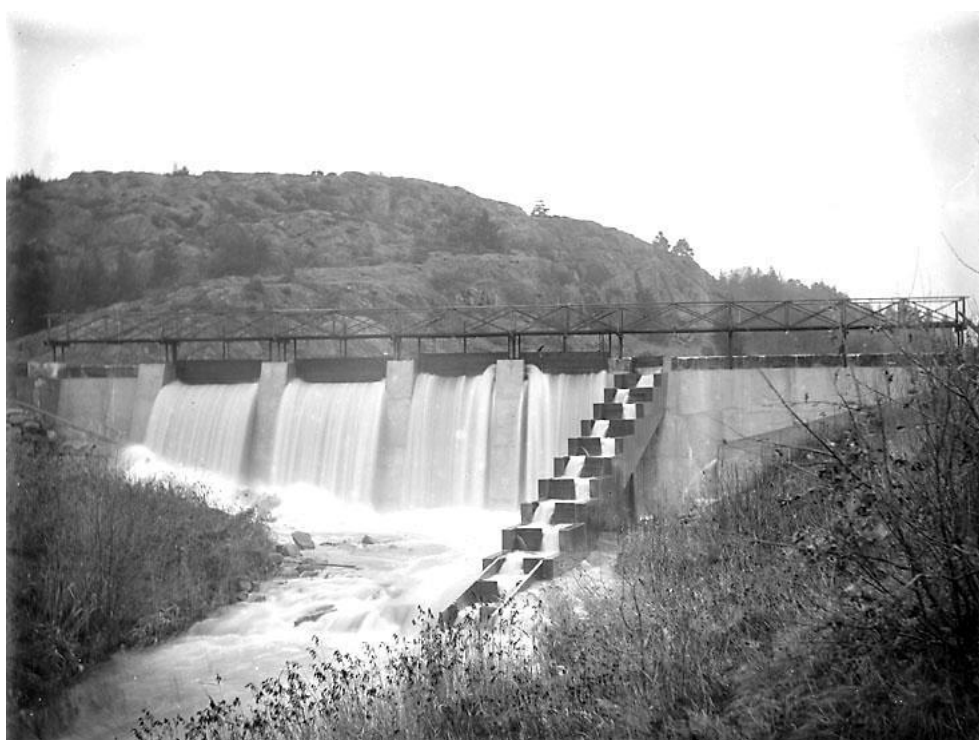
Figur 23. Laxtrappa i form av bassänger och fackverk vid Trollsjön, från 1910-talet 85 .
