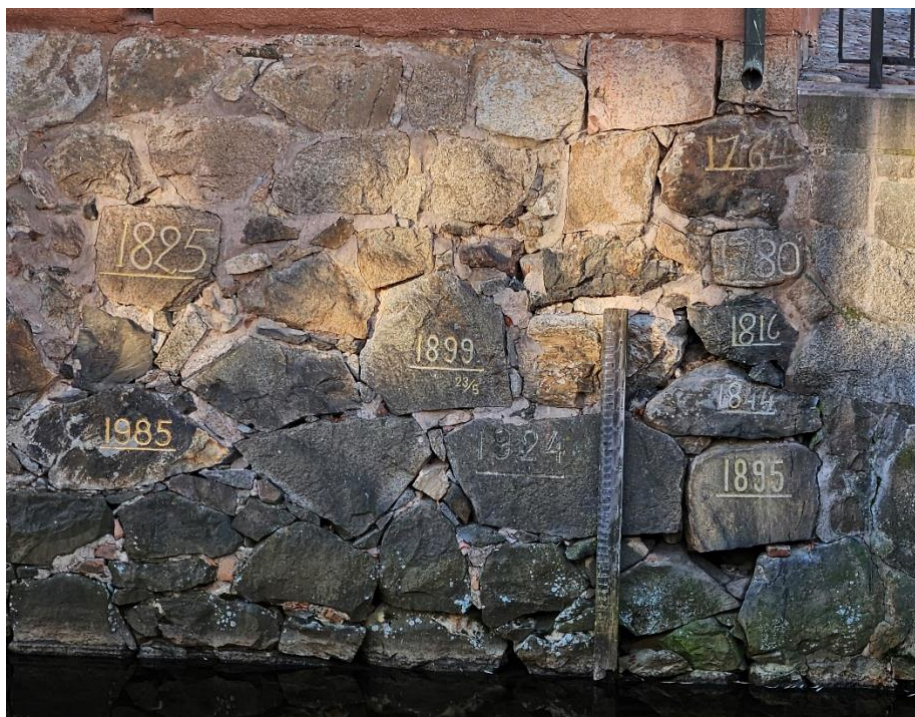
Figur 17. Inristade högvattenmärken på grunden till Kopparvågen invid Faluån. Årtalen sträcker sig från 1764-1985.
