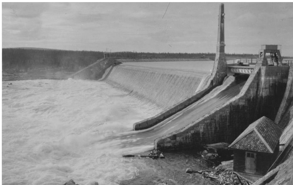
Figur 9. Nåldammar, som här vid Porjus, medgav en bred öppning i utskovet 13 .
