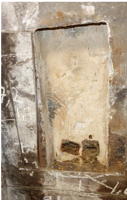
Figur 3: Avtryck i betong från träregeln, vilket visar orienteringen på träfibrerna.
