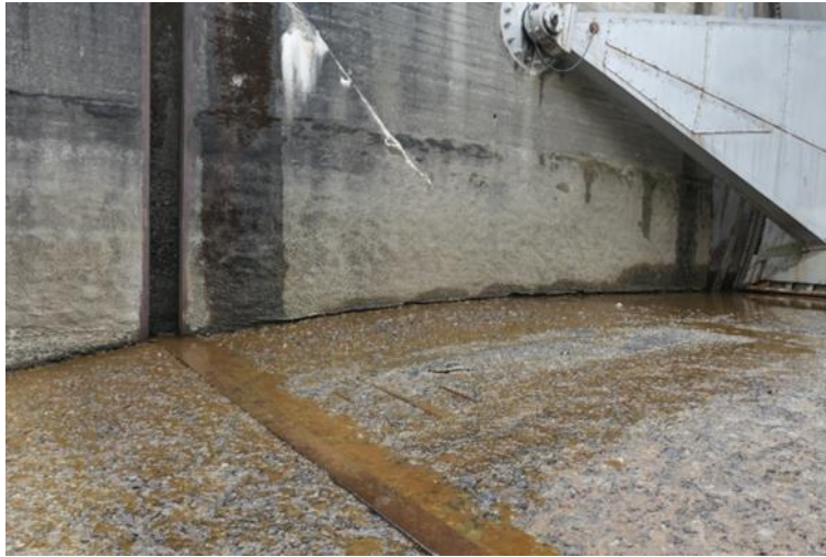
Figur 33 – Skibordets yta. Mittpunkten av den sektion som ska åtgärdas med fiberarmerad betong ligger cirka 5,5 m uppströms från sättfalsens mittpunkt.
