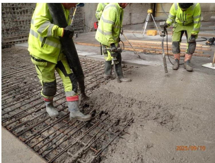
Figur 49 – Betongplacering med hjälp av pumpslang och betongkompaktering med stavvibrator.
