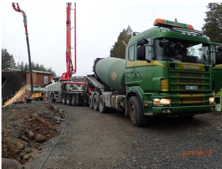
Figur 42 – Betongbil och betongpumpbil.
