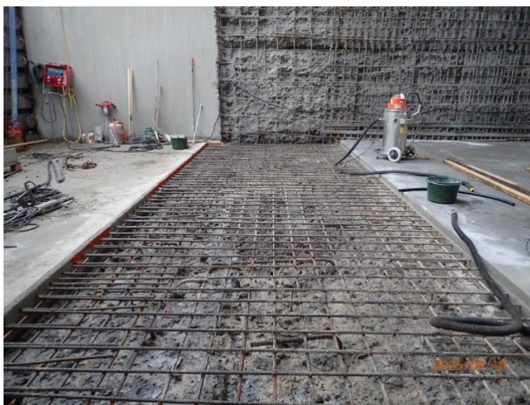
Figur 39 – Sektionen som gjuts med fiberarmerad betong.
