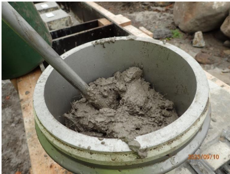
Figur 45 – Placering av färsk fiberarmerad betong i lufthaltsmätarens behållare.
