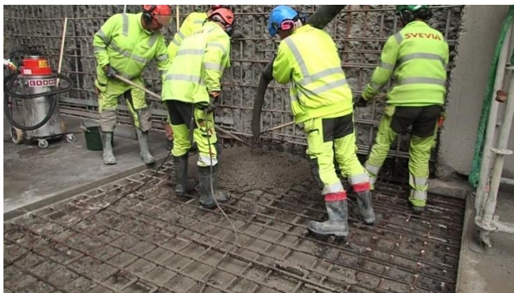
Figur 48 – Starten på gjutning med fiberarmerad betong.
