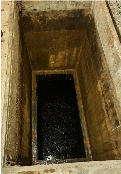
Figur 14 – Vy av en sugrörsbotten sett från ett schakt över sugröret.
