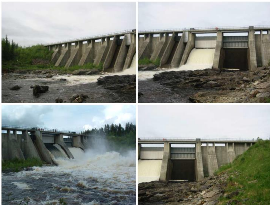
Figur 3-1 Skålandammen (sett från nedströmssidan). Uppe till vänster visas typmonoliterna 15-10, uppe till höger visas utskoven monolit 9-4 och nere till höger visas typmonoliterna 3-1. Nere till vänster visas utskoven vid spill av vatten. Foto: Norconsult (2004)
