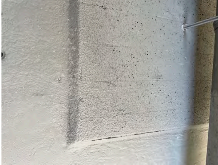
Figur 59. Lokalt reparerad betongyta med kloridiniterad korrosion på stålarmning. Det täckande betongskiktet har ökats med ca 20 mm.
