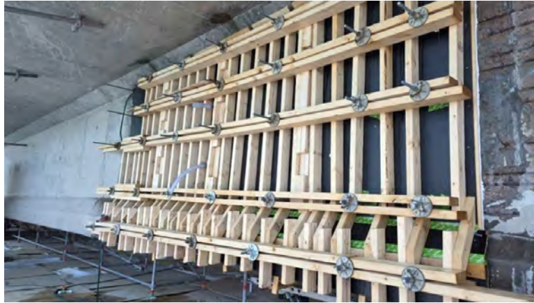
Figur 50. Färdig monterad gjutform
