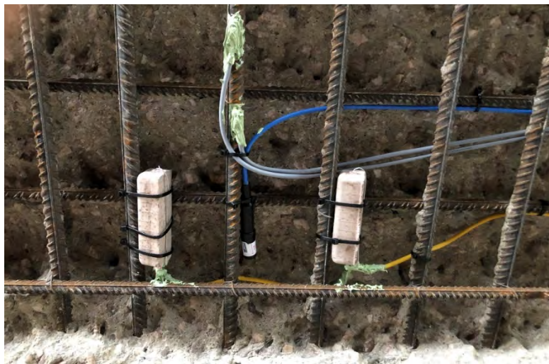
Figur 45. Två monterade Galvashield XP 4 anoder och en referenselektrod av MnO_2/Mn_2O_3 (Statens vegvesen)
