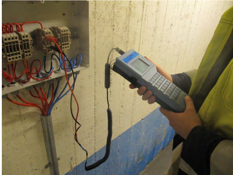
Figur 39. Mätning av strömgivning från offeranoder av zink i betong
