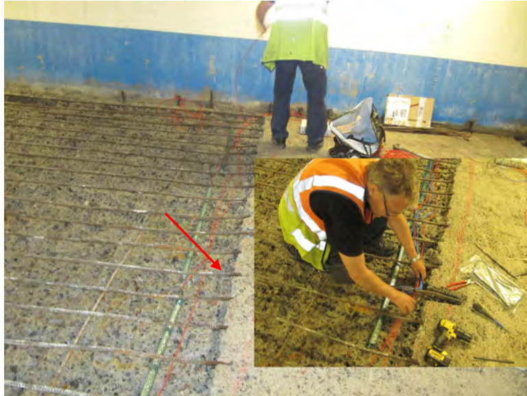
Figur 35. Installation av offeranoder av Galvanode DAS 89 (grönfärgad anod)
