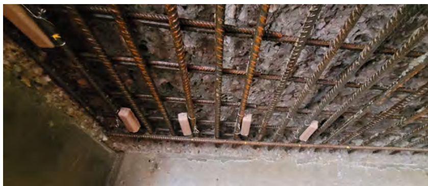
Figur 42. Monterade offeranoder av zink (Galvashield XP 4)
