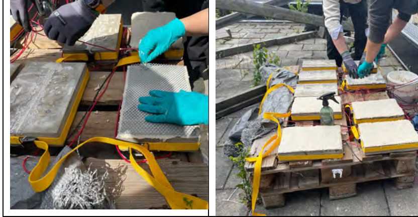
Figur 33. Montering av zinknätanod på betongblock.
