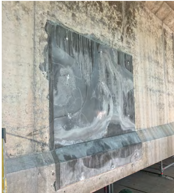
Figur 51. Lokalt reparerad betongyta med ett ökat täckande betongskikt av ca 15 mm.
