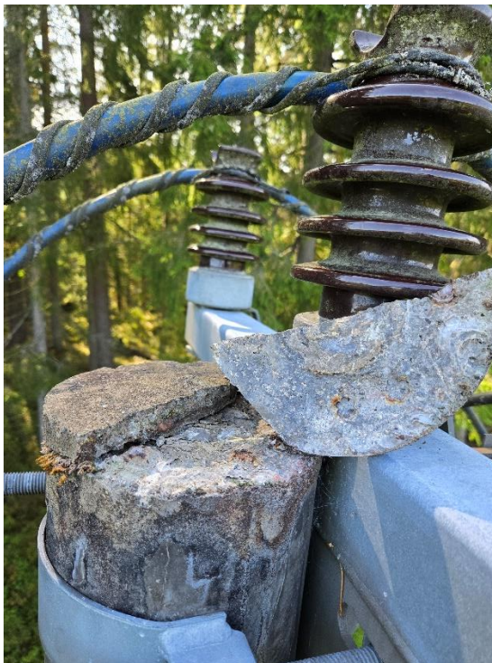
BILD 7. Stolpens övre del med skadat betonglock.
