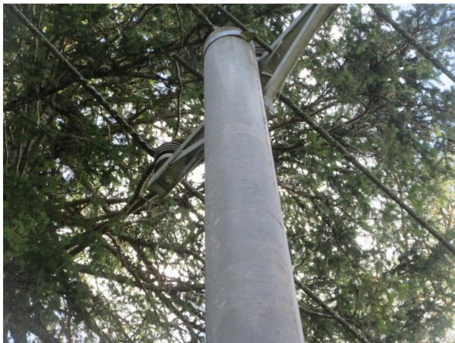
Figur 2. Stolpe utan anmärkning (skadegrad = 0)
