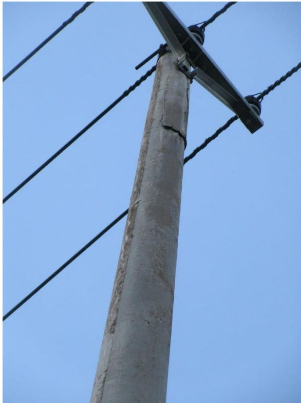
BILD 4. Kraftiga spjälkningar i stolparnas över delar.
