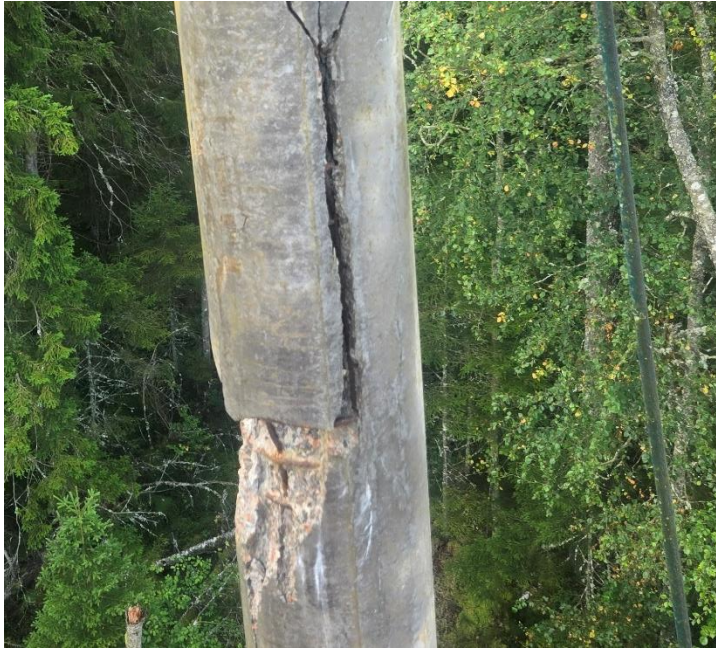
BILD 10. Pågående armeringskorrosion vid skadeområdet.
