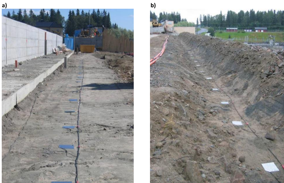
Figur 25. Elektrodlägg i Damm 3, a) krönutlägg, och b) nedströmsslänt (foto: Olof Lundborg).
