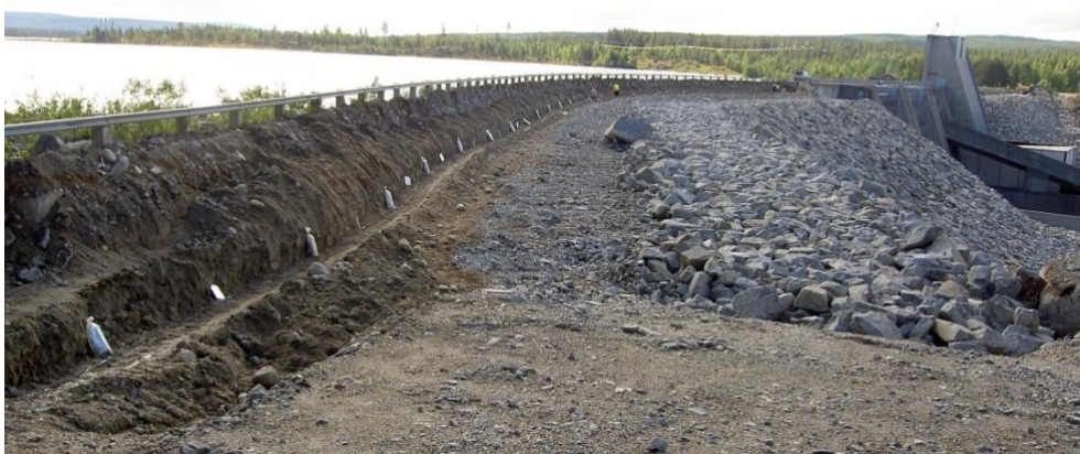
Figur 23. Förberedelse för elektrodinstallation i Damm 2, med elektroderna utplacerade med c/c 3,5 m i rätt positioner i längsled (foto: Pontus Sjö Dahl).
