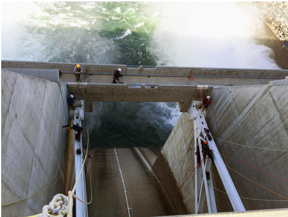
Figur 13. Installation av trådtöjningsgivare på luckben för kontroll av lucklager, foto från Bridge Diagnostics, Inc, BDI.
