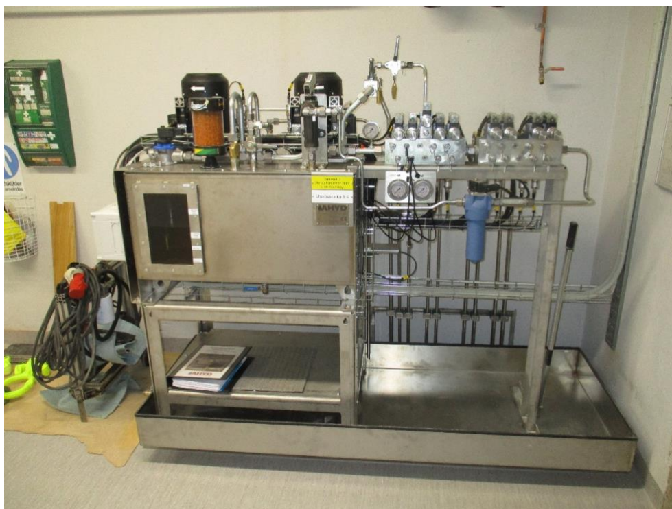
Figur 22. Exempel på hydraulaggregat för manövrering av mindre klaffluckor.
