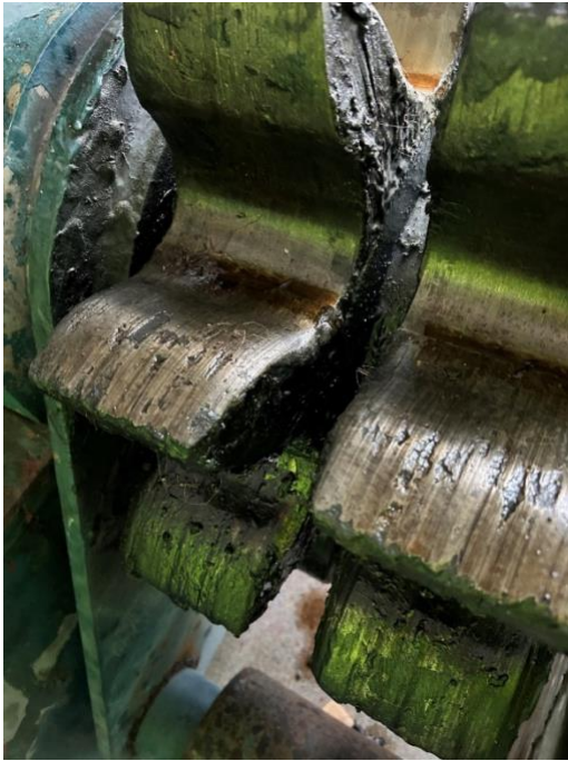
Figur 7. Pinnkuggdrev med ytdefekter i form av pitting,
