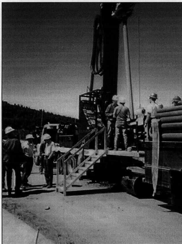
Figur 3 Borrhning med Sonic drill vid sjunkhål 1.
